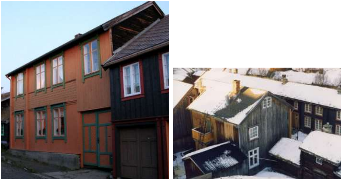
Fig. 2. Røros. Sleggveien 3. Til venstre: Hovedfasaden. Foto: J. Brønne 2006. Til høyre: Nord og østveggen. Nordveggen er fremdeles umalt, og «husmorvinduet» med løse sprosser står i hjørnerommet i 2. etasje not nordøst. Panelet på østveggen har spor etter tre generasjoner med, - og uten overflatebehandling. Sporene etter innbøtingen av østvinduet i 2. etasje er lett synlig. Foto: Berit Bakosgjelten 1995.
