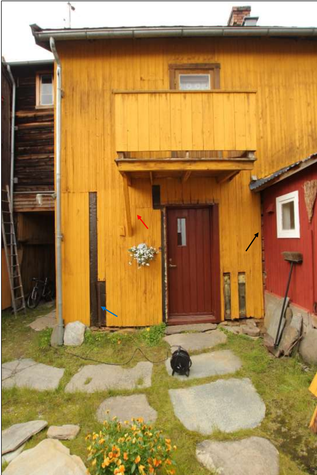
Fig. 5. Røros, Sleggveien 3. Sydligste del av østveggen med fjerde generasjon hovedinngangsdør og annen generasjon balkong og balkongdør. Diverse panelbord er fjernet for å kartlegge den bærende konstruksjonen, og de endringene som det er mulig å påvise. Til venstre synes stenderen som markerte syddavslutningen på det avkuttete hjørnet på østveggen. (Blå pil) Tømmerdelen av østveggens 1. etasje slutter rett til syd for den røde veggen i skjælet. (Sort pil) Dette er det nordligste punktet hvor den opprinnelige fløydøra kan ha stått. Resten av veggen helt bort til sydøsthjørnet er en stenderverksvegg. Innbøtingen av panelet syd for dagens hoveddør (Rød pil) markerer det sydligste punktet hvor den opprinnelige fløydøra kan ha stått. (Se også fig.9.) Foto: J. Brønne. 2014.
