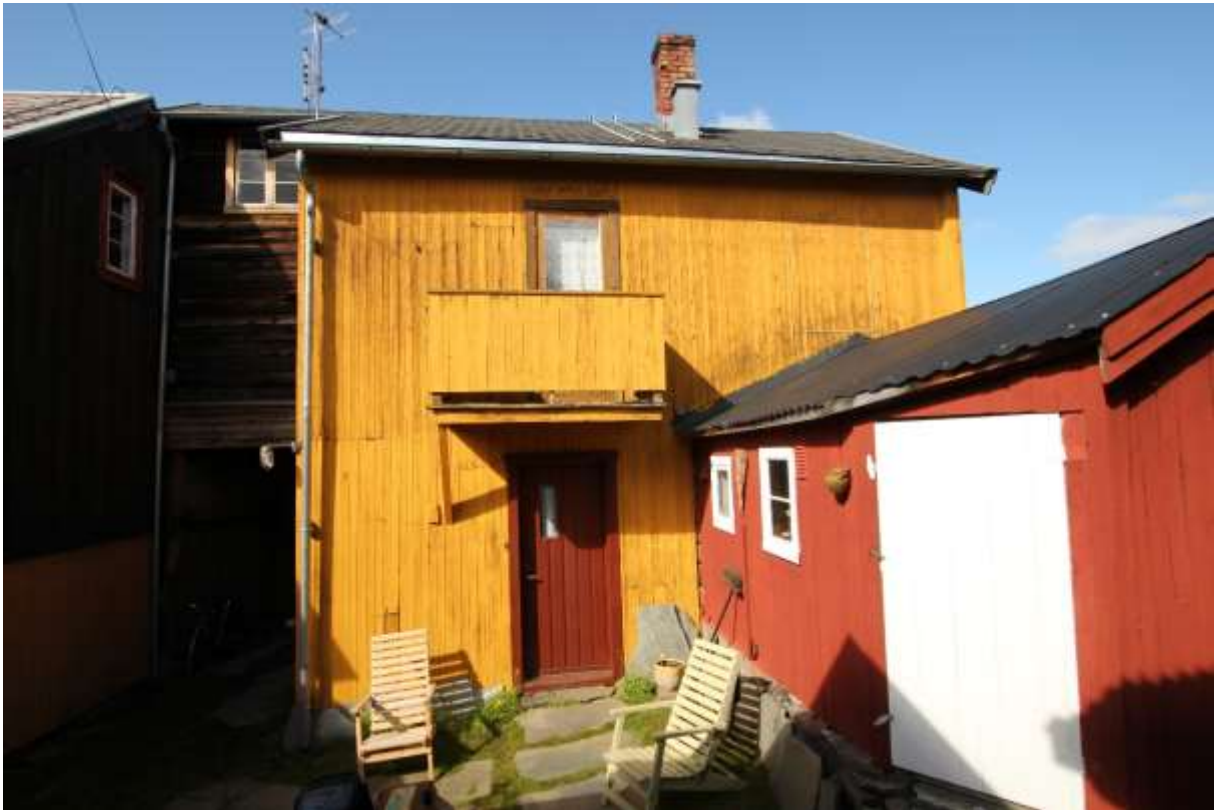
Fig. 3. Røros. Sleggveien 3. Østfasaden. Foto: J. Brønne 2014.
