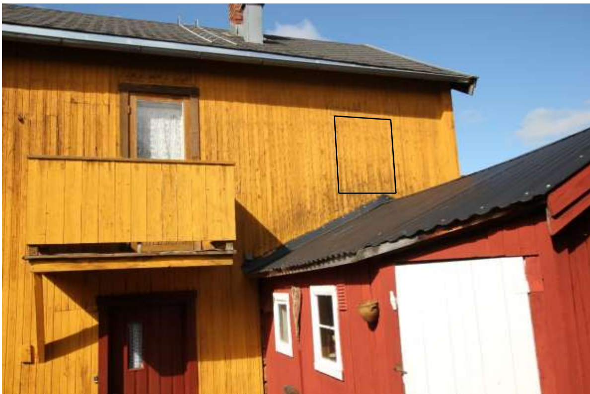
Fig. 7. Røros. Sleggveien 3. Nordlige del av østveggen, med snormarkeringen av åpningen etter det nordligste vinduet i veggen. (Sorte streker) Se også fig. 10. Foto: J. Brønne. 2014.
