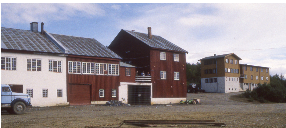
Killingdal gruver, bygningsmiljø ved Bjørgåsen. (Foto: B. I. Berg 1990)
