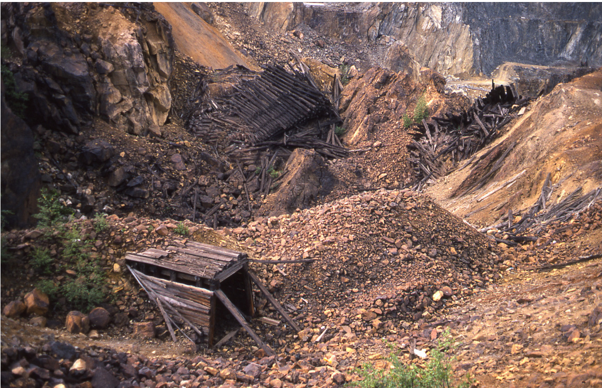
I "Stora Stöten" kan forbygning som muligens stammer fra før det store raset i 1687, ses fra dagoverflaten. (Foto: B. I. Berg 1978)
