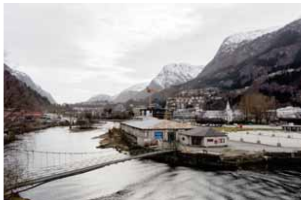
Utsikt fra taket på bygg 05 mot Almerket. Den fine hengebroen foreslås bevart og renovert som en del av strandpromenadens videreføring fra Torget ved turistinformasjonen og videre til Importkaia.
