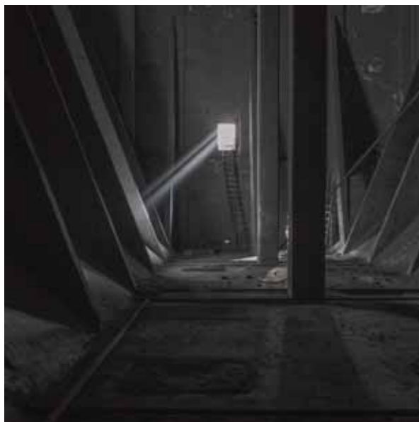
Mørket i Råcyanamidsiloen, bygg. 113
