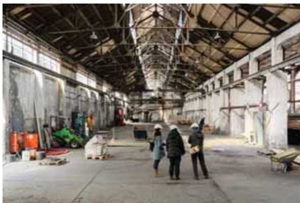
Synfaring i bygg. 105 og Cyanamiden- komplekset. Takreovering har begynt.
