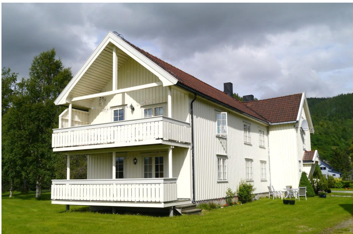
16530008061: Tapsandelen for våningshus og bolighus er lavere i 3. enn i 2. omdrev. En stor andel av bygningene er endret (64 %), noe som tyder på bruk og vedlikehold. Foto: ÅD/NIKU 2013
