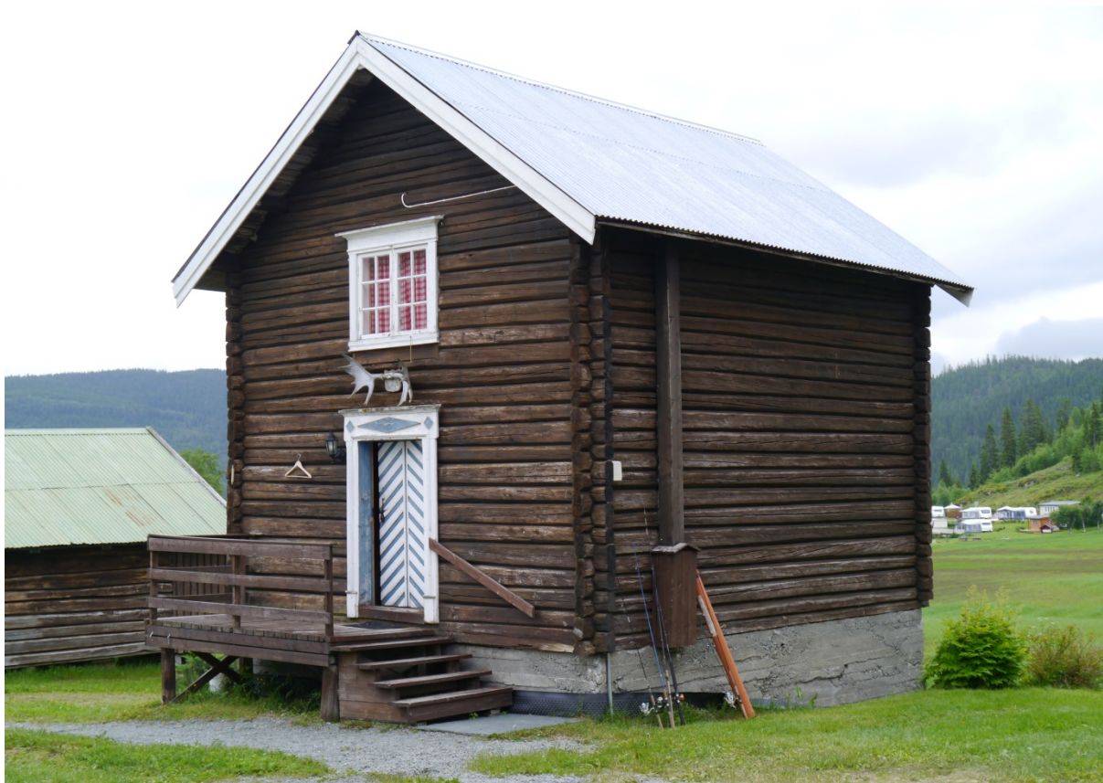
16530025024: Endring av bygningens overflater, som utskifting av panel, takbelegg, vinduer eller listverk, registreres som C-endring. Foto: ÅD/NIKU 2013
