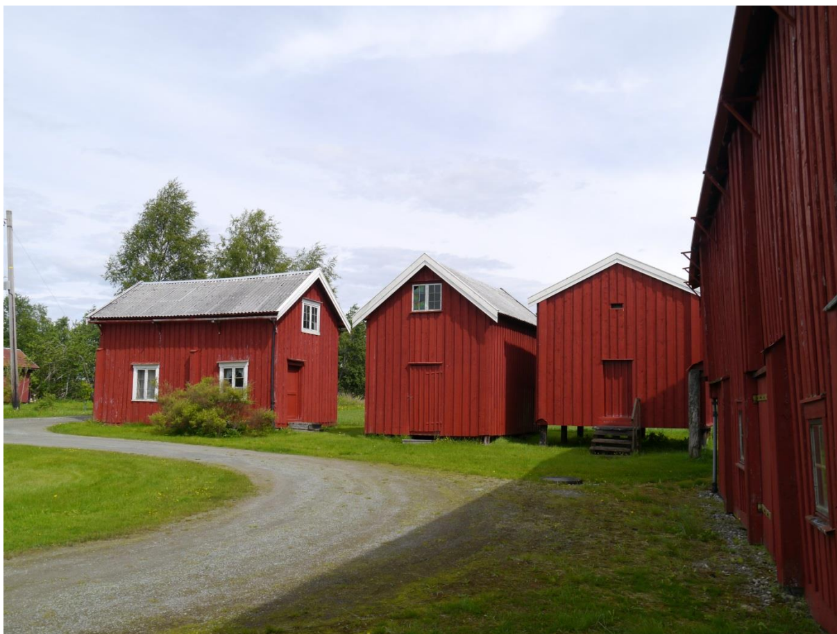
16530017005-007: Gården Tuvan ligger i et område regulert til hensynssone kulturlandskap, hvor ny bebyggelse ikke skal komme i konflikt med viktige kulturminne- eller kulturlandskapsinteresser. De tre SEFRAK-bygningene på gården er registrert som uendret og intakt gjennom alle tre omdrev av kontrollregistreringen. Foto: ÅD/NIKU 2013
