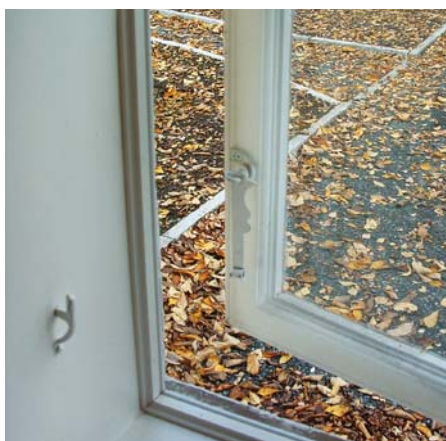
Foto av vinduer med glass hengslet direkte på ytre ramme uten egen ramme. Dette er svært lite synlig og dekker ikke til det gamle vinduets profiler. Det må monteres ei smal list med tettelist på innsiden, slik at den tetter godt mot det nye glasset og fuktig inneluft ikke kommer ut i mellomrommet mellom glassene. Det er mulig å bruke eksisterende lukkere og vindkroker, men dette må spesialbestilles. En slik løsning gir en u-verdi på anslagsvis 1,7-1,9, når det brukes energiglass. Dette er langt bedre enn et ordinært dobbeltvindu med vanlig glass (u-verdi 2,7), men dårligere enn et dobbeltvindu med energiglass (u-verdi 1,6). Kilde: Optiglas, Danmark.
