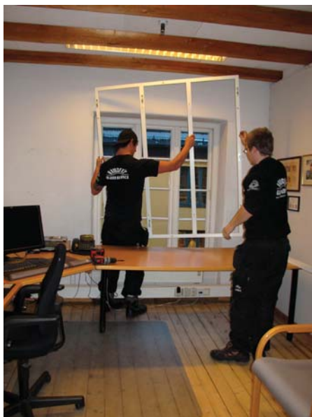
Montering av nye innervinduer i Riksantikvarens lokaler. U-verdien (isolasjonsevnen) forbedres fra cirka 4,6 til 1,6.
