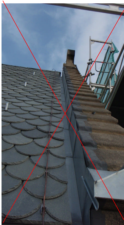
Bilde 2 Her er nedlederen lagt på samme bygg, motsatt side. Dette er ikke den peneste montasjen av disse to, men funksjonsmessig, helt grei.
