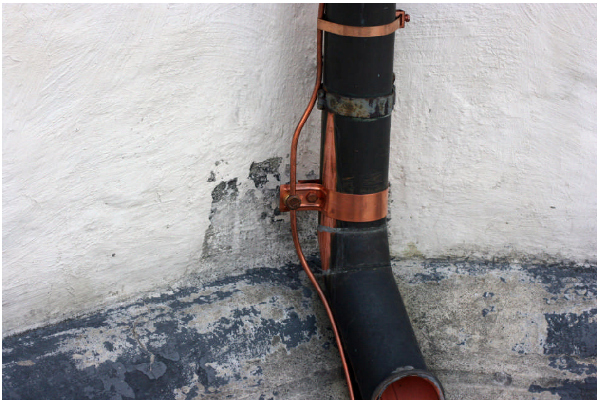
Bilde 10 Taknedløpsbeslag i kobber med innfesting for nedleder
