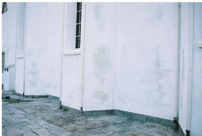
Fig. 5.4 Misfarging etter elektrokjemisk realkalisering
