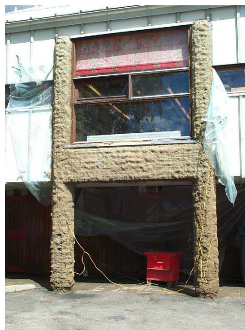
Fig. 5.2 Elektrokjemisk realkalisering i praksis
