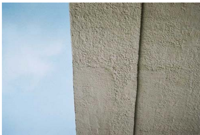
Fig. 4.2 Reparasjonsområde med annen overflatestruktur
