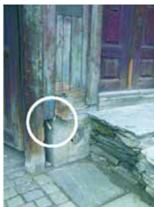
Brannvesenet kopler på vann til vanntåkeanleggene fra utsiden av bygningen. På bildet til høyre ser vi også hvordan vannrørene er ført inn på loftet. Foto: Anne Steen-Hansen.
