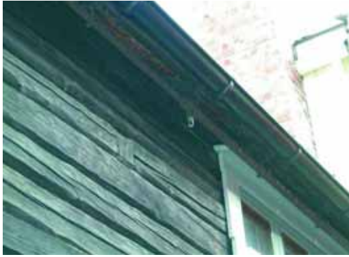
Fasadesprinkleranlegg kan forhindre at bygningen blir antent fra utsiden. Foto: Anne Steen-Hansen, Tommy Skålvoll.
