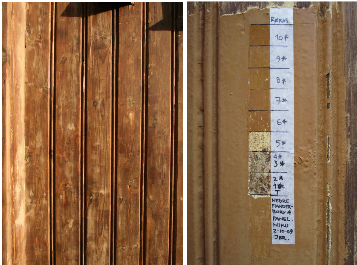
Figur 5. Til venstre. Nedre Flanderborg 4. Panelet på hovedfasaden etter at all maling var fjernet med varmluft. Foto: J. Brønne. Oktober 2009.
