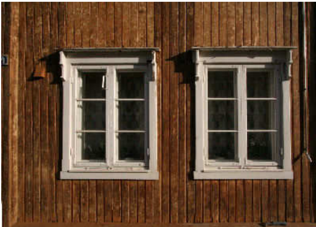
Figur 4. Nedre Flanderborg 4. Nyere vinduer, men opprinnelige vindusgeriker, vannbrett og konsoller. Foto: JBr 2.7.2009.
