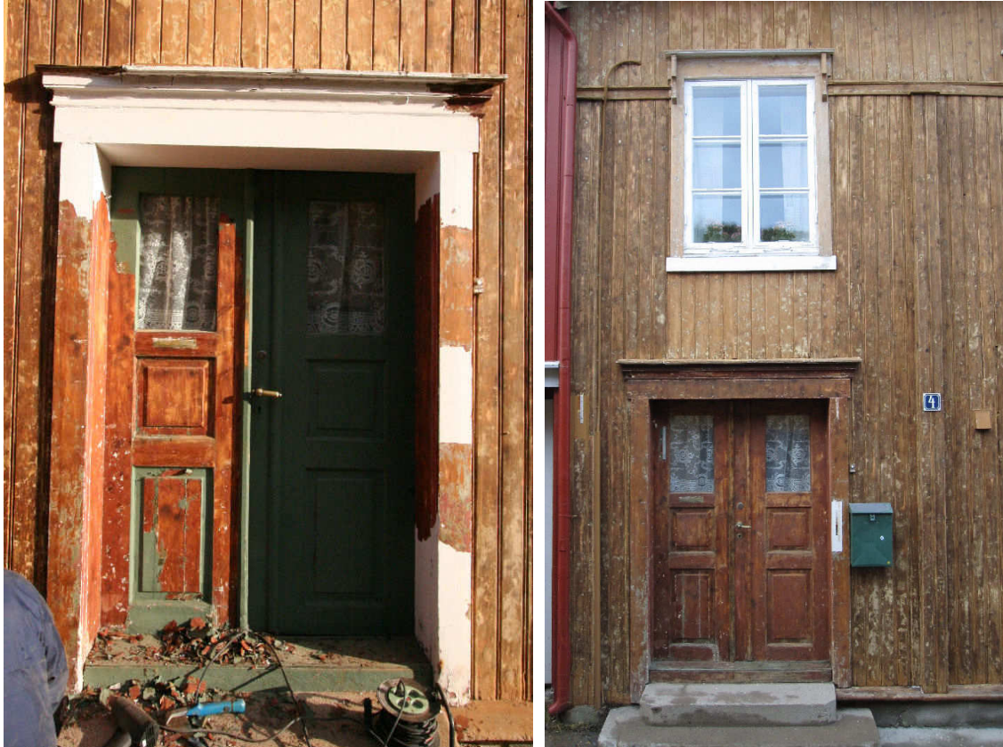
Figur 2. Til venstre. Nedre Flanderborg 4. Opprinnelig dør. Under arbeid med at malingen blir fjernet med varmluft. Foto: JBr 2.7.2009.
