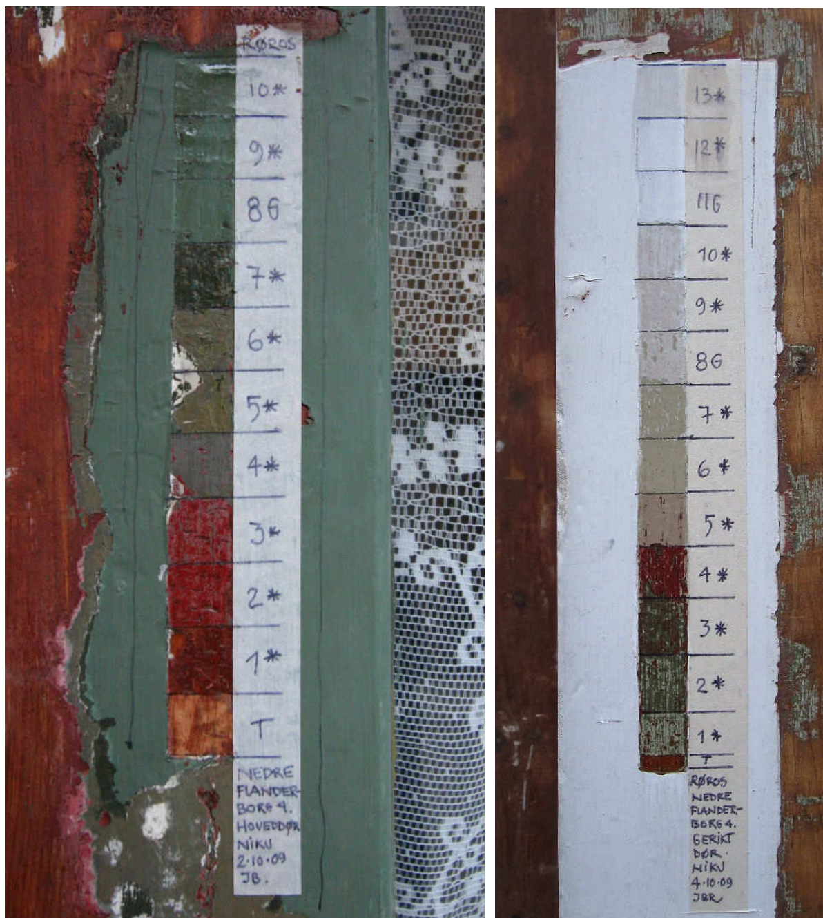
Figur 7. Til venstre. Nedre Flanderborg 4. Fargelagsavdekking på døra på hovedfasaden. T = Treverk. G = Grunningsstrøk. * = Avsluttende malingslag. Foto: J. Brønne. Oktober 2009.
