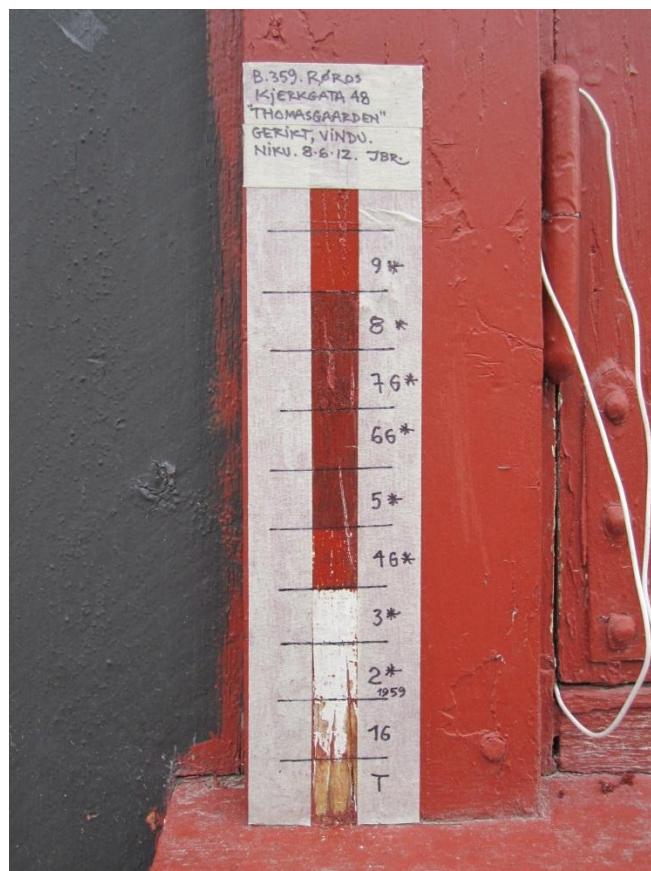
Figur 7. Lagvis avdekking av malinglagene på vindusgerikt. Foto: Brønne. Juni 2012.
