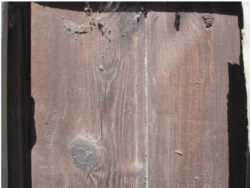
Figur 3. Samme panel som fig. 2. nederst på panelbordet. All maling er fullstendig avslitt. Det var ikke mulig å finne etter maling på denne delen av panelet. Foto: Brønne. Juni 2012.
