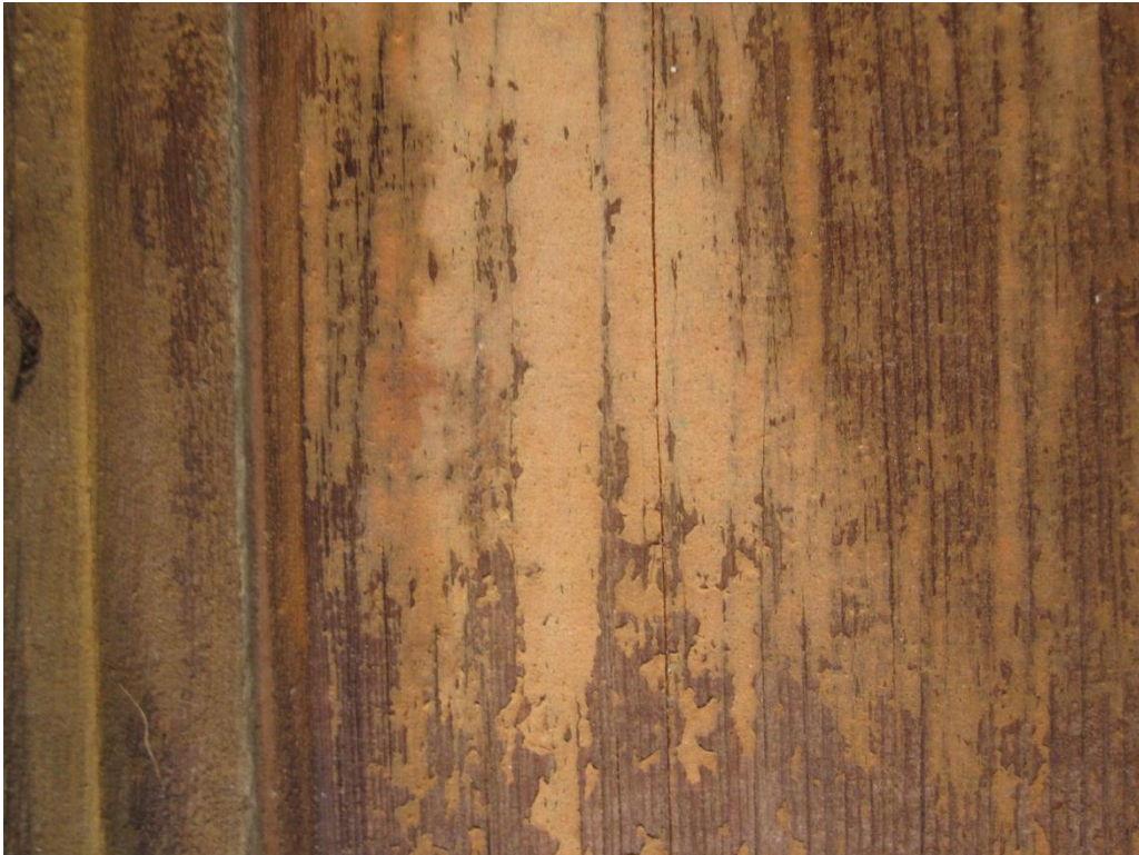
Figur 2. Eieren demonterte noen av panelbordene fra 1959. Under dette panelet var panelet fra før 1902 bevart. Bildet viser detalj av dette panelet, oppe under takskjegget. Dette er det panelet som vises på Harald Sohlbergs maleri fra 1902. Rester av blek oker maling. På resten av veggen er malingen fullstendig avflasket og forsvunnet. Foto: Brønne. Juni 2012.
