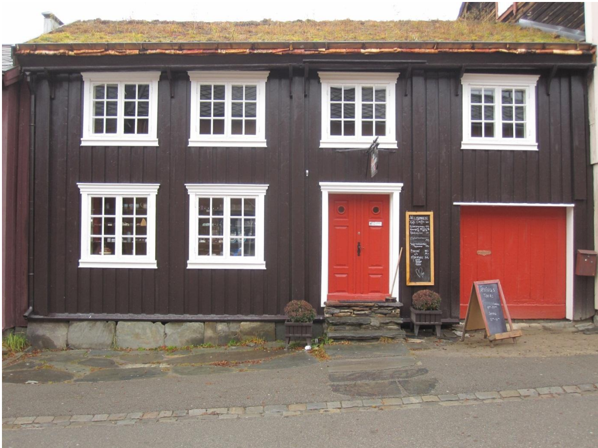
Figur 8. Kjerkgata 48. Thomasgaarden etter oppmaling. Foto: Brønne oktober 2012.
