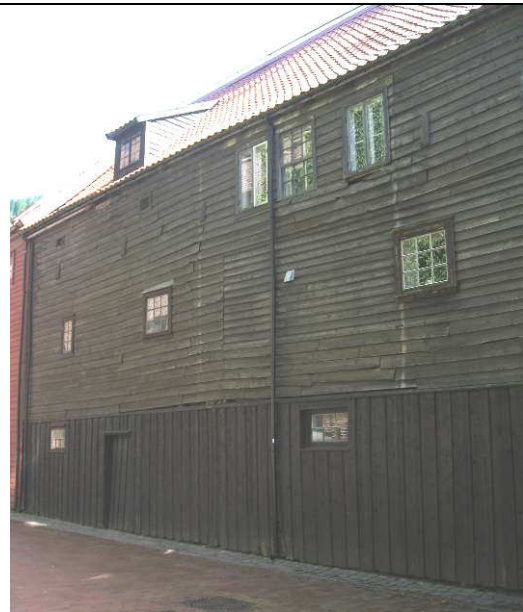
Bredsgården IC fasade mot nord, sett mot øst.
