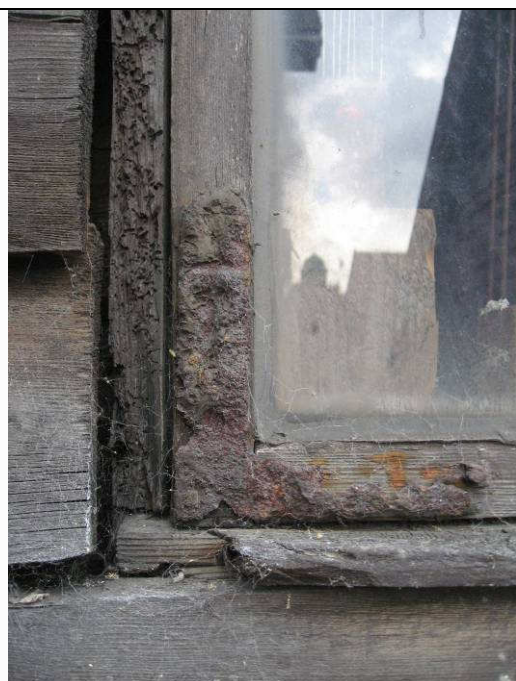
Detalj fra vindu
