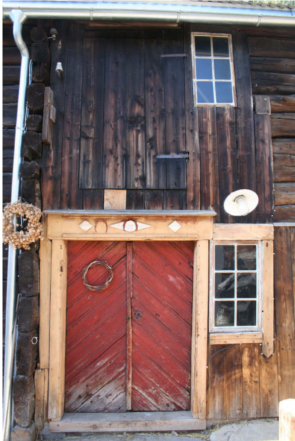
Figur 1. Mørkstugata 14. Dør, dørørramming og vinduer.
