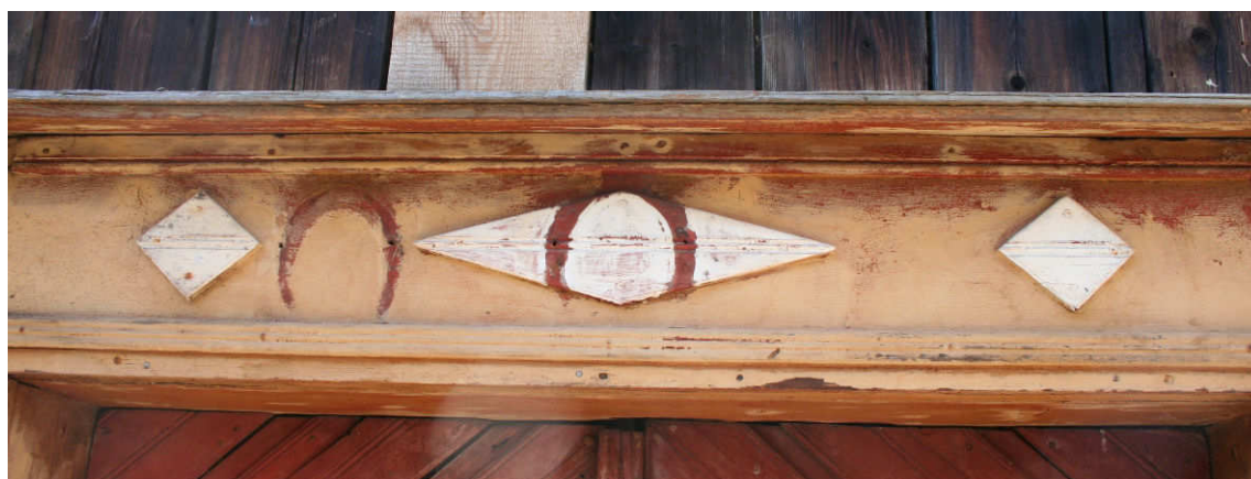
Figur 3. Mørkstugata 14. Detalj av dørøverstykket som viser opprinnelig farge under de negative sporene etter hesteskoene. Foto: J.B. 5.6.2008.
