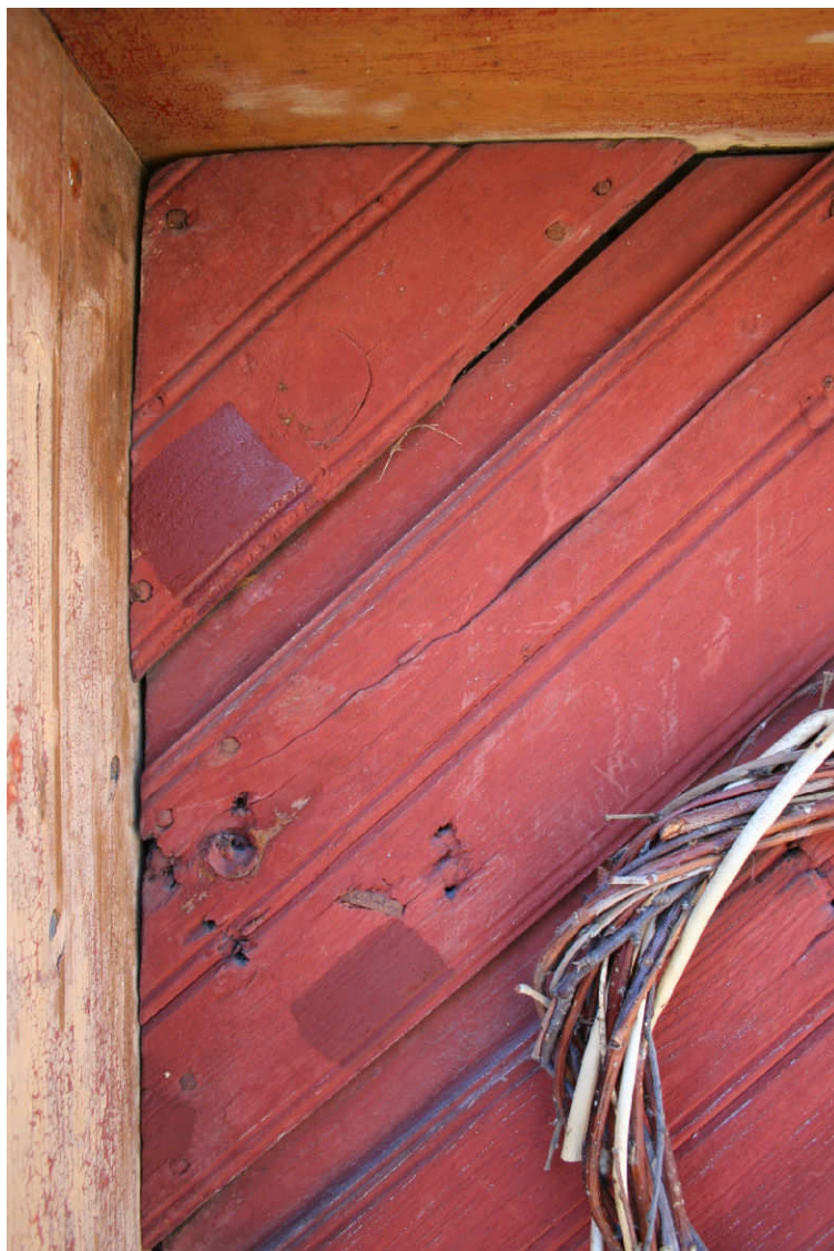
Figur 2. Mørkstugata 14. Dør med ferniss- og oljeprøver for å regenerere malingen og fargen. Foto: J.B. 5.6.2008.
