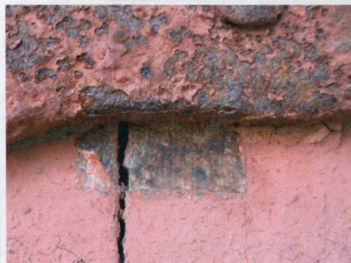
Under det nederste beslaget på dør 4 var det rester av maling bevart.
