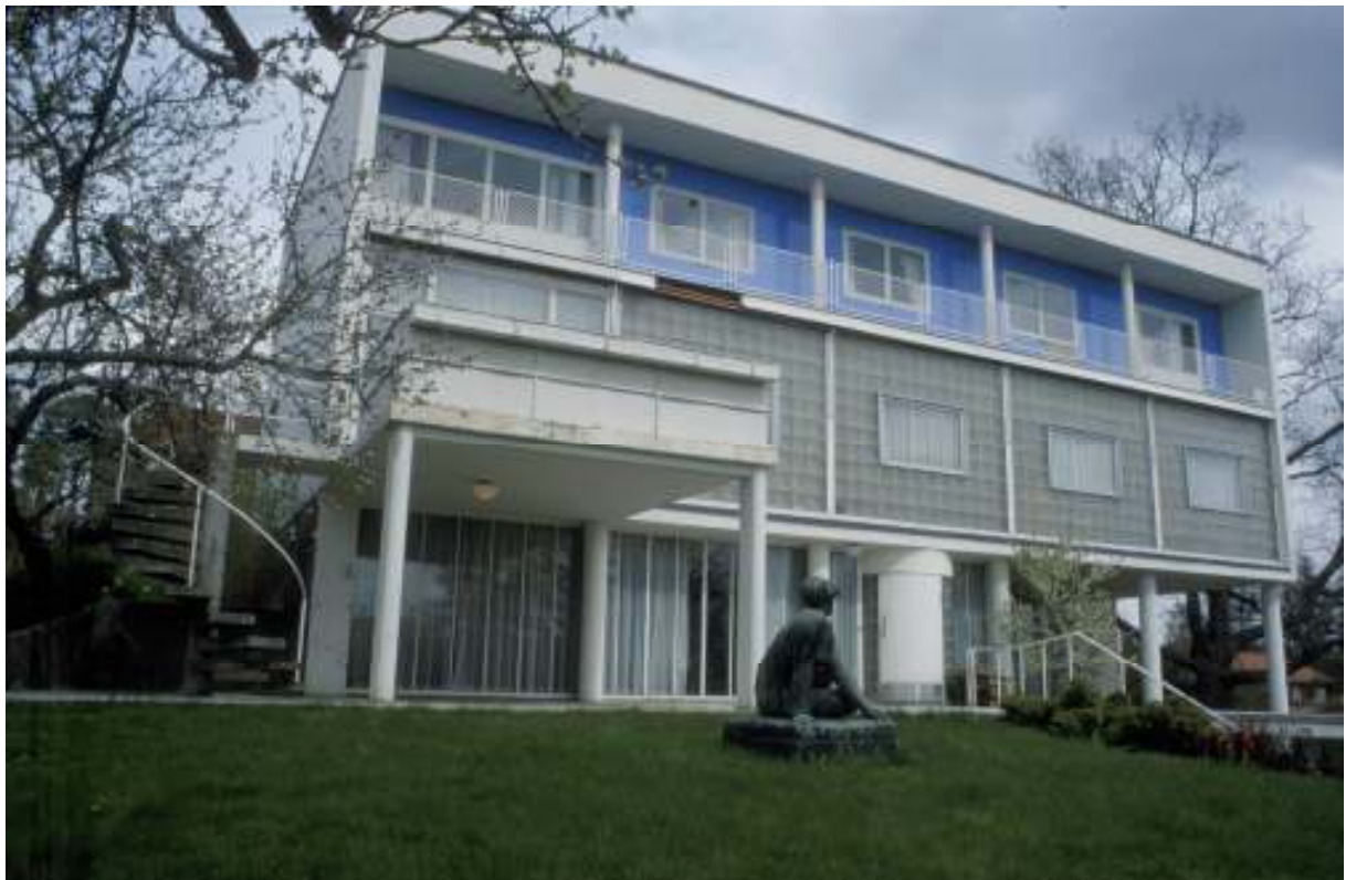
7 Villa Stenersen, 1997. Foto: Harald Ibenholt, Riksantikvaren
