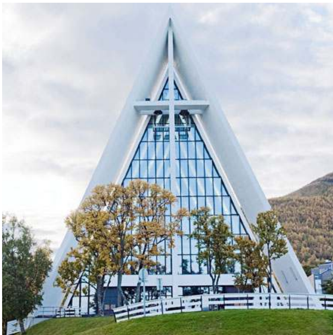
20 Tromsdalen kirke etter bytte av glass. Foto: Glassmester Appelbom.
