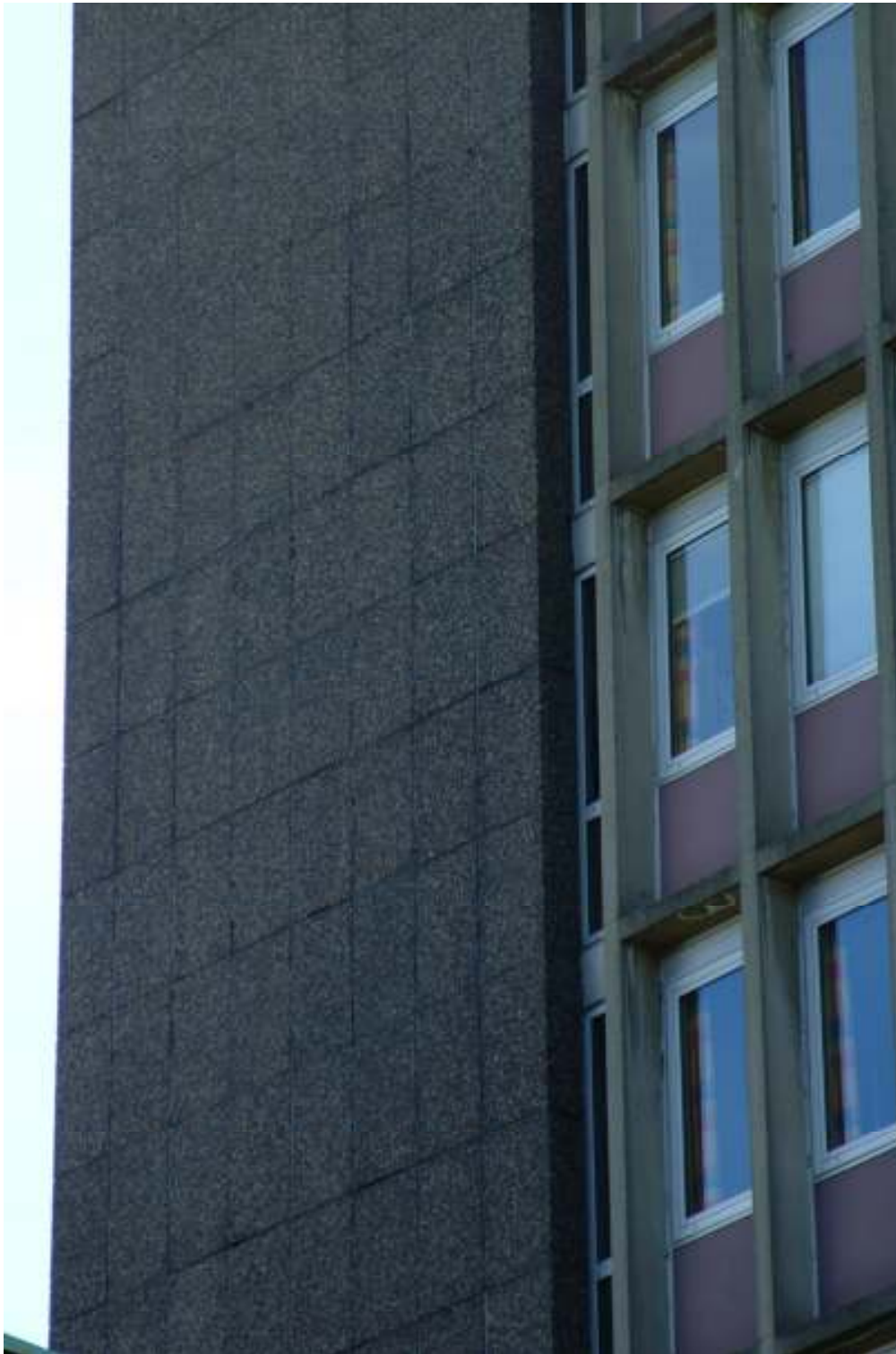
17 Fasade før rehabilitering. Foto: Eirik T. Bøe, Riksantikvaren, 2001
