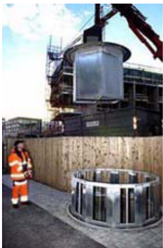
Figur 3-12 Installasjon av brannsikre søppelbeholdere Foto: Adresseavisen.
