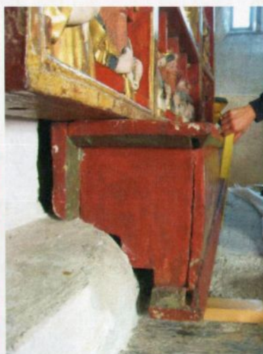
Midtre alterskap. Predella og nedre del av alterskapet. En av de to klossene som var lagt under predellaen er snudd. Legg merke til at døren er klemt ned på predellaen. Foto: TMO 2007
