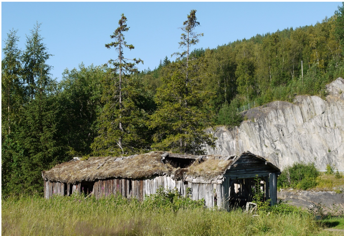
18400206012: Vedlikehold av bygninger medfører små og store endringer. Kontrollregistreringen viser at det er en gjennomsnittlig større andel av de uendrete enn de endrete bygningene som er registrert som truet og sterkt truet. Denne utløa har lenge vært ute av bruk og er registrert som uendret og sterkt truet i 3. omdrev. Trærne på torvtaket har vokst, og deler av vegger og tak er sammenrast. Foto: ÅD, NIKU 2012.
