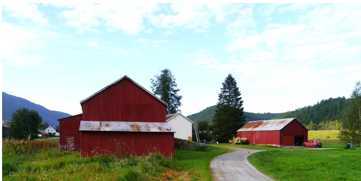
18400113022: I Saltdal kommune har kontrollregistrering av SERFAK-bygninger blitt gjennomført i 2002, 2007 og 2012. SERFAK-bygningene på Volden i Medby krets er registrert som intakt gjennom alle tre omdrev, fjøset er uendret og våningshuset er under istandsetting og registrert med minste endringsgrad. Foto: MSS, NIKU 2012.
