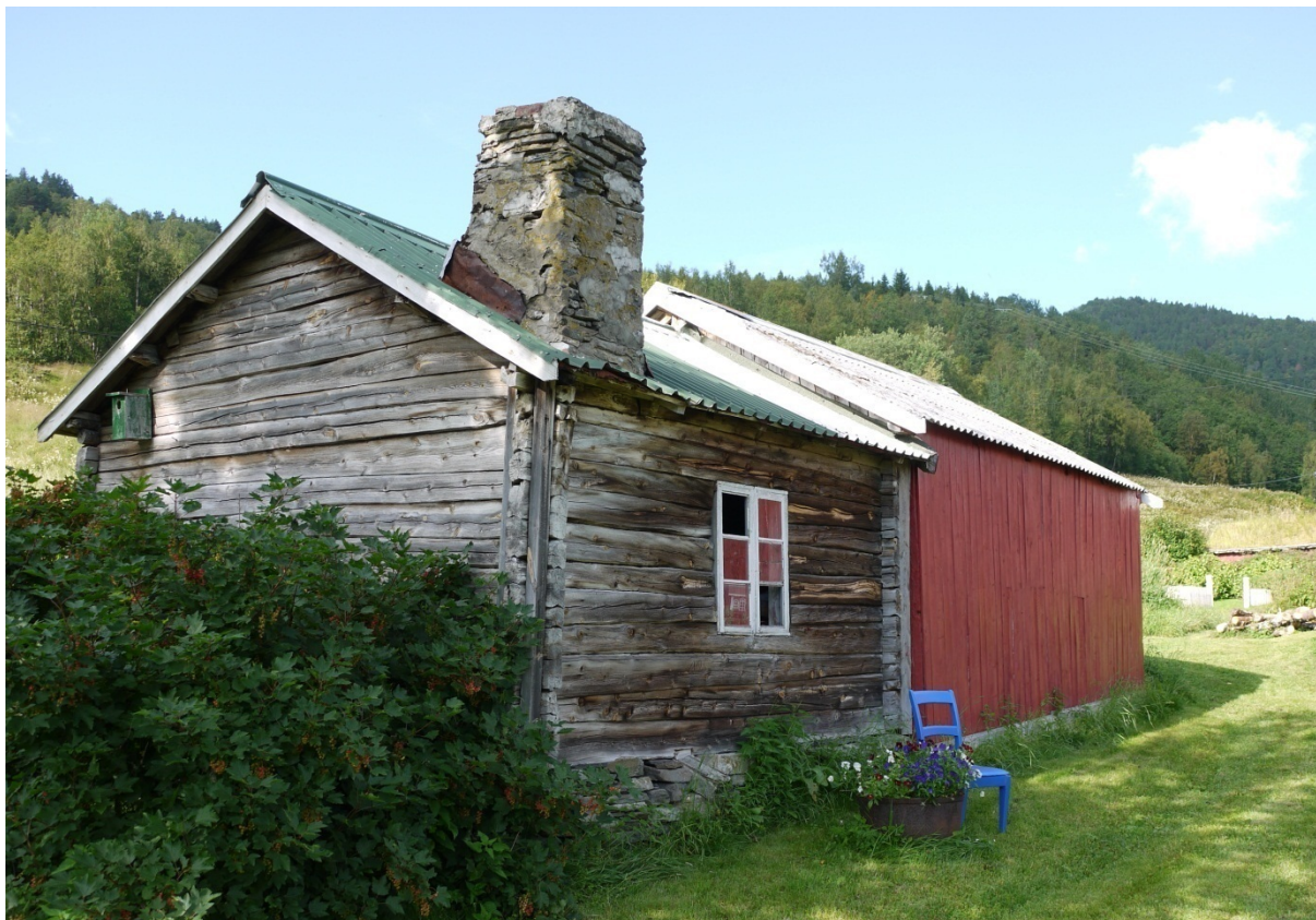
18400110036: 66 % av de gjenstående bygningene i 3. omdrev er uendret, mot 70 % i 2. omdrev og 80 % i 1. omdrev. Dette eldhuset i Saksenvik krets er registrert som uendret og intakt gjennom alle omdrevene. Foto: ÅD, NIKU 2012.
