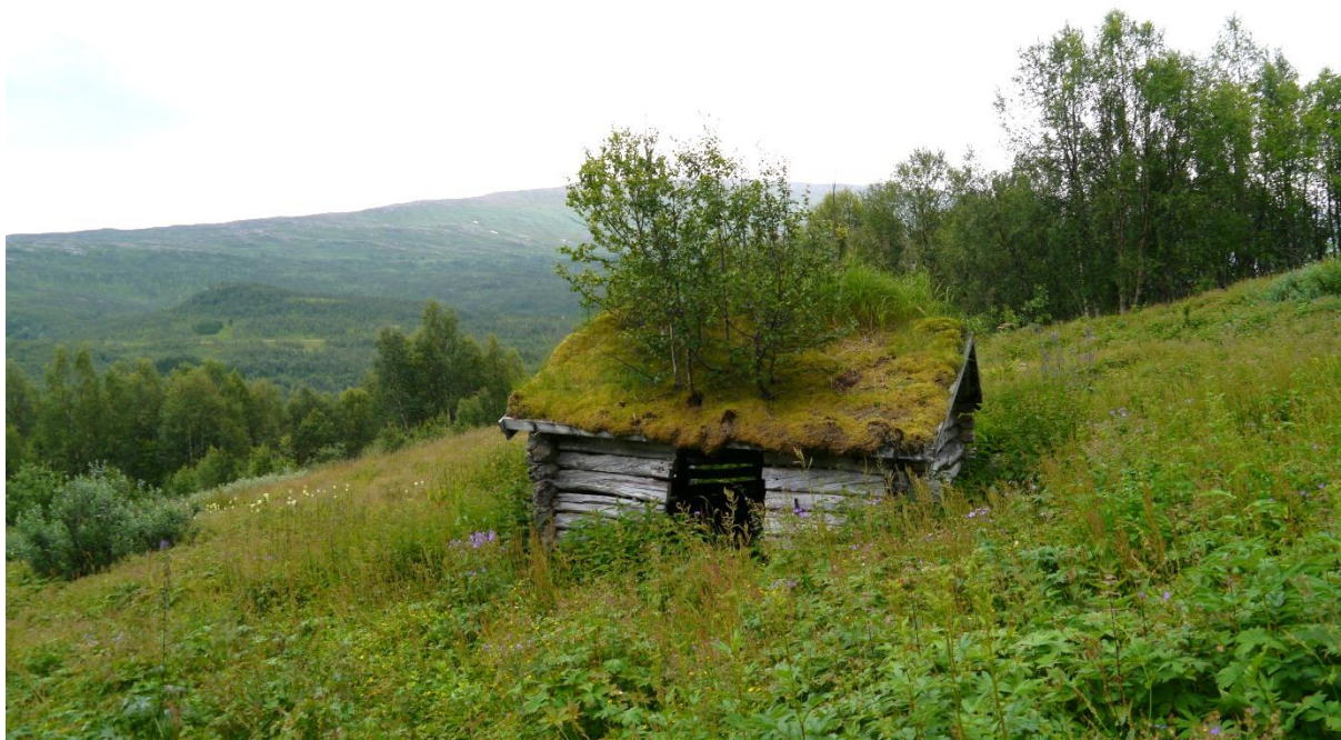
18400202023: Som i 1. og 2. omdrev av kontrollregistreringen er det utmarksbygningene som har den høyeste andelen truete og sterkt truete bygninger (til sammen 31 %). Dette er alarmerende fordi denne bygningsgruppen har hatt høyest tapsandel i alle omdrev, og de gjenstående etter 3. omdrev utgjør kun 5 % av alle SEFRAK-bygningene i Saltdal kommune. Foto: FC, NIKU 2012.
