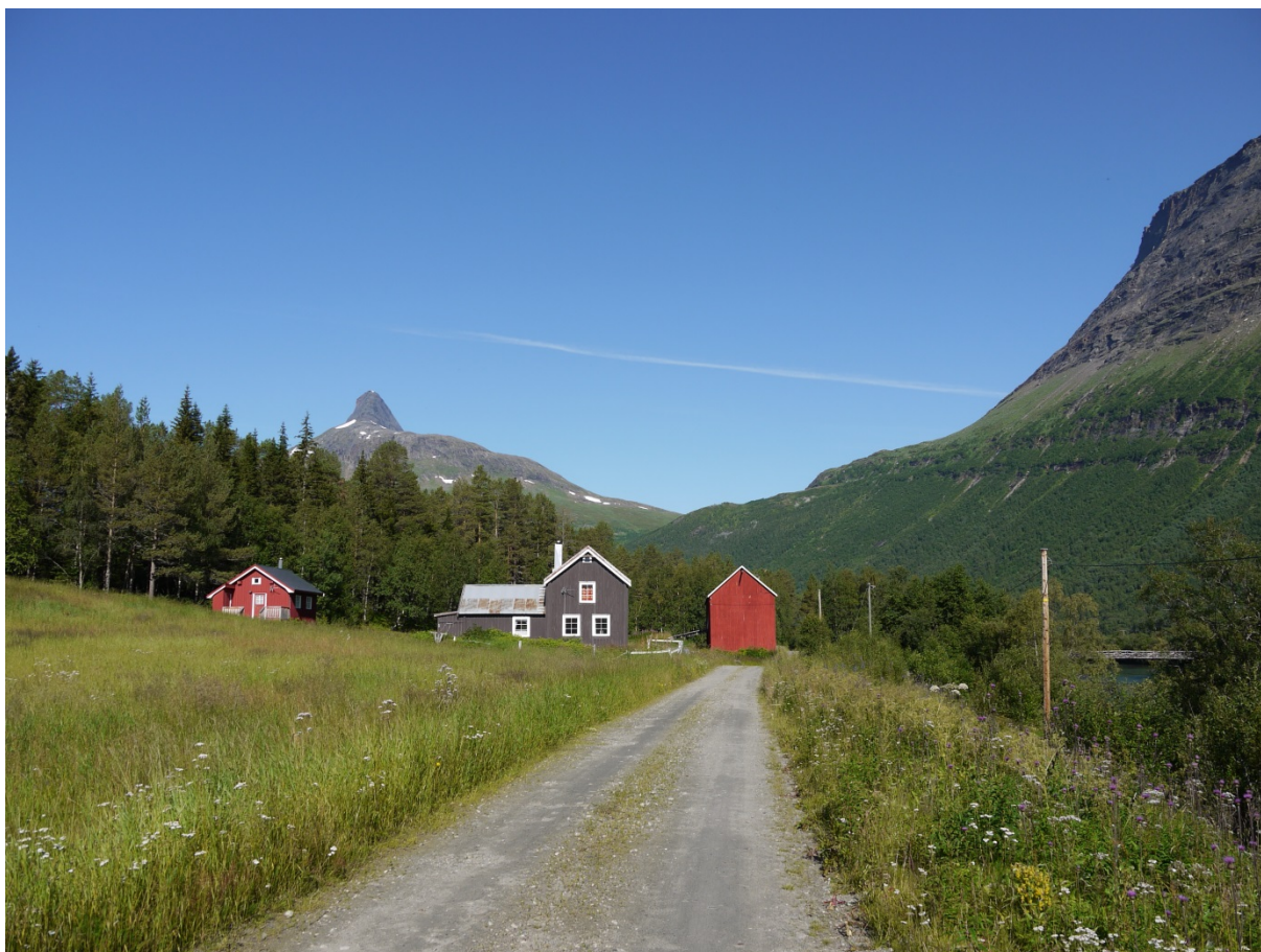
18400203101: Saltdal har fra gammelt av vært en utpreget jord- og skogbrukskommune. 96 % av de undersøkte SEFRAK-bygningene i kommunen i 3. omdrev har opprinnelig vært knyttet til landbruk, fiske og fangst, slik som dette gårdsbruket i Junkerdalen. Foto: ÅD, NIKU 2012.
