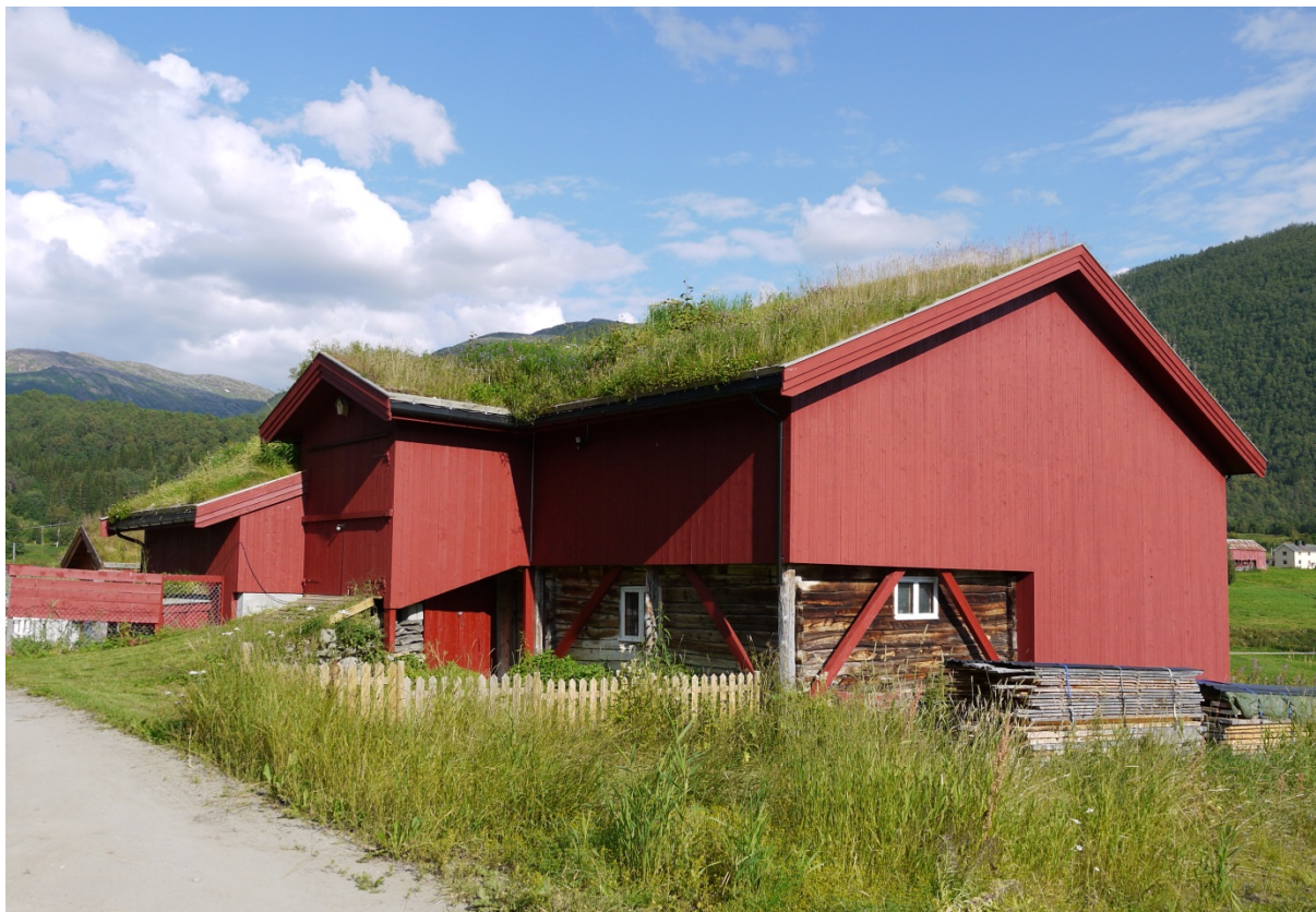
18400110055: I 3. omdrev er 12 % av SEFRAK-bygningene i Saltdal registrert som middels endret, det vil si liten volumendring. Denne driftsbygningen i Saksenvik krets er istandsatt med ny fasadekledning, og takplater er skiftet ut med torv. I tillegg er det gjort noen mindre volumendringer. Foto: ÅD, NIKU 2012.
