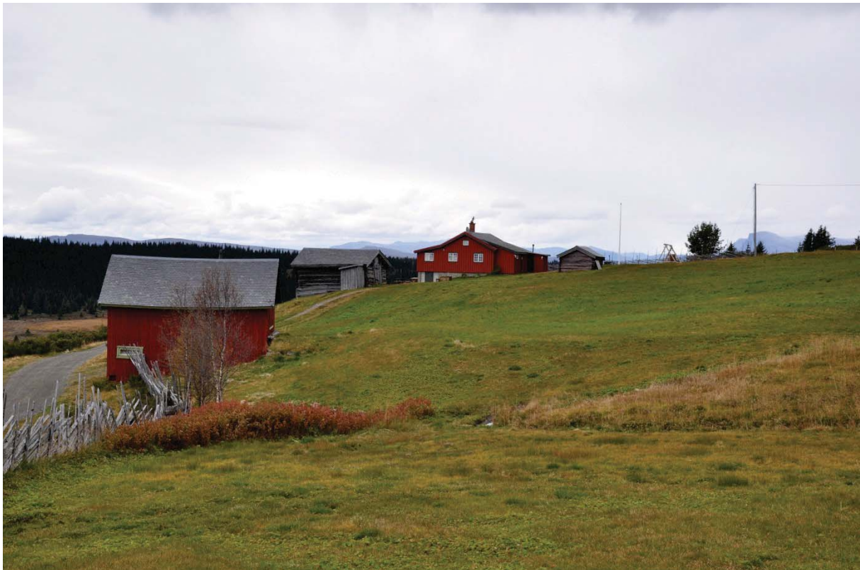
05420004162: 89 % av de undersøkte bygningene i Nord-Aurdal ligger i spredtbygde strøk, blant annet i de mange seterområdene.
