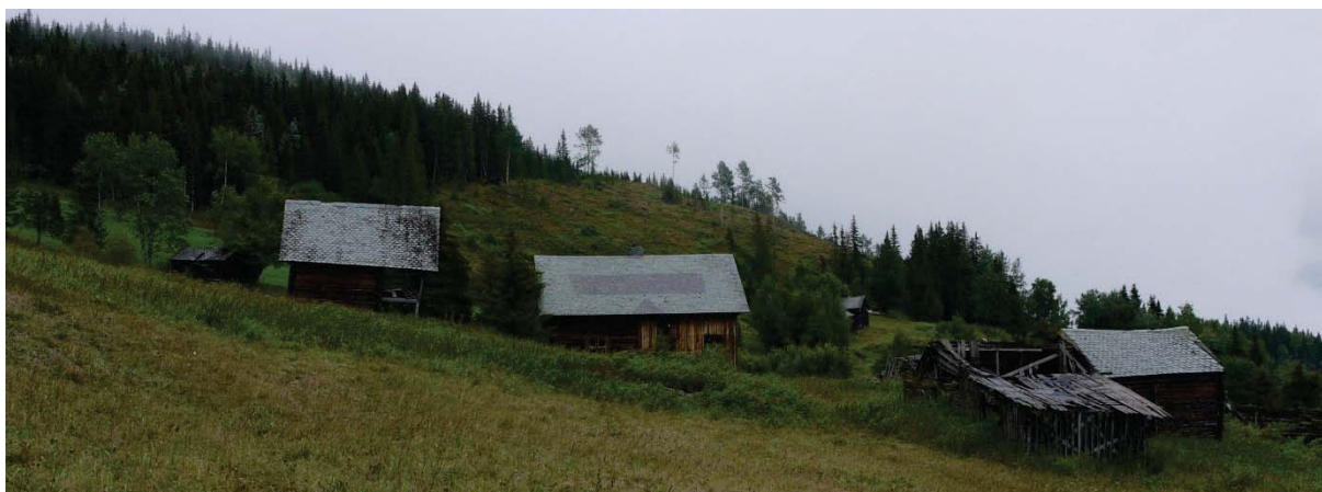
05420008008: Fraflyttete tun på vanskelig tilgjengelige steder høyt oppe i dalsidene er truet av forfall.
