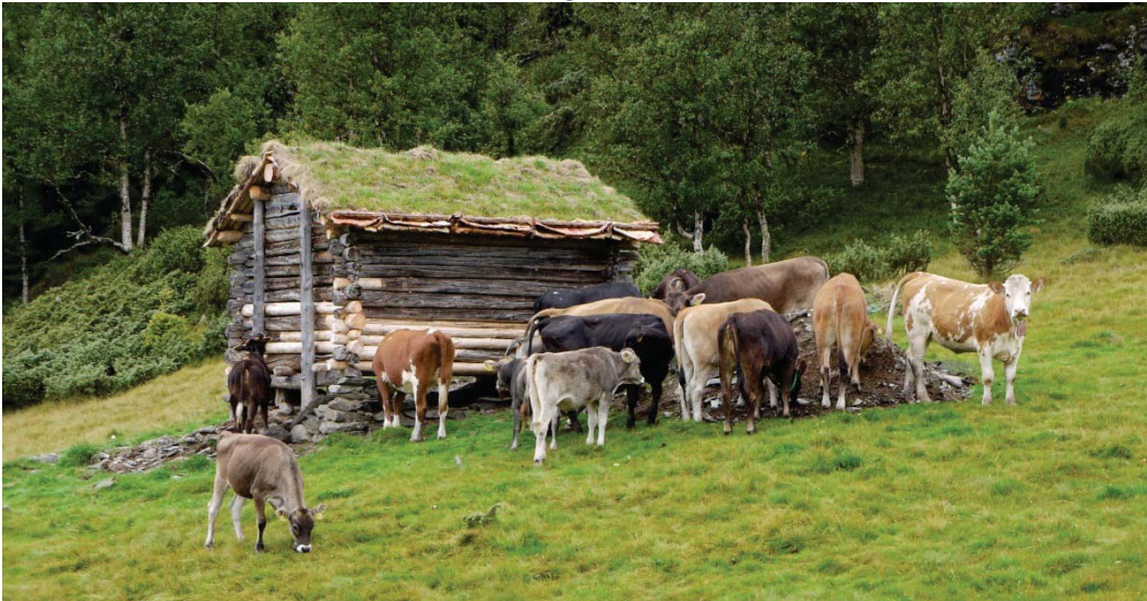
05420004132: Heimåsløe i Svenes. Bygningen er tidligere registrert som tapt, men har gjenoppstått i 3. omdrev.
