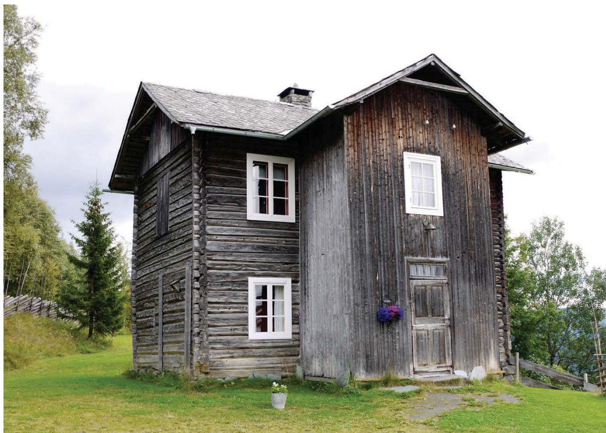
05420012129: Av de ulike bygningstypene har det vært flest tap av våningshus i 3. omdrev, men tilstanden for de gjenstående våningshusene er bedre enn gjennomsnittet i Nord-Aurdal.
