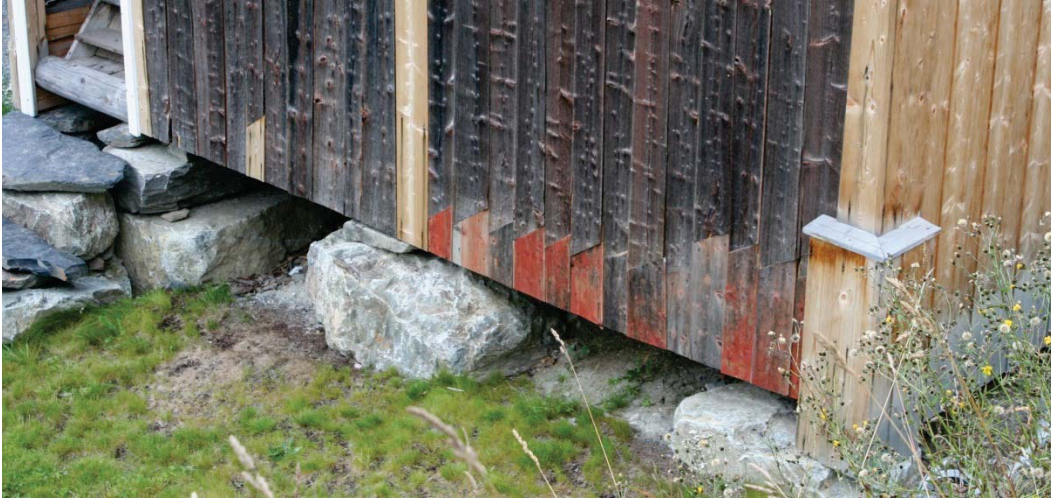
05420012162: Istandsatt stabbur i Skrautvål. Endringene er dokumentert stilhistorisk tilbakeført.
