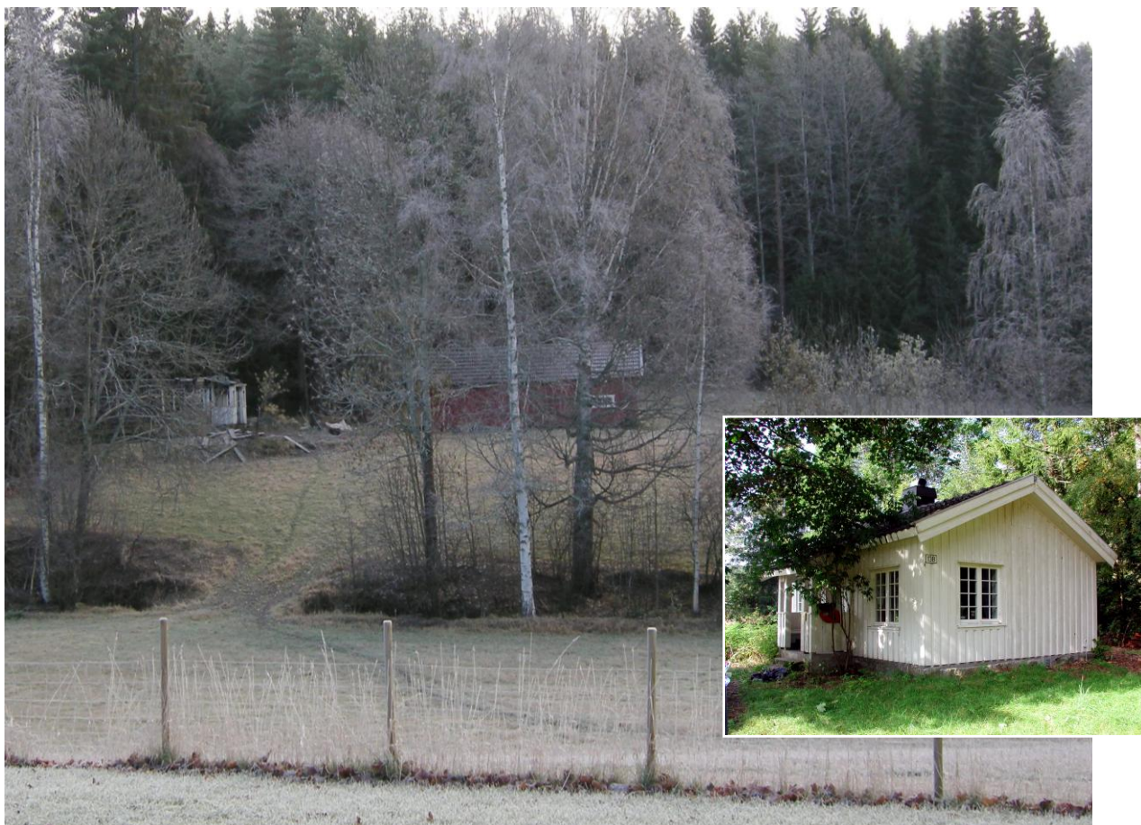
Stuebygningen på "Su-Roe" ligger i skogbrynet et steinkast unna hovedgårdens tun og skal ha vært husmannsplass. Den var ikke i bruk ved registreringen i 1984, men ble siden satt i stand med bl.a. nytt tekke og var ved 1. omverv brukt til utleie (innfelt foto). For noen år siden ble huset nær totalskadd ved brann – deler av veggene står, men taket er rast sammen. Det er planer om å sette det opp igjen slik det var, men uten tak inngår det som tapt ved 2. omverv. (0821-006-005)
