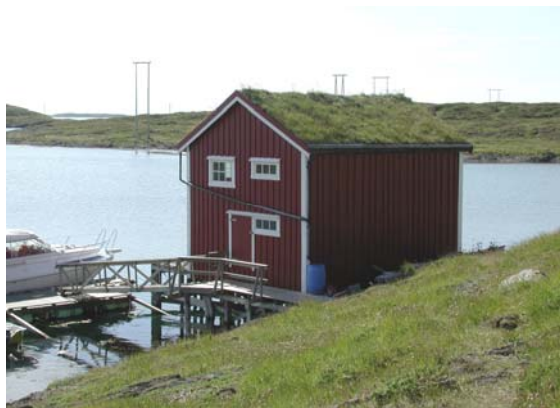
1815-0111-056. Brygge på Naustberge, Skogsholmen. Brygga er nå i feriebruk – noe den også bærer preg av. Utbygget er revet, bølgeblikk er skiftet ut med torvtak og det er satt inn flere vinduer. Da utbygget har en viss størrelse er endringene klassifisert som endringstype B.
