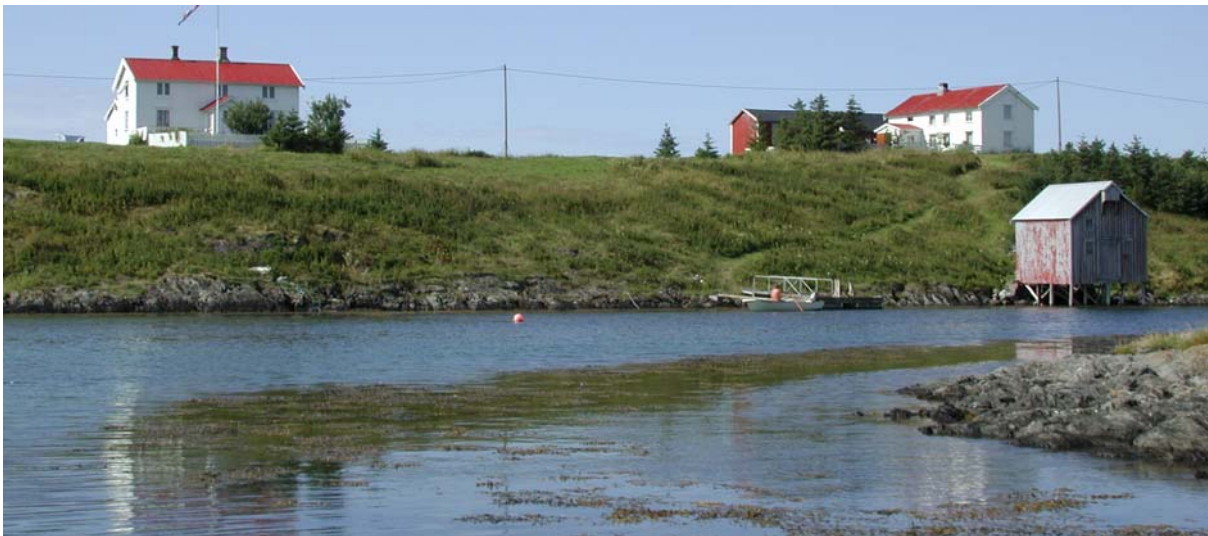
1815-111-025, 029, 030, 031. Fiskerbondens hus på Kilvær, delområde Vegaøyan. Begge bruk er tatt i bruk som feriesteder. Den registrerte bygningsmassen består av to våningshus, fjøs og uthus. Den lille brygga i forgrunnen er ikke registrert. Bygningene holdes ved like, og det er ikke gjort store endringer.
