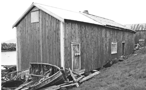
1815-0110-080. Fra Skjærvær – huset fikk sin størrelse på 1930-tallet da det ble utvidet mot nord. Ca. 1960 ble torvtaket på sørdelen skiftet ut med eternit, samtidig ble bordkledning og vinduer skiftet. Etter registrering i 1992 er det "tilbakeført" og har igjen fått torv på sørdelen. Siden MOV-undersøkelsen tar utgangspunkt i huset slik det var ved SEFRAK-registreringen, er endringene under tvil klassifisert som endringstype C.
