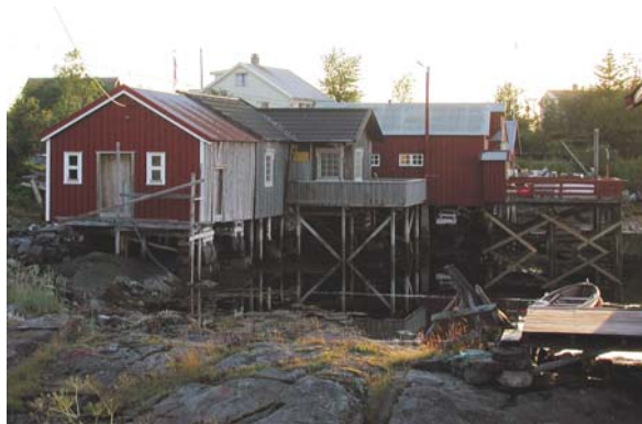
1815-108-074. Naustet ved Holandsjøen har blitt tilpasset ny bruk. Naustdørene er skiftet ut og flere vinduer satt inn, eternitbølgene på taket er skiftet ut med taksteinsplater og den lille kaia har fått rekkverk, i tillegg er det noe utvidet. Endringene er klassifisert som endringstype B.
