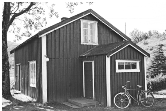
1815-103-001. Gammelstua på et av Gulsvågbruka, var ikke i bruk ved SEFRAK-registreringen. Tilstanden var da begynt å bli dårlig, og den ble siden revet. Et nytt bolighus står på stedet. Den gamle driftsbygningen på bruket var for lengst revet.
