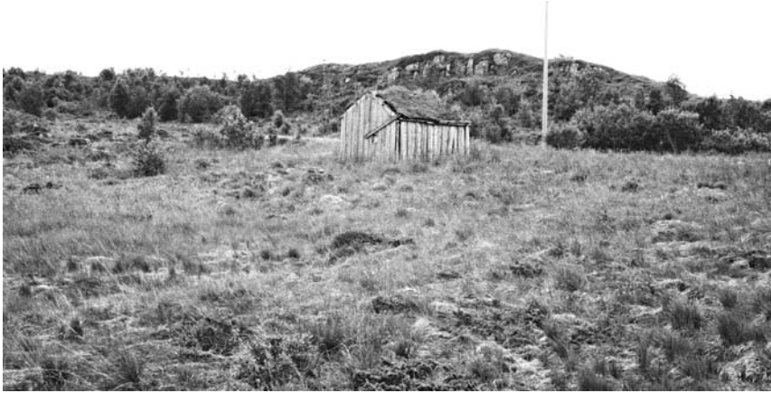
1815-108-091. Sommerfjøs på Grøtland. Det var ikke i bruk ved SEFRAK-registreringen, og har siden falt sammen. Det var få sommerfjøs som sto tilbake ved registreringen, og nesten alle er borte i 2003.
