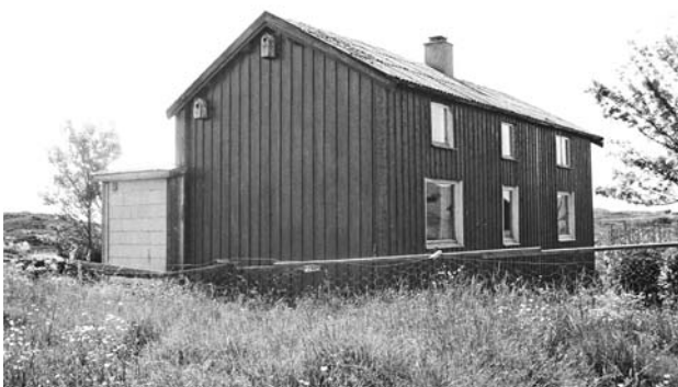
1815-103-01. Våningshuset skal iflg. SEFRAK være bygd på 1780-tallet. Det var i god stand ved SEFRAK-registrering, men sto tomt, og har siden gått tapt i en brann. "Bolighus/våningshus" har den laveste tapsprosenten i Vegamaterialet.
