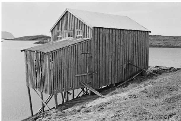
1815-0111-056. Brygge på Naustberge, Skogsholmen. Brygga er nå i feriebruk – noe den også bærer preg av. Utbygget er revet, bølgeblikk er skiftet ut med torvtak og det er satt inn flere vinduer. Da utbygget har en viss størrelse er endringene klassifisert som endringstype B.
