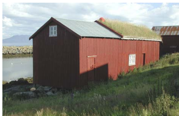
1815-0110-080. Fra Skjærvær – huset fikk sin størrelse på 1930-tallet da det ble utvidet mot nord. Ca. 1960 ble torvtaket på sørdelen skiftet ut med eternit, samtidig ble bordkledning og vinduer skiftet. Etter registrering i 1992 er det "tilbakeført" og har igjen fått torv på sørdelen. Siden MOV-undersøkelsen tar utgangspunkt i huset slik det var ved SEFRAK-registreringen, er endringene under tvil klassifisert som endringstype C.
