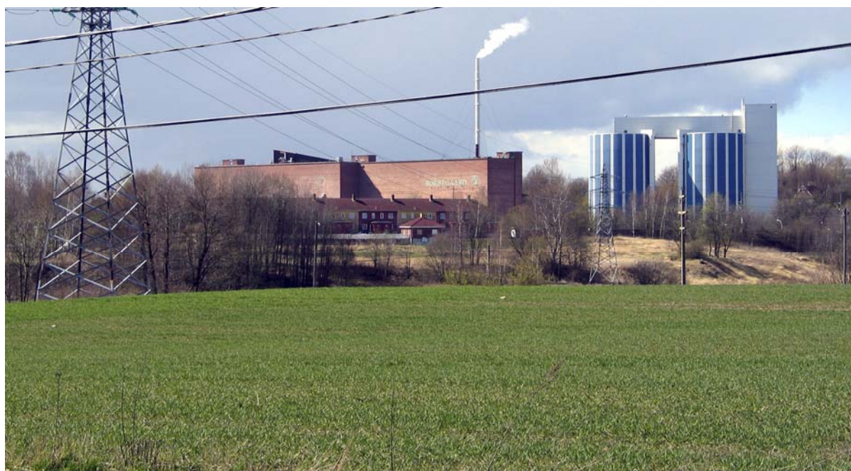
105-0203-053. Fra Borregaard. Den gamle arbeiderbrakkka Tarris i forgrunnen, bak produksjonshus fra 1900-tallet. Tarris er 100 meter lang, og ble bygd med 40 leiligheter. Den het Foster Terrace da den ble bygd, men det engelske navnet er forlengst glemt av de fleste. Bygningskroppen er fortsatt den samme. Inngangspartiene har imidlertid fått nye tilbygg. De gamle inngangspartiene ble revet i 1936 og nye bygd. Tilbygget ga bl.a. plass til WC.
