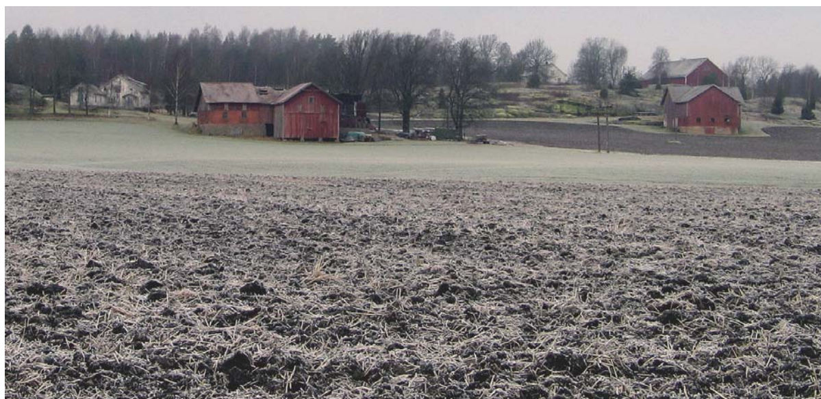
105-1404-010, 013. Den eldste driftsbygningen forfaller, driftsbygningene til høyre er bygd på 1900-tallet. Kulturlandskapet holdes i hevd.
