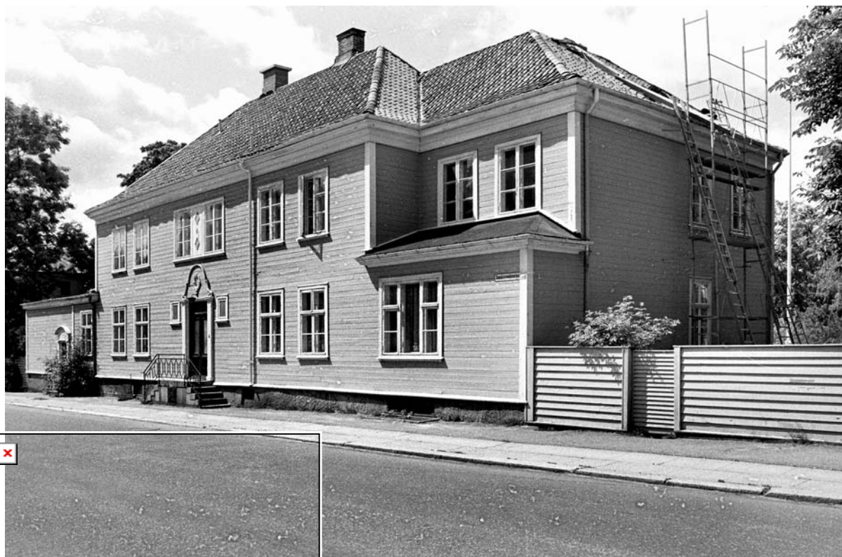
105-0110-006. Sorenskrivergården i Sannesundsveien skal være bygd i 1860-åra, men ble iflg. informasjon på registreringsskjema ombygd tidlig på 1900-tallet. I 2004 var huset borte, et større boligkompleks er kommet på stedet.
