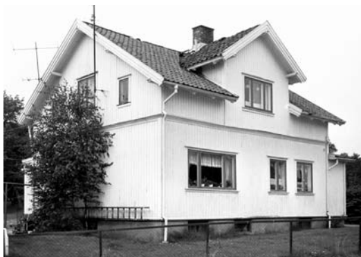
105-0205-042. Bolighus i Sarpsborg by. Det skal være bygd i 1887, og er typisk for bolighus fra slutten av 1800-tallet. Ved SEFRAK-registrering var de opprinnelige vinduene skiftet ut med funkisvinduer. Huset har siden blitt revet i forbindelse med bygging av nytt rådhus.
