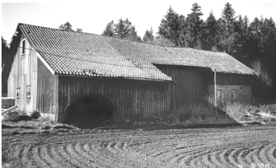
130-0309-012. Driftsbygningen sto på et av Bjørnstadbruka og var en sveitserlåve med fjøs av tegl. Den ble revet på grunn av E6- utbyggingen i de sentrumsnære områdene. I 2004 lå en støyvoll på stedet.
