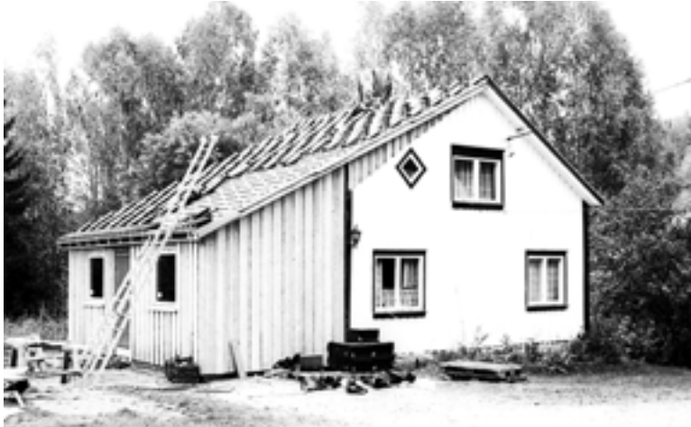
0911-205-011. Stua på småbruket Røa under Nordre Lunden i Øvre Gjerstad høsten 2000. Flere mindre stuebygninger i Gjerstad er i de senere årene bygd ut etter dette mønsteret – med et tilbygg langs hele inngangssida og skeivtekt tak. De er klassifisert som endringstype B.
