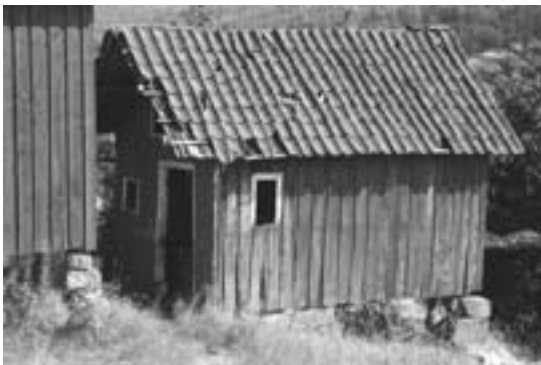
0911-104-036. Taket på vedskjulet på Fone bruk 22 i Ytre Gjerstad er vølt og skiftet fra krum uglasert tegl til bølgeblekk. Skifte av taktekke er den vanligste endringen for gruppen i endringstype C.
