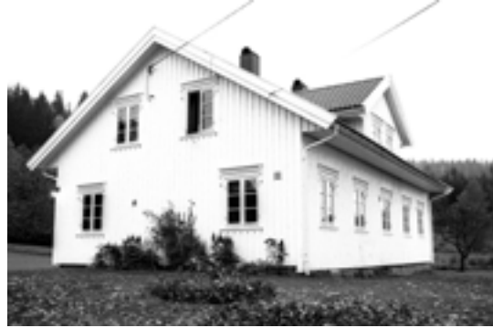
0911-206-054. Hovedbygningen på Kleven under Åsbø har beholdt lengden, men er bygd på i bredden og har fått ny ark. Tilsynelatende ikke så store utbygg, men volum, takvinkel og karakter er likevel endret så mye at det har preg av et nytt hus, og er klassifisert i endringstype A.
