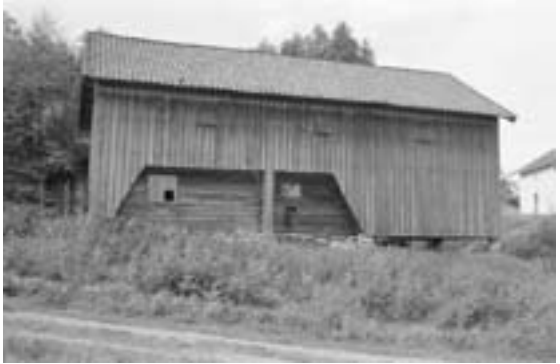
0911-104-057. Driftsbygningen på Byholt bruk 1 i Ytre Gjerstad er typisk for enhetslåvene i området. Takbærende konstruksjon er bindingsverk. Fjøs og stall er lafta, og fordi disse er mer utsatt for råte er de bygd slik at de kan skiftes ut. For å slippe til lys og luft er det heller ikke vanlig å kle inn denne delen. Driftsbygningen på Byholt er vølt med ny kledning og nytt taktekke, men mistet et karakteristisk trekk da fjøsbolken ble kledd inn. Huset er klassifisert som endringstype C.
