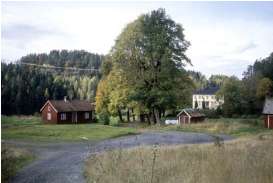
Eikelands Verk , med forvalterboligen til høyre. Åtte av Gjerstads femten vedtaksfredete bygninger befinner seg på Eikelands Verk.
