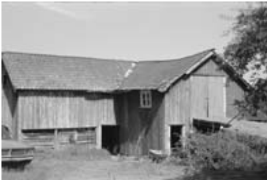
0911-104-064. Driftsbygningen på småbruket Rønningen under Gryting i Ytre Gjerstad er satt i stand og brukes bl.a. som stall. Den har fått ny kledning, og nytt platetak erstatter det gamle teglsteinstaket. Det tradisjonelle prinsippet for å kle løe og fjøsdel er fulgt.
