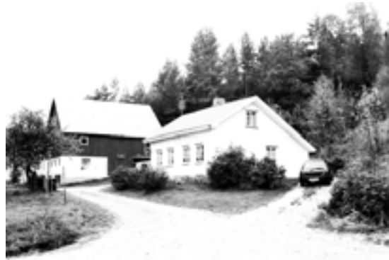
0911-205-001. Stua på småbruket Grunnsvoll under Vevestad i Øvre Gjerstad hadde opprinnelig toromsplan med gang bak, og har etter registreringen fått skeivtekt røst ved utvidelse på inngangssida. Den karakteristiske 4-vinduers fasaden på framsida er intakt. Flere mindre hus i Gjerstad er bygd ut etter dette prinsippet. Huset er klassifisert som endringstype B.
