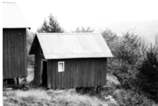
0911-104-036. Taket på vedskjulet på Fone bruk 22 i Ytre Gjerstad er vølt og skiftet fra krum uglasert tegl til bølgeblekk. Skifte av taktekke er den vanligste endringen for gruppen i endringstype C.
