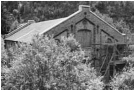
0911-102-037. Sliperbygningen ved Stifoss ble bygd i 1893. Den ligger i nedre del av Gjerstadvassdraget og er den siste gjenværende av de store, eldre industribygningene i Gjerstad. Driften tok endelig slutt i 1949. Den trues av lekkasjer fra tak og knuste vinduer.
