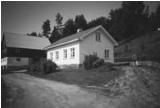
0911-205-001. Stua på småbruket Grunnsvoll under Vevestad i Øvre Gjerstad hadde opprinnelig toromsplan med gang bak, og har etter registreringen fått skeivtekt røst ved utvidelse på inngangssida. Den karakteristiske 4-vinduers fasaden på framsida er intakt. Flere mindre hus i Gjerstad er bygd ut etter dette prinsippet. Huset er klassifisert som endringstype B.
