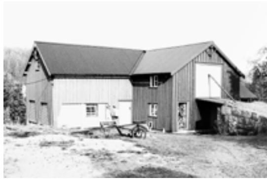
0911-104-064. Driftsbygningen på småbruket Rønningen under Gryting i Ytre Gjerstad er satt i stand og brukes bl.a. som stall. Den har fått ny kledning, og nytt platetak erstatter det gamle teglsteinstaket. Det tradisjonelle prinsippet for å kle løe og fjøsdel er fulgt.
