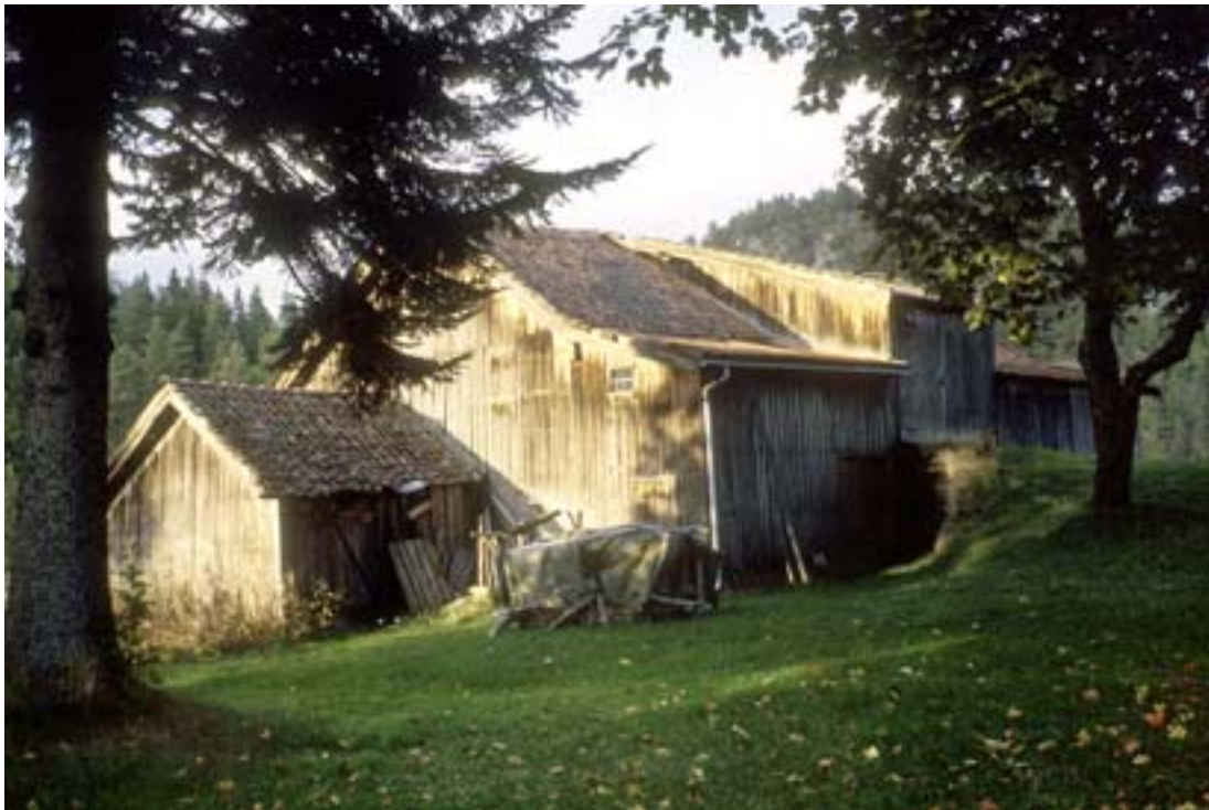
0911-107-042. Driftsbygningen på Nordre Tveit i Ytre Gjersatd var merket av manglende funksjon og vedlikehold alt ved registreringen i 1989
