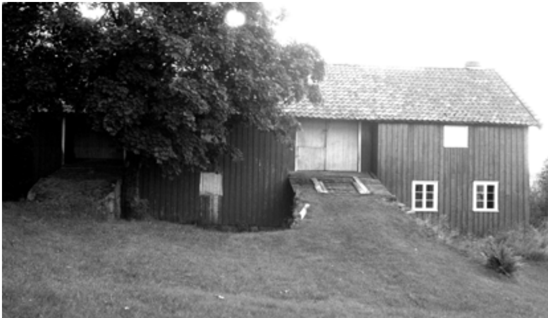
0911-104-021. Driftsbygningen på Fone er et typisk eksempel på hus av denne typen fra Gjerstad som i dag er borte. Den er av " enhetslåvetypen", dvs .den er bygd for å huse mange funksjoner samlet under ett tak. Det er karakteristisk for Agder-fylkene at enhetslåven slo tidlig gjennom, og det reflekteres i Gjerstad-materialet. Driftsbygningen på Fone skal være bygd i 1870 og påbygd på 1900-tallet. Huset var ute av bruk ved registreringen i 1986 og i dårlig stand. Taket falt sammen i 1994 og huset ble da revet. Tunet var i bruk som feriested ved registreringen, men har i dag funksjon som boligeiendom, og det gamle våningshuset står.
