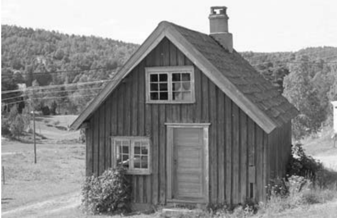
0911-102-013. Småhus på gårdstun med aktiv drift er utsatt for riving. Det er ikke bruk for dem lenger, og ofte står de i vegen for moderne maskiner. Bryggerhuset på Fiane "Der Øst" i Ytre Gjerstad ble revet fordi det sto i vegen i tunet.
