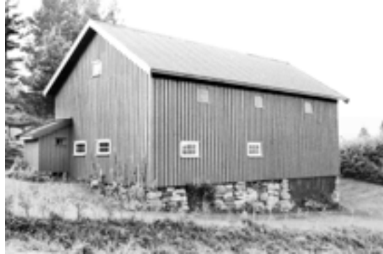
0911-104-057. Driftsbygningen på Byholt bruk 1 i Ytre Gjerstad er typisk for enhetslåvene i området. Takbærende konstruksjon er bindingsverk. Fjøs og stall er lafta, og fordi disse er mer utsatt for råte er de bygd slik at de kan skiftes ut. For å slippe til lys og luft er det heller ikke vanlig å kle inn denne delen. Driftsbygningen på Byholt er vølt med ny kledning og nytt taktekke, men mistet et karakteristisk trekk da fjøsbolken ble kledd inn. Huset er klassifisert som endringstype C.
