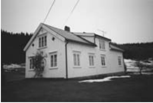
0911-206-054. Hovedbygningen på Kleven under Åsbø har beholdt lengden, men er bygd på i bredden og har fått ny ark. Tilsynelatende ikke så store utbygg, men volum, takvinkel og karakter er likevel endret så mye at det har preg av et nytt hus, og er klassifisert i endringstype A.
