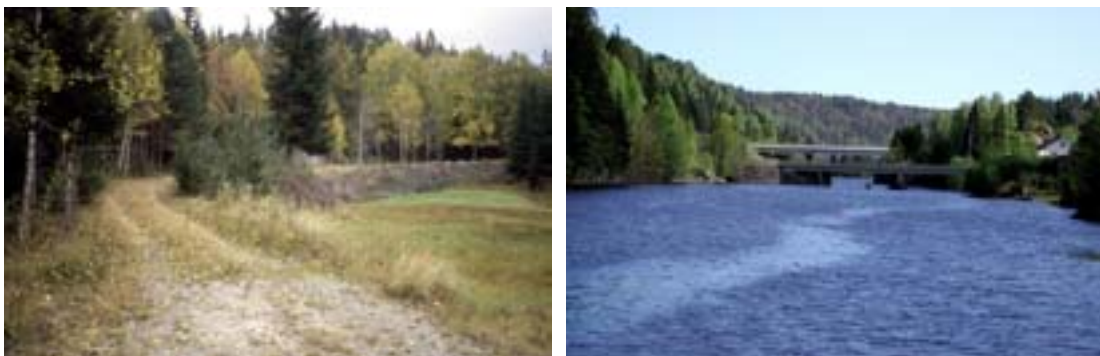
Gjerstad kommune og historielaget i samarbeid med Sundet der ny og gammel E18 krysser Statens Vegvesen har ryddet bevarte partier av den Gjerstadvassdraget. "Vestlandske Hovedveg" over Østerholtheia
