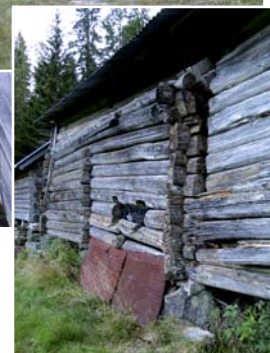
0821-009-013. Nedlagt gårdsbruk i Åseå-dalen nord i Bø, der jordvegen slås. Tunet var fraflytta også ved SEFRAK-registreringen i 1985, bolighuset ble nyttet i forbindelse med slått, skogdrift og fritid, og er holdt i hevd. Uthusene er merket av manglende funksjon over tid, veggene begynner å sige, men situasjonen er ikke vesentlig endret siden 1985.
