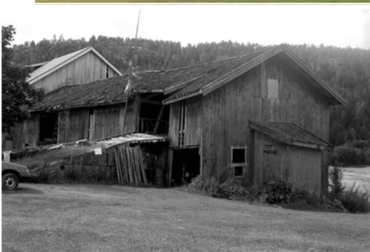
0821-001-011. Den gamle driftsbygningen bestod av lafta tømmerbolker for fjøs og låve sammenbygd under ett tak. I det lille utbygget til høyre var stallet. Ny driftsbygning ble bygd inn til den gamle. I 2004 var den eldste delen revet, stedet hvor den sto vises tydelig i gavlen.
