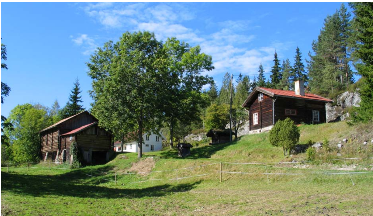
0821-008-057–60. Orebakken ligger høyt i åsene nord i bygda og er omgitt av skog. Her er tjærebrede tømmerhus uten kledning et markant innslag. Driftsbygningene er ofte ei sammenstilt rekke med fjøs, låve og stall under separate tak og i ulike høyder.
