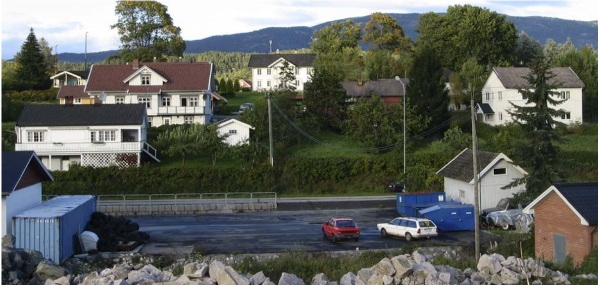
0821-005-020. Nedre Grini (midt i bildet) ligger i utkanten av Bøbyen, i et område regulert til bolig, og grenser opp til næringsområdene langs innfartsvegen. Våningshuset, som er fra 1894, var kun i bruk som vanlig bolig også ved registreringen i 1988.
