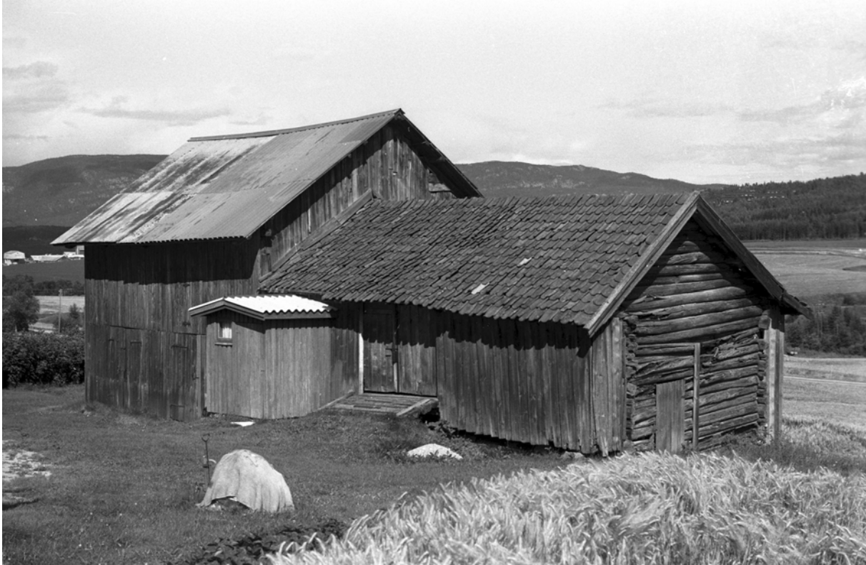
0821 006-020. Driftsbygningen på husmannsplassen Vestre Kåsin var en typisk sammenbygd rekke med fjøs, gammel låve og ny låve (fra 1930-tallet). Fjøsdelene ble revet på 1970-tallet. Ved registreringen i 1984 var det planer om å rive resten på grunn av dårlig tilstand, og i dag er alt borte.
