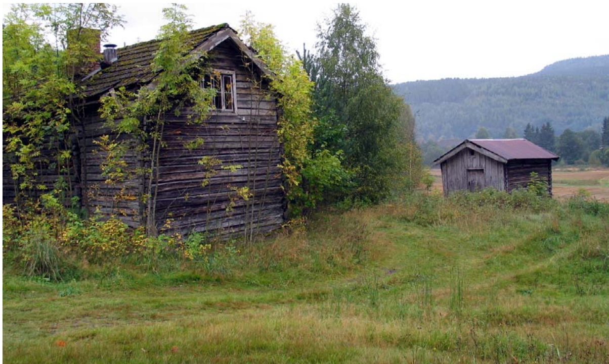
0821-011-094-096. Fraflytta husmannsplass i hoveddalføret. Situasjonen er i hovedsak uendret siden registreringen i 1987. Våningshus, eldhus og stabbur er registrert.
