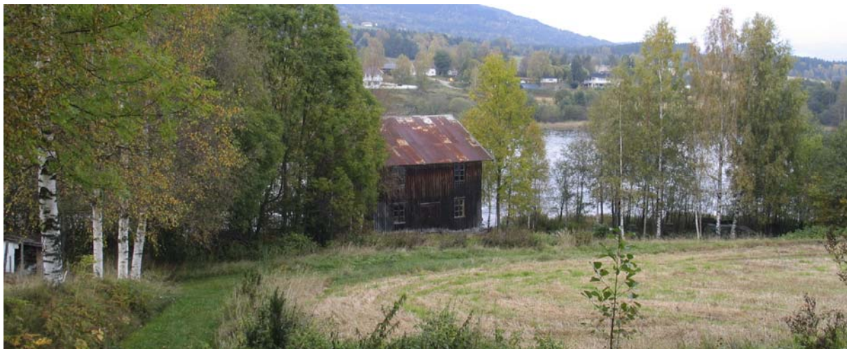
0821-003-062. Mølla ved Sagfossen er et av få registrerte industribygg i materialet. Den ligger midt i hoveddalføret der Bøelva er på sitt bredeste. Etter saga, som har gitt navn til eiendommen, er det bare ruiner.
