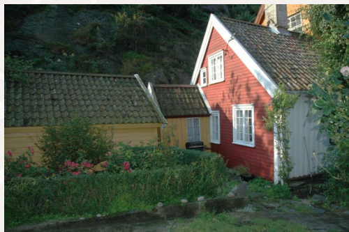
Få uthus ble fredet i de tidligste vedtakene. På Langfeldts hus i Ny-Hellesund er stabburet til venstre i bildet fredet. Hovedbygningen er også et typisk eksempel på sammenbygging av våningshus og bryggerhus i lengderetningen.
