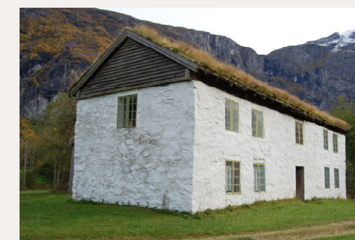
Hovudbygningen på Ner-Hole i Rauma kommune er bygd av naturstein, eit uvanleg materiale i distriktet.
