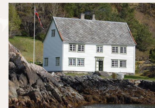
Hovudbygningen på Stordalsholmen i Stordal kommune vart òg nytta som vertshus for dei båtfarande.
