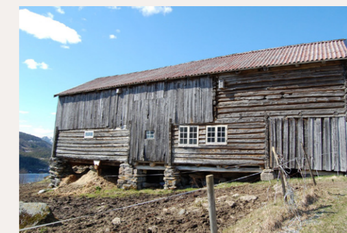
Uthus med kombinert fjøs og stallfunksjon på Rognskog Bortistua i Halså kommune. Bygningen er eitt av få freda uthus i fylket.
