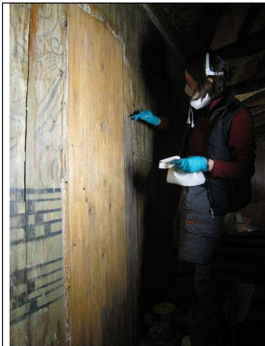
Fig. 62 viser rensing av innbøting på nordvegg i skipet med Duxola malingsfjerner og skalpell.
