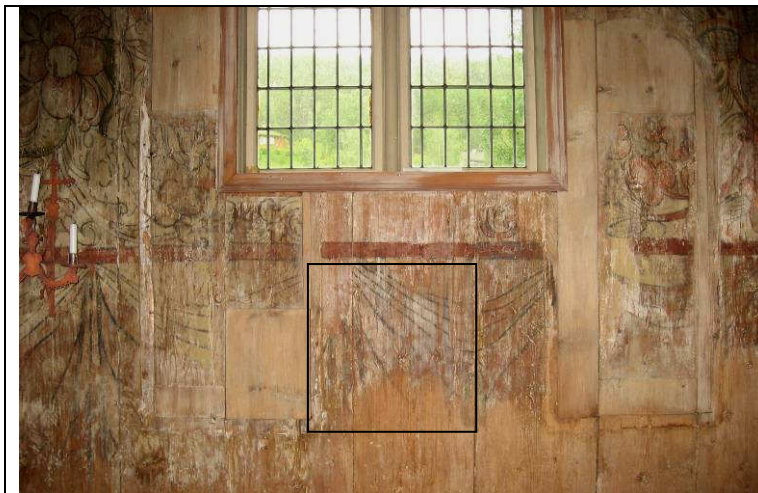
Fig. 61 viser hoveddelen av nordveggen i koret etter konsolidering og rensing. Området hvor fernissen er fjernet er markert.
