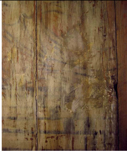
Fig. 57 viser en typisk overflate på sydveggen i skipet. For lyse og for mørke retusjer, rennestriper og et slør av overmaling skjømmer restene av limfargedekoren.
