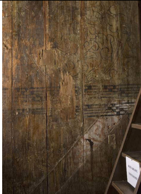
Fig. 58 viser et parti fra vestveggen. Legg merke til den lyse stripen på veggen hvor trappevengen til galleriet som ble bygget i 1862 løp. Denne ble satt opp før interiøret ble malt og har bevart deler av limfargedekoren urørt.
