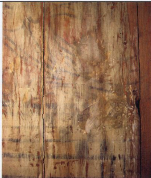
Fig.47 viser en typisk overflate på sydveggen i skipet. For lyse og for mørke retusjer, rennestriper og et slør av overmaling skjemmer restene av limfargedekoren.
