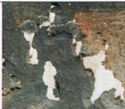
Fig. 32. Retusjerte områder viser at utfallene er skjedd etter siste behandling
