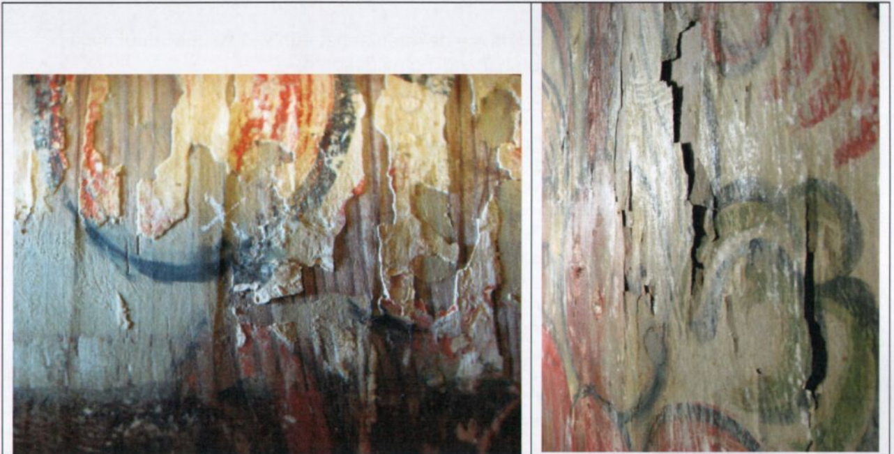
Fig. 51 og 52 viser typiske opp- og avskallinger malingen i koret. Fig. 51, fra østre del av nordveggen, viser også del av en retusj. Fig. 52 er fra området sør for vinduet på østveggen,
