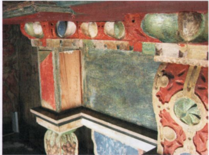
Fig.16 viser tilstanden før behandling, mens fig. 17 viser ett annet område etter konsolidering og retusjering. Legg merke til at et fasett-element mangler.
