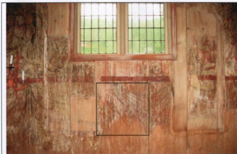
Fig. 51 viser hoveddelen av nordveggen i koret etter konsolidering og rensing. Området hvor femissen er fjernet er markert.
