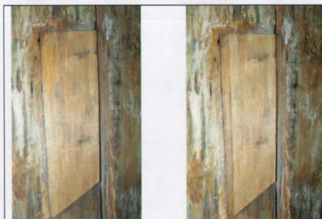
Fig. 52 og 53 viser en rensert innbøtting på sydveggen i skipet.
