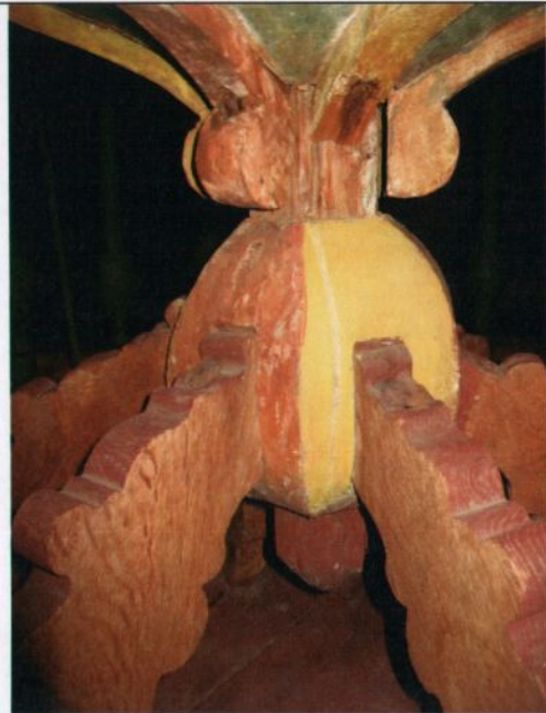
Fig 23. Overgangen mellom de utsveifede føttene og selve funten er det svake området.
