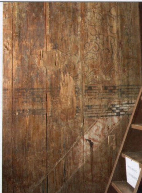
Fig 48 viser et parti fra vestveggen. Legg merke til den lyse stripen på veggen hvor trappevengen til galleriet som ble bygget i 1862 løp. Denne ble satt opp før interiøret ble malt og har bevart deler av limfargedekoren urørt.
