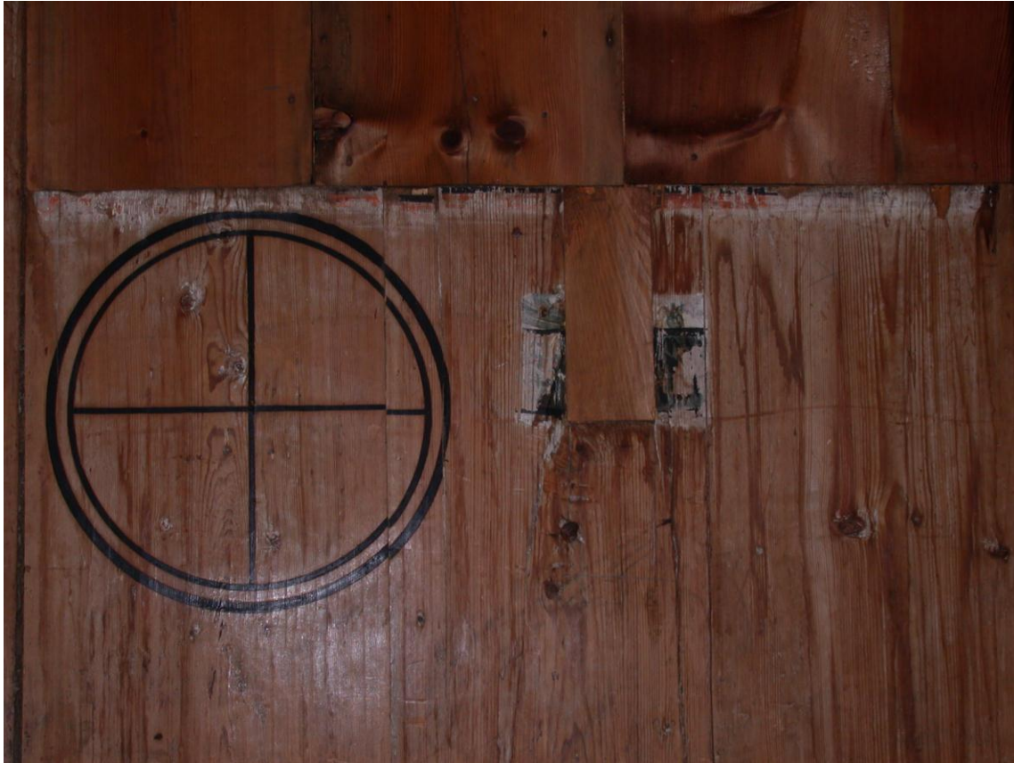
Fig. 3. Sørvegg. I midten av bilde kan man se noen små rester av limfargedekor på begge sider av en senere innbøtning. Før behandling 2010
