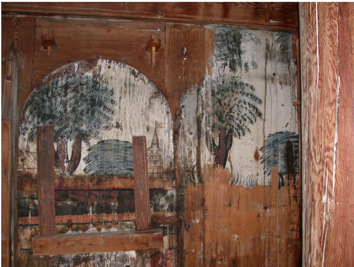
Fig.4. Dekor. Sørvegg mot vest med dør. Før behandling 2010.
