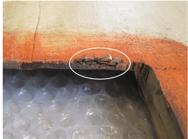
Figur 13: Taklist (stussbrettlist) før behandling. Treverket er skadet og noen trebiter er løse (markering).
