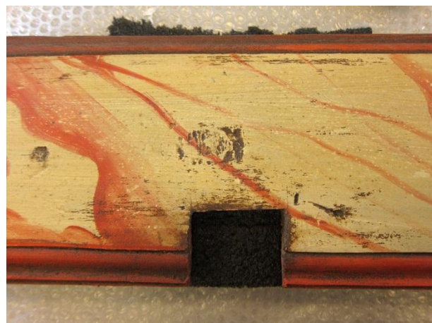
Figur 11: Dørgerikt. Etter rensing. I fordypninger ligger det igjen rester fra en tidligere brun overmaling (se pilene).
