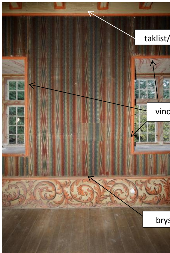
Figur 4: Rom 206, biblioteket i oktober 2011, før listverket ble demontert. Bilde viser østveggen mellom de to vinduene.
