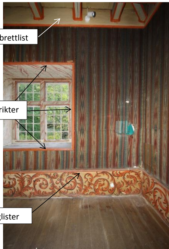
Figur 5: Rom 206, biblioteket i oktober 2011, før listverket ble demontert. Bilde viser den søndre delen av østveggen.
