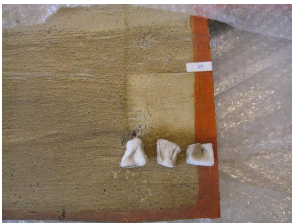
Figur 6: Rensetest med lett fuktet melamin-rencesvamp. Svampen tar en god del av overflatesmussen uten å skade maling.
