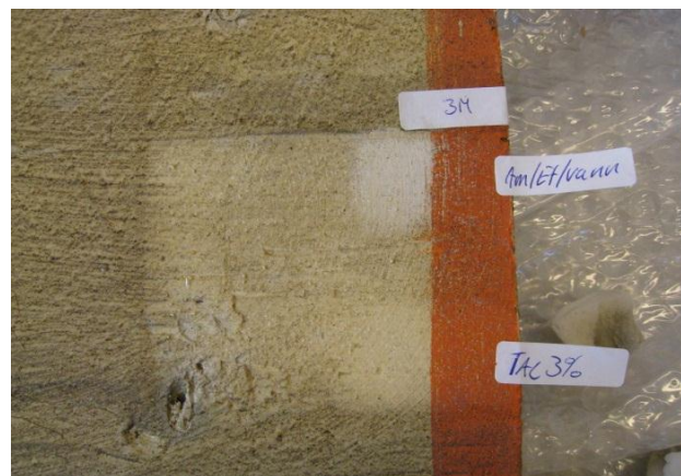
Figur 7: Rensetest med salmiakk/etanol/vann-blanding (øverst i bilde) og rensetest med triammoniumcitrat (nederst i bilde). Rensetestene ble utført på et område som ble rensset med fuktet melamin-rencesvamp (se bilde til venstre).
