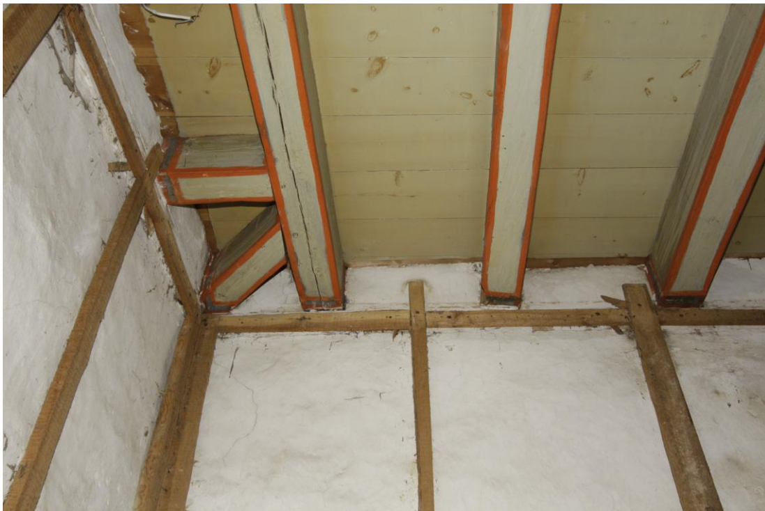
Baroniet Rosendal. Rom 206. Biblioteket. Deler av taket, nord- og østveggen etter at 1600- talls tekstiltapet er fjernet. Foto. JB. 2012
