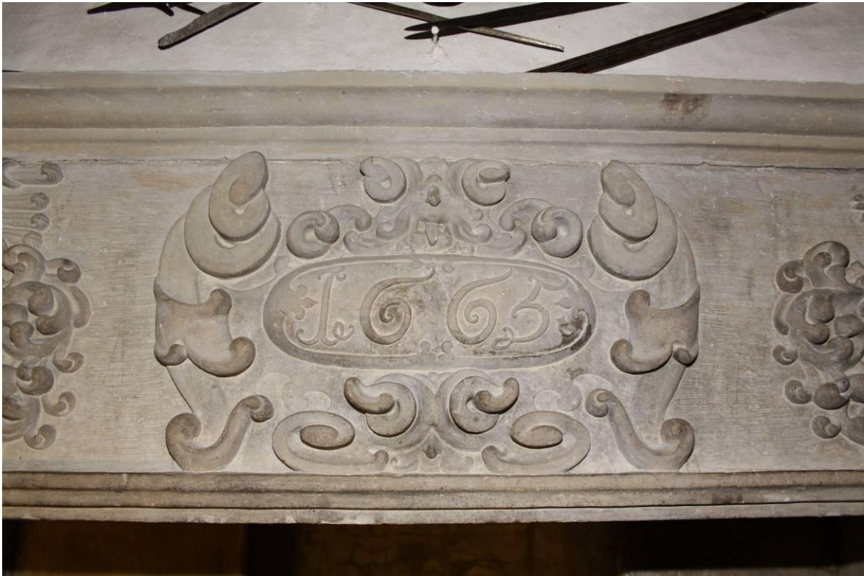
Figur 21. Detalj av det relieffet på "arkitraven/gesimsen" med dateringen. Fargespor viser at kaminen opprinnelig eller tidligere var malt. Fargesporene tyder på at den var polykrom, trolig med fargesetting fra barokken.
