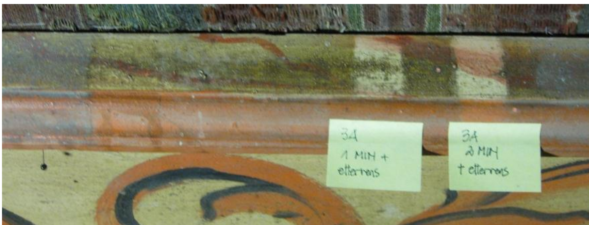
Figur 16. Renseprøver på brystningslist.
