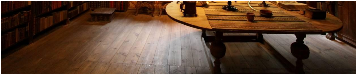
Figur 23. Rommet har et pløyd bordgulv som ligger øst/vest. Alderen er ukjent, men trolig er det lagt i løpet av 1800 – årene. Gulvbordene er skjøtt ca midt i rommet. Gulvet er ubehandlet.
