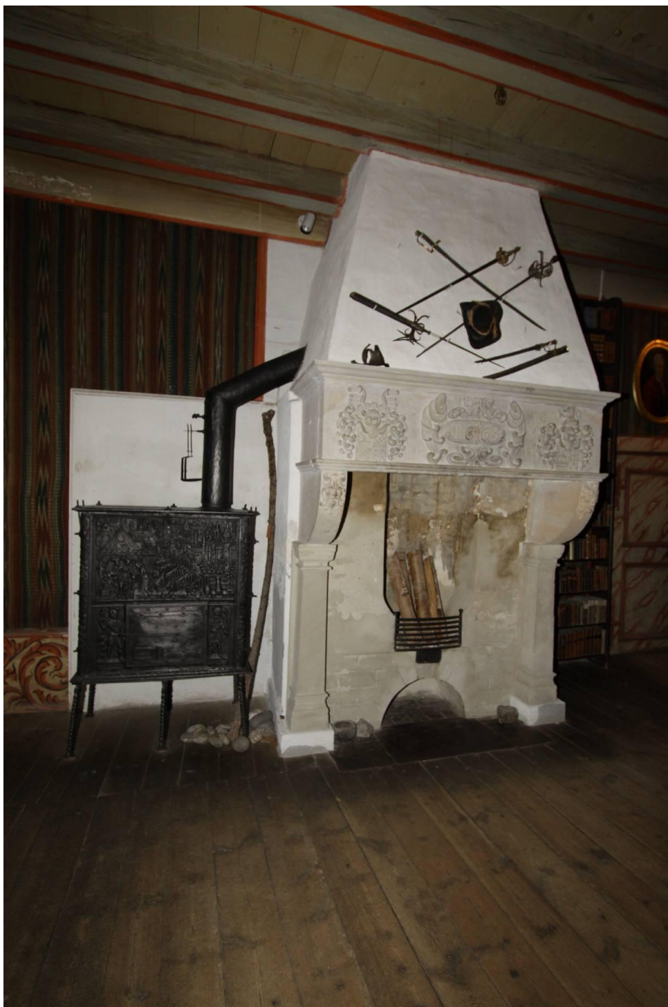
Figur 19. Opprinnelig kamin, datert 1665. Kaminen er utført i pusset tegl, og sandstein/kalkstein. Sidevangenes kapiteler og "arkitraven/gesimsen" over brennkammeret har relieffer i brukbarokk. Brennkammeret er en senere ombygging, det har trolig opprinnelig vært helt åpent inn til \frac{3}{4} dybde av kaminen. Brannmuren bak jernovnen er sekundær. Det er ikke funnet noen opplysninger om når den er satt inn i rommet.
