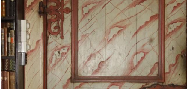
Figur 25. Lysbrytere for lampene i rommet. Alle lampene er koblet til dimmere. Installasjonen er festet til bokhyllen bak dør 206/201 og ikke til deler av den opprinnelige innredningen. Denne døra står alltid åpen, og bryterne er derfor ikke synlige.
