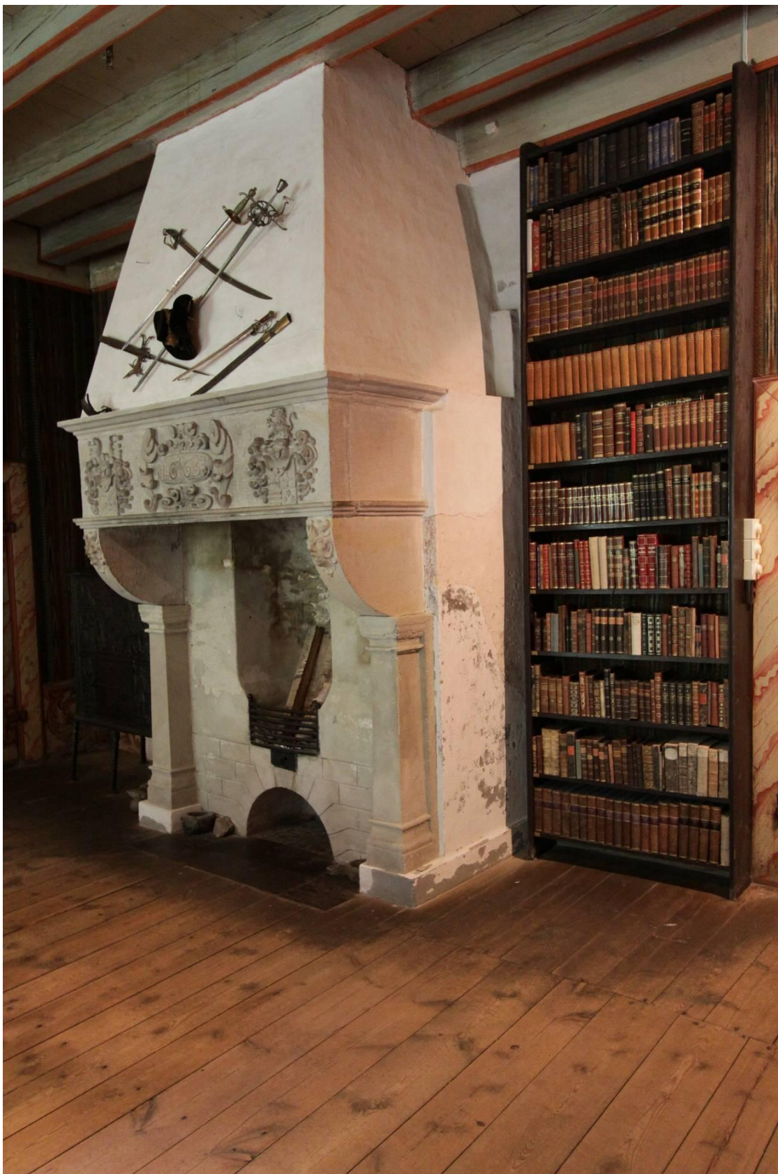
Figur 20. Opprinnelig kamin, datert 1665. Kaminen er utført i pusset tegl, og sandstein/kalkstein. Sidevangenes kapiteler og "arkitraven/gesimsen" over brennkammeret har relieffer i brukbarokk. Brennkammeret er en senere ombygging, det har trolig opprinnelig vært helt åpent inn til \frac{3}{4} dybde av kaminen. Kaminen har flere reparasjoner, både i tegldelen og steindelen. Overflaten er meget skitten, og har diverse mekaniske skader.
