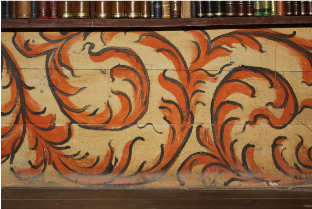
Figur 15. Detalj av brystningen på østveggen. Brystningen og den malte dekoren er samtidig med tekstiltapetet dvs. ca. 1665. Rankedekoren er malt i en mager oljebasert maling. Overflaten er til dels meget skitten, og har mange fukt- og klimaskader. Skadene er dels forårsaket av direkte påvirkning av fukt og vann ved rengjøring, slik som det kan sees i nedre del av dekoren på dette bildet, hvor malinglaget er blakket og delvis ødelagt, dels nedmatting på grunn av høy relativ fuktighet gjennom lang tid.
