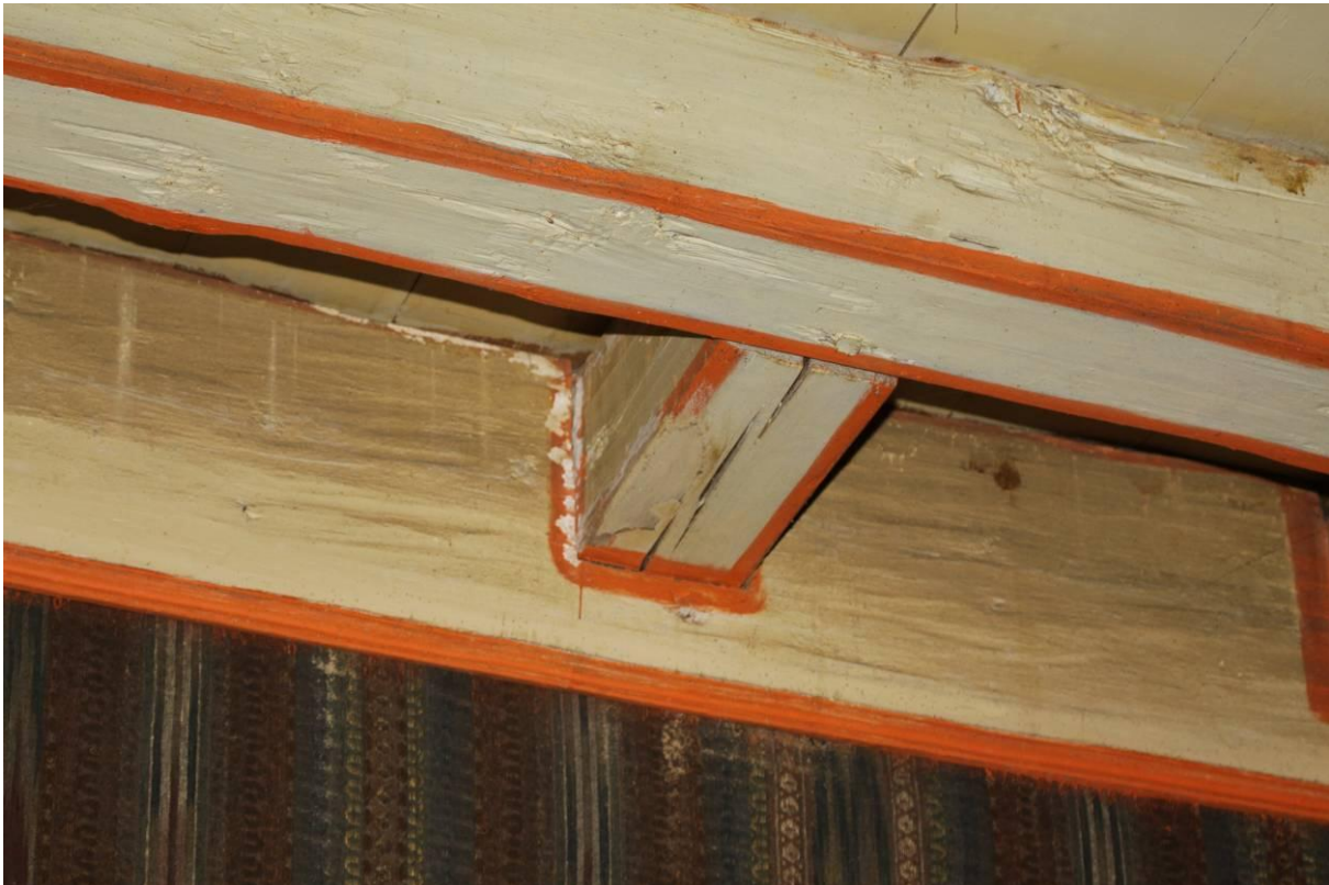
Figur 6. Detalj av takbjelker og stussbrett på østveggen.
