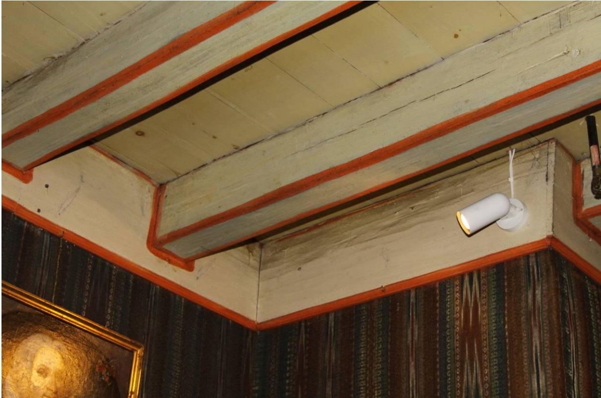
Figur 5. Detalj av taket i sydvestre hjørne.
