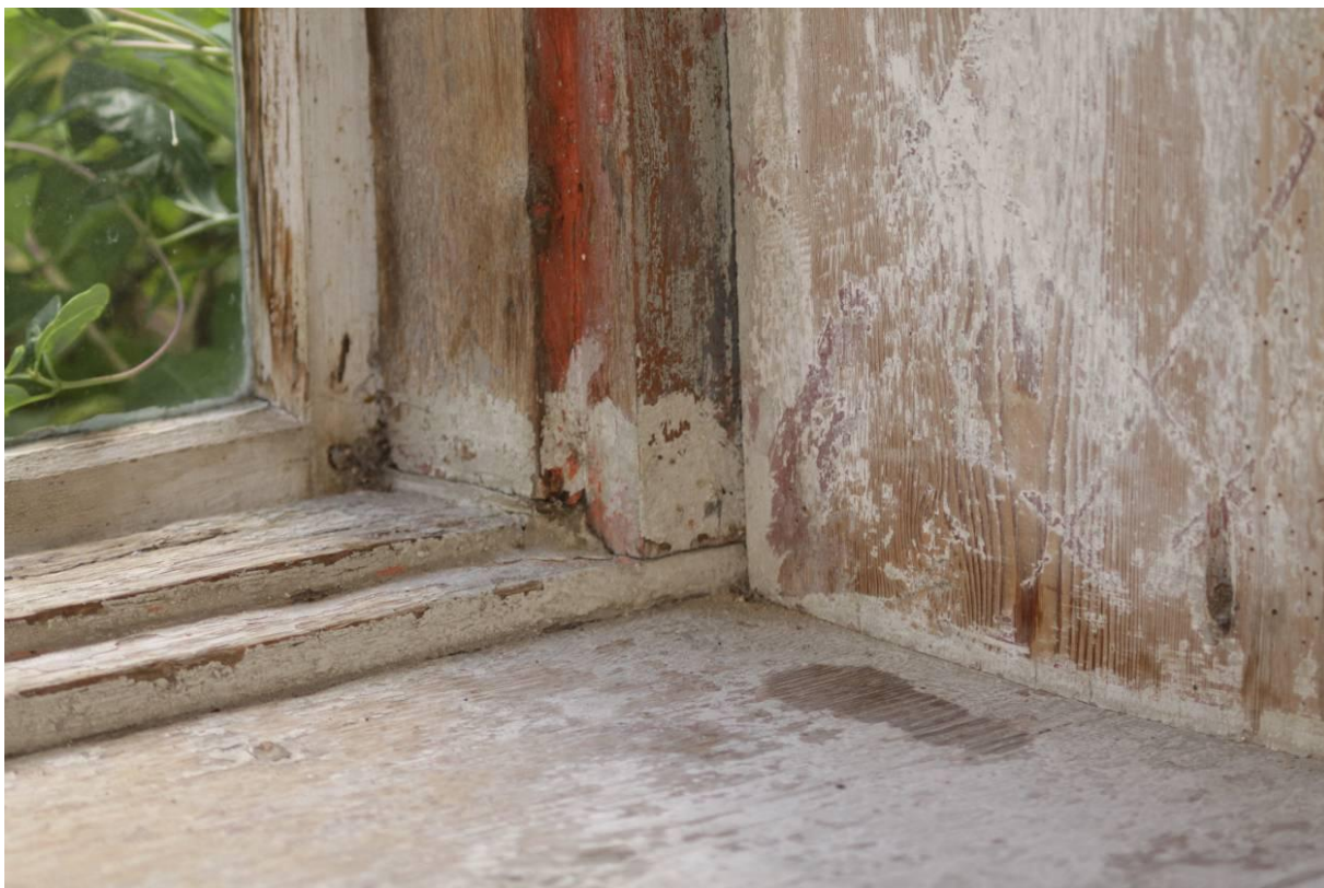
Figur 12. Detalj av nordøstre vindu som viser hvor nedbrutt maling og malt dekor er på deler av karm og vindusmyg. Bunnkarmen og nedre del av sidekarmene er overmalt.
