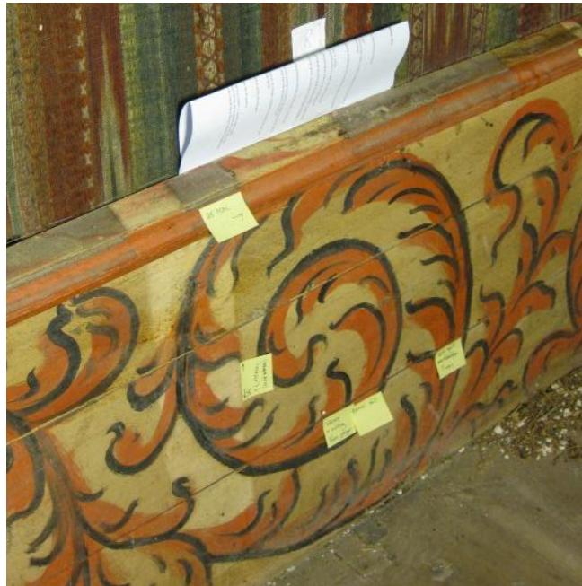
Figur 17. Detalj av brystningen på vestveggen. Bildet viser et utvalg av renseprøvene som er utført.
