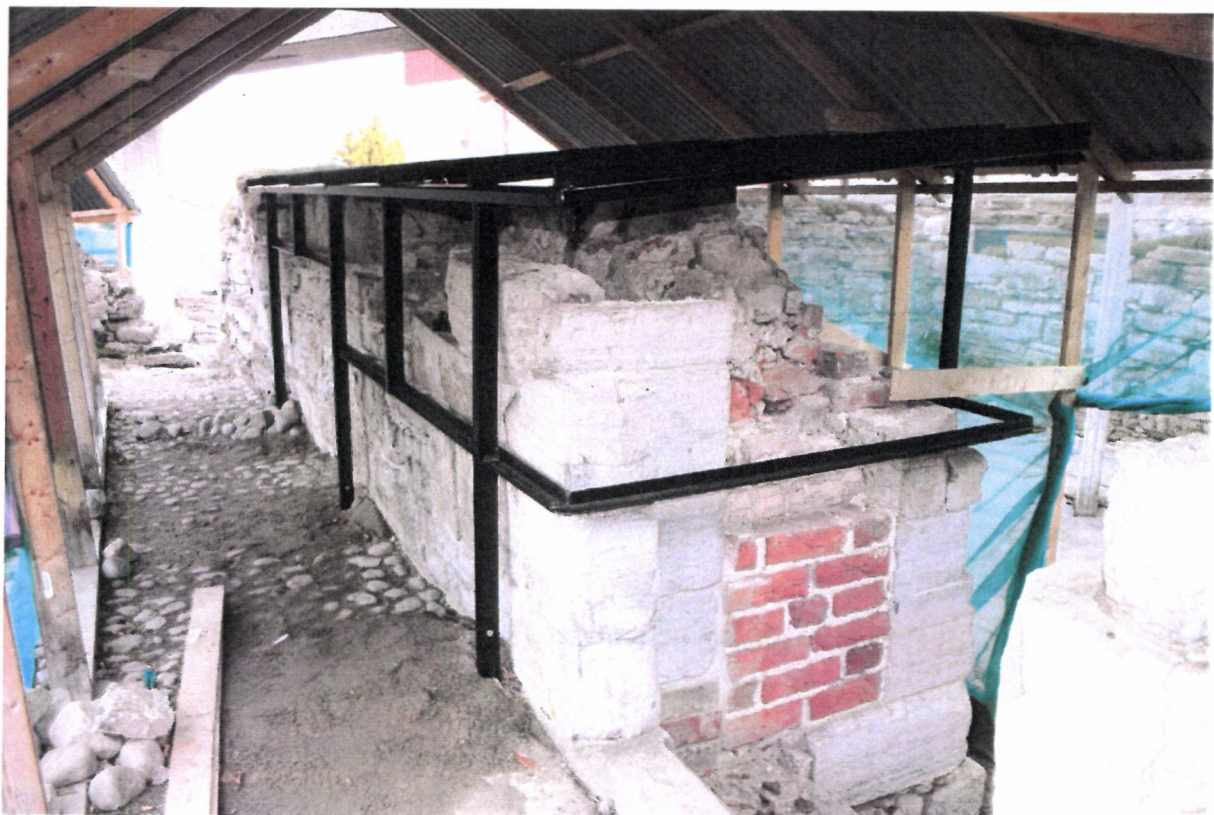
Rammeverk til glassdekke over nordmurens østre del
