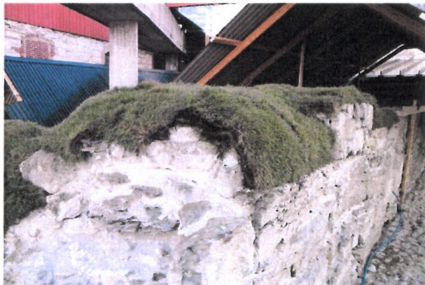
Nordmuren med gresstorv
