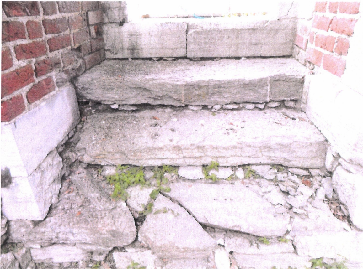
Trappa før arbeidene igangsettes
