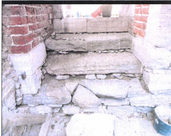
Ødelagte trappeheller løftes vekk og jord under hellene fjernes
