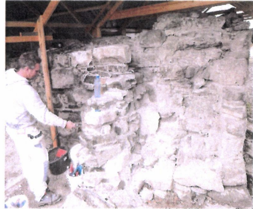
Bildene viser muring av en rekonstruert murvange som fortsettelse av nordmuren østover
