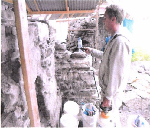
Bildene viser muring av en rekonstruert murvange som fortsettelse av nordmuren østover
