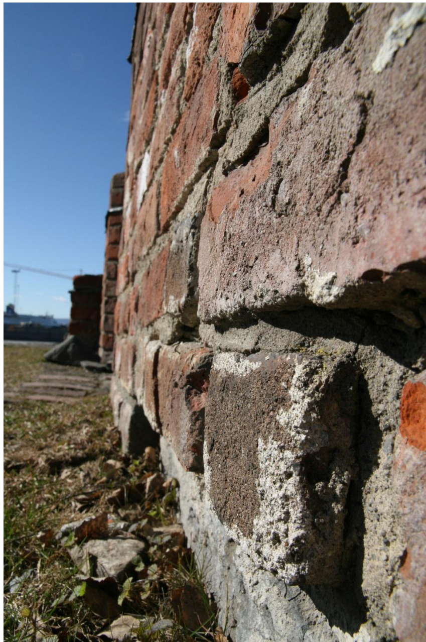
Vedlegg 2.15 - Teglstein med rester etter mørtel fra middelalderen. Fra mur like øst for teglportalen. Foto: Petter Snekkestad, 2011.
