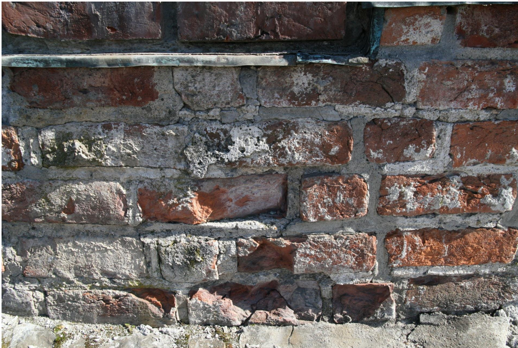
Vedlegg 2.14 - Utsnitt av bevart teglmurverk i søndre tverrskips indre nordvegg. Partiet er spesielt da det stedvis har bevart original puss og original mørtel helt ut i murlivet. Det gråfargede bindemiddelet er derimot nyere KC-mørtel. Foto: Petter Snekkestad, 2011.
