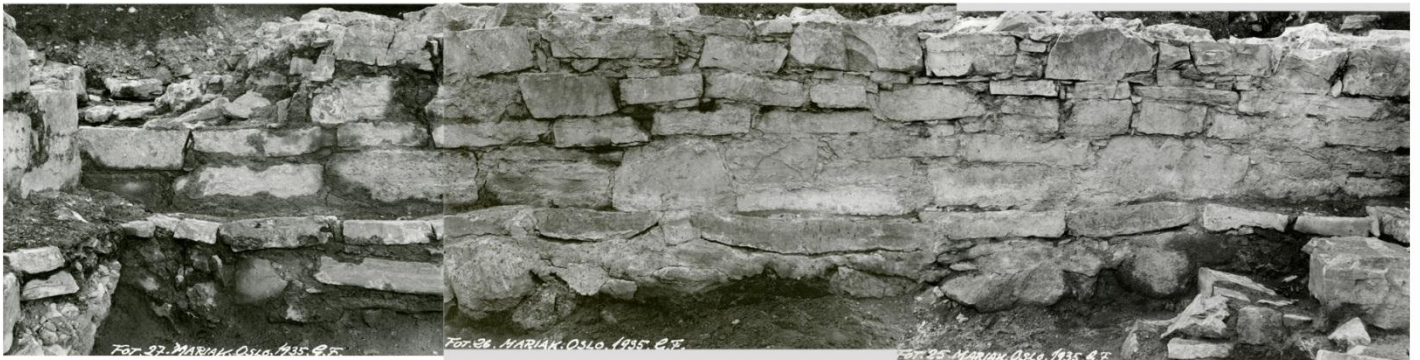
Foto 25, 26 og 27 smeltet sammen. Bruddsteinmuren strekker seg fra pilar 2 til hjørnepilar 1. G. Fischer, 1935.
