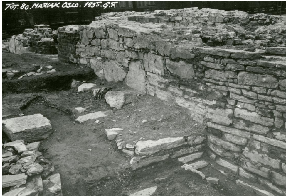
Foto 80. Sett mot nordøst. Indre murflukt i skipets vestvegg står i 3 skift med sokkel. "Stein 4" kan sees i øverste skift inntil skipets nordmur. G. Fischer, 1935.
