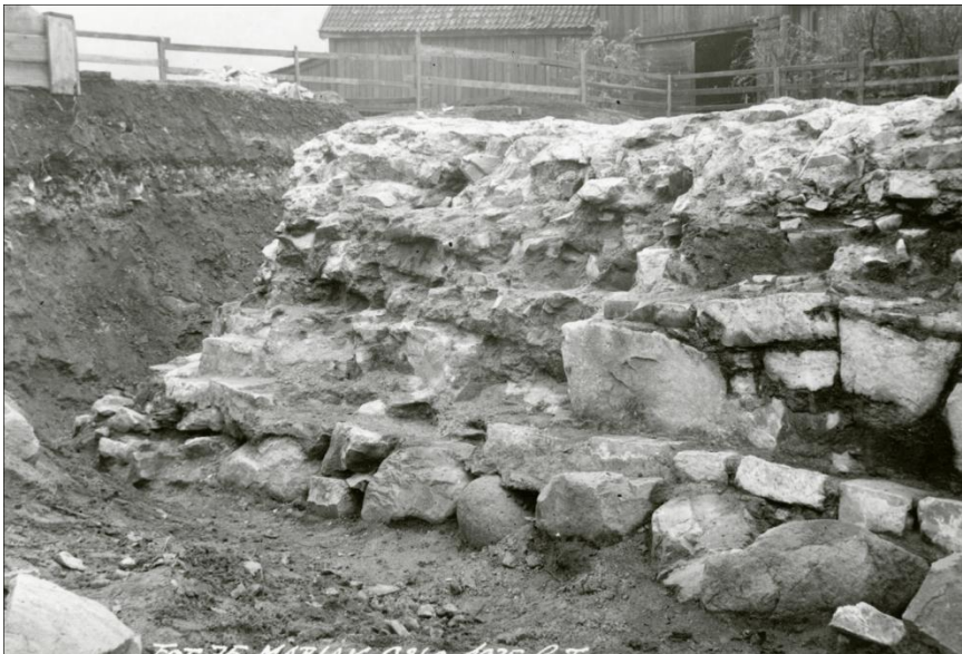
Foto 75. Sett mot sørøst. Nordtårnets nordmur har bevart mye av murkernen, mens bygningssteinen ble brutt løs og gjenbrukt ved andre anlegg etter at kirken gikk ut av bruk. G. Fischer, 1935.
