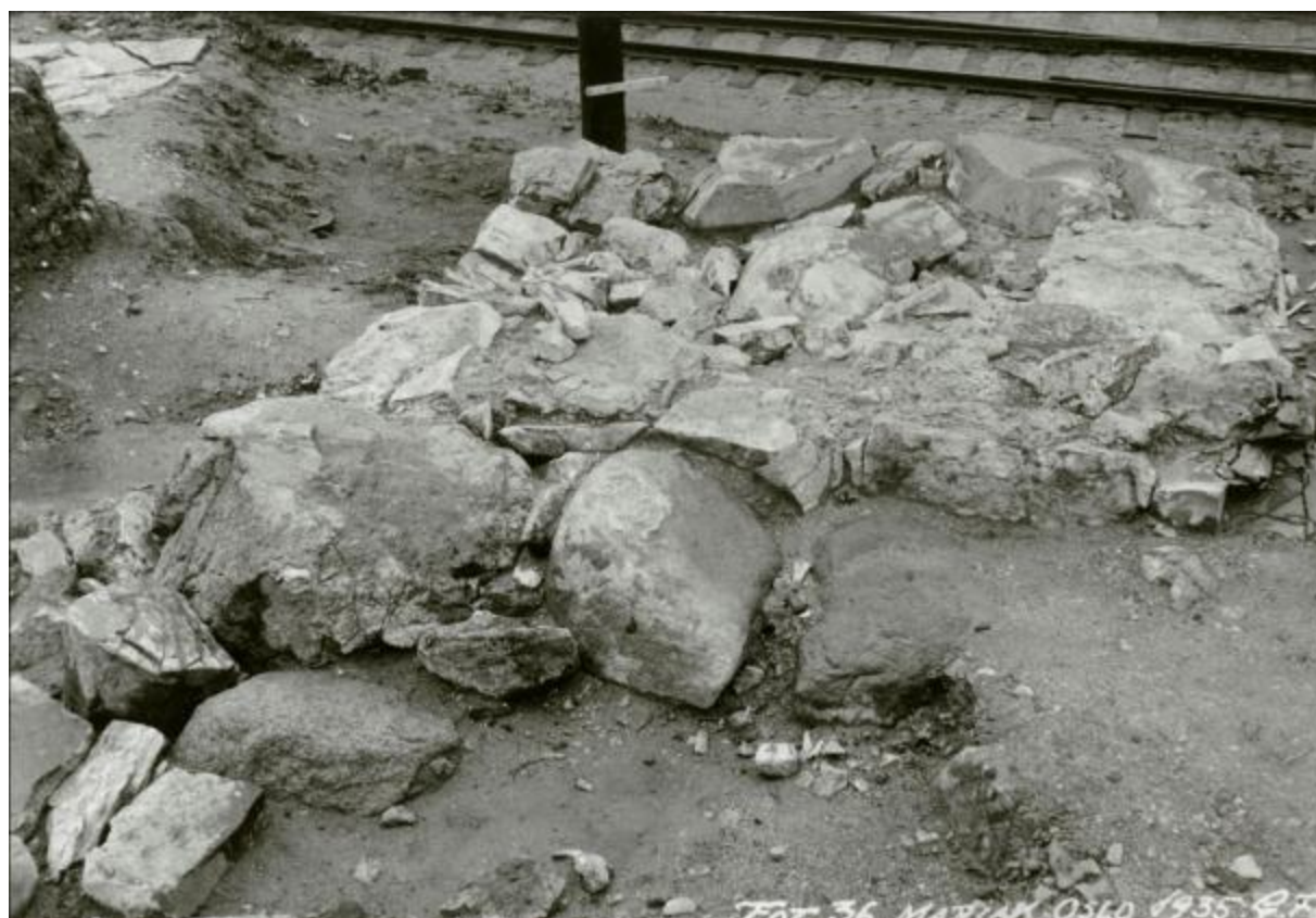
Foto 36. Sett mot vest. Fundamentrestene av pilar 3 sett ovenfra. G. Fischer, 1935.
