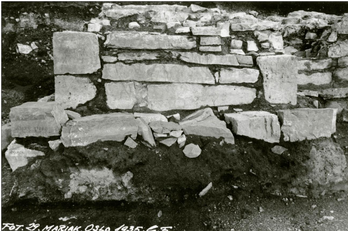
Foto 29. Sett mot øst. Detalj av pilar 2. G. Fischer, 1935.
