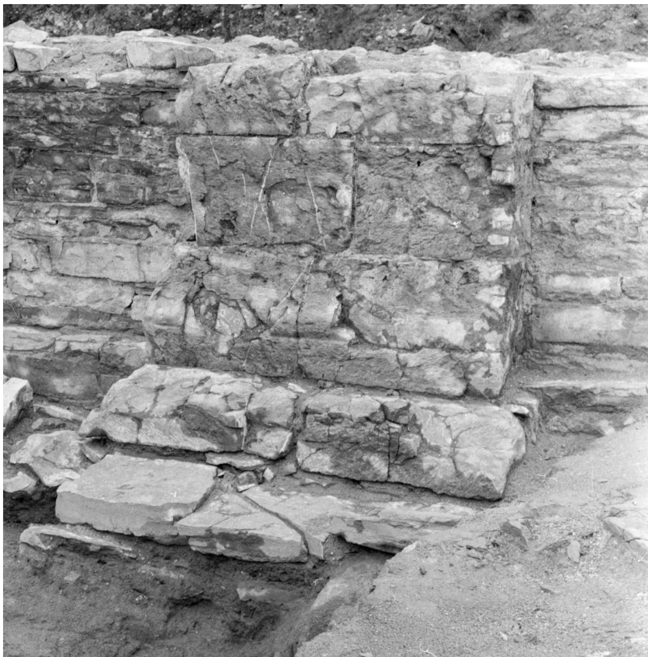
Utsnitt av foto 40. Sett mot nord. Lisene 2 var skadet ved avdekkingen og ble limt. Til høyre ser vi deler av den beskrevne del av indre nordvegg. O. Olsen/H. Christie, 1961.
