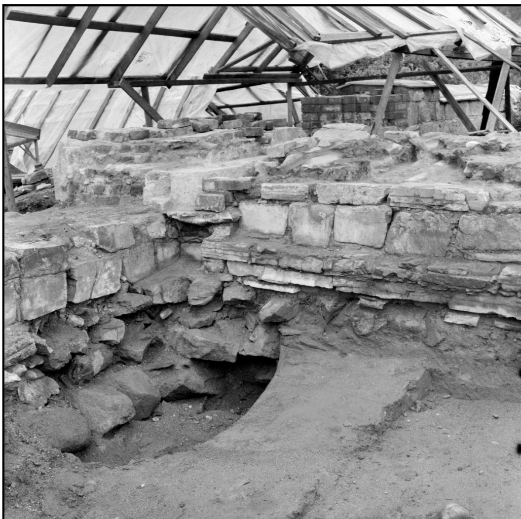
Foto 94. Sett mot sørøst. Korbueggens søndre del med eksponert fundament inn mot skipets sørvegg. O. Olsen/H. Christie, 1962.
