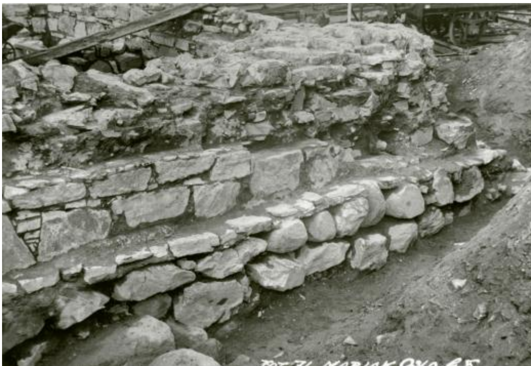
Foto 71. Sett mot nordvest. Ett skift i murlivet, sokkelen og en lagmessig ordnet fundamentering ligger under dagens terreng. G. Fischer, 1935.
