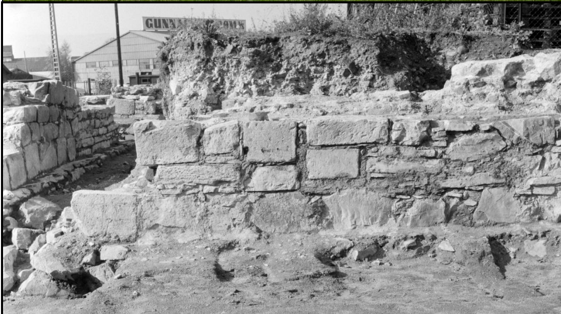
Utsnitt av foto 47. Sett mot vest. Indre vestvegg i tverrskipets nordre arm med utrast vange. O. Olsen/H. Christie, 1961.
