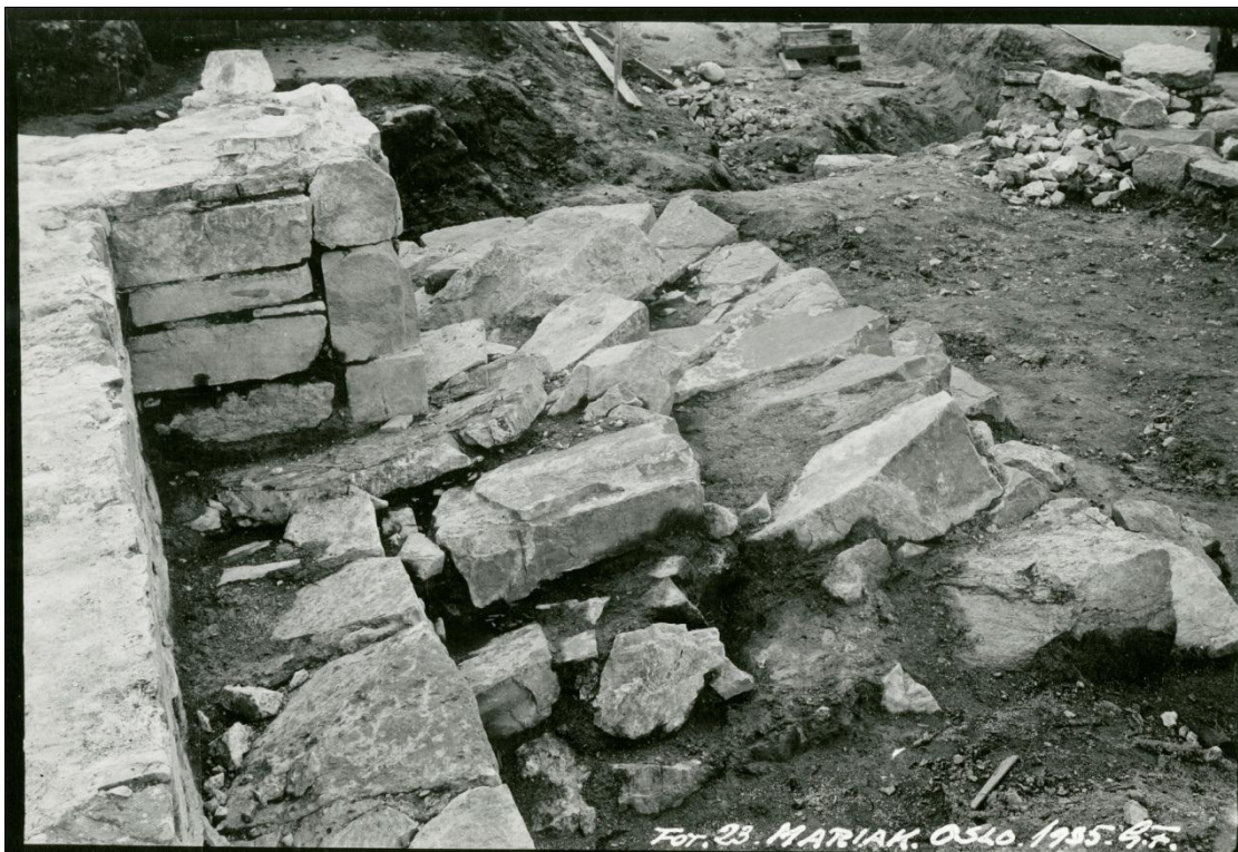
Foto 23. Sett mot sør. Pilar 1 med det tydelig utspringende fundamentet som i dag delvis ligger i dagen. G. Fischer, 1935.
