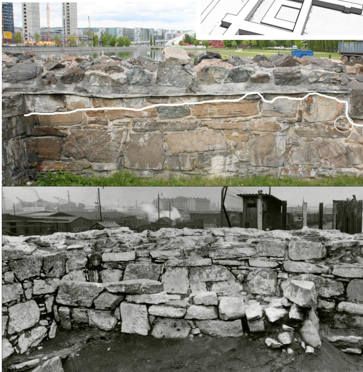
Utsnitt fra foto 79. Sett mot nord. Tørrmuren foran den indre nordveggen er sekundær. G. Fischer, 1935.
