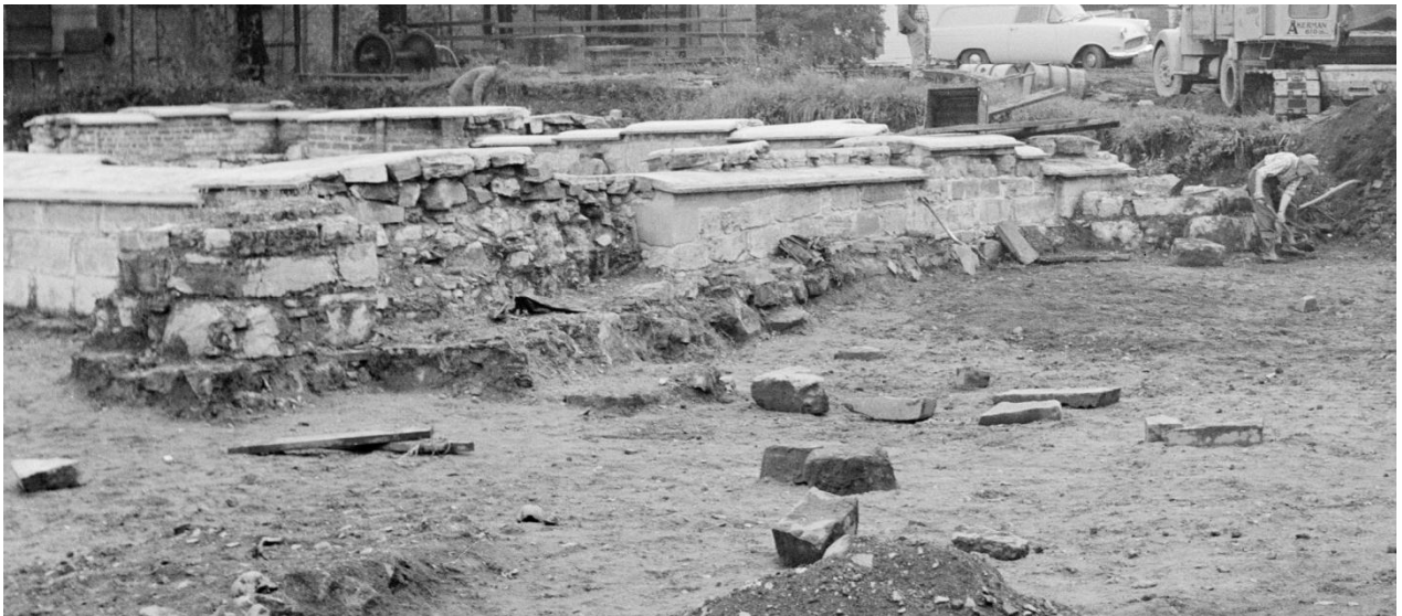
Utsnitt av foto 198. Sett mot nordvest. Ytre sørvegg (delvis konservert) med støttemurer fremst i bildet, samt det utrase partiet inn mot sørvestre hjørnet. O. Olsen/H. Christie, 1963.
