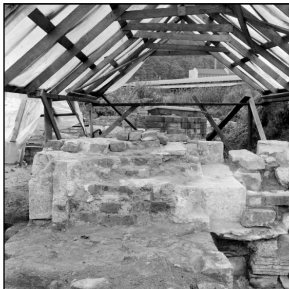
Foto 96. Snitt av vestveggs murkjerne frem til romansk korvegg. Sett mot sør. O. Olsen/H. Christie, 1962.
