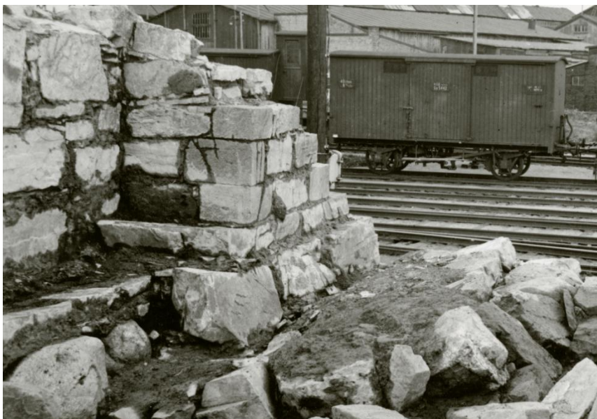
Utsnitt av foto 47. Sett mot sørvest. Pilar 4 omkranset av fundamentsteiner. G. Fischer, 1935.
