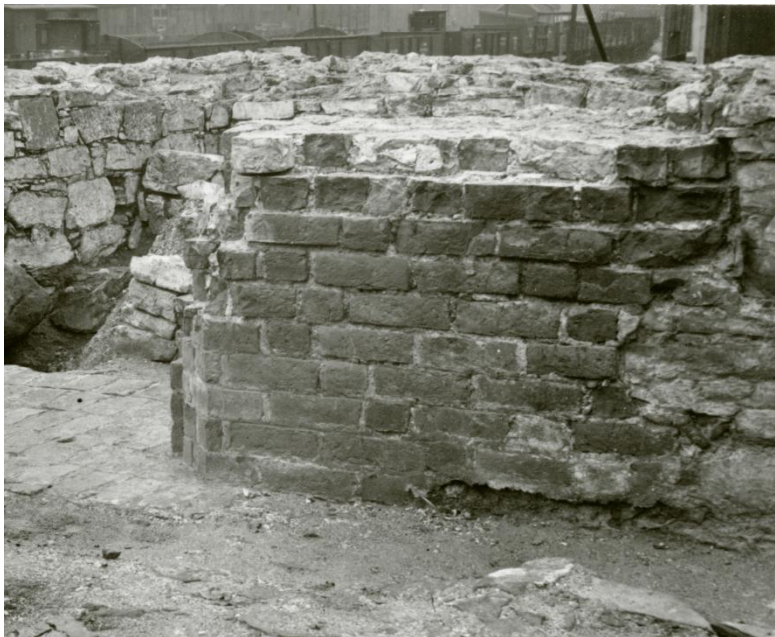
Utsnitt av foto 64. Sett mot nord. Teglportalen i ytre sørvegg i teglkirkens skip. Smyget var i 1935 bevart i 3-4 skift, men forsvant innen konserveringen i 1962. G. Fischer, 1935.
