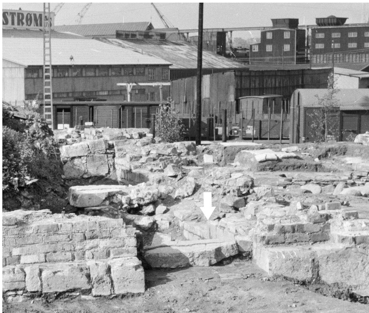
Utsnitt av foto 43. Sett mot nordvest. Sørveggen i skipet gjemmer seg bak tverrskipsarmens vestvegg. Den hvite pilen angir bruddet mellom de to bygningsfasene slik beskrevet av Ole Egil Eide (1974). Dens plassering samsvarer med den hvite pilen i bildet. O. Olsen/H. Christie, 1961.
