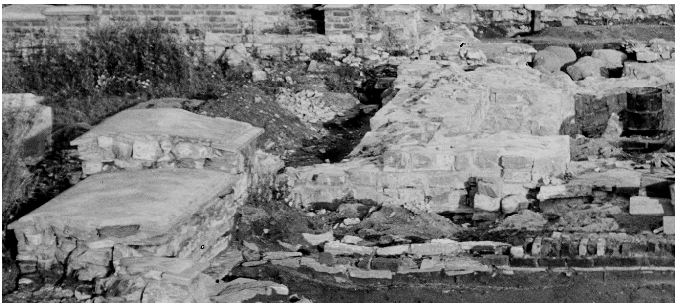
Utsnitt av foto 280. Sett mot øst. Korbuemurens nordre del etter konservering. Merk at den eksponerte murkjernen i korbueveggen og korets nordvegg har fått krone av tilført stein (jmfør foto 84). O. Olsen/H. Christie, 1963.
