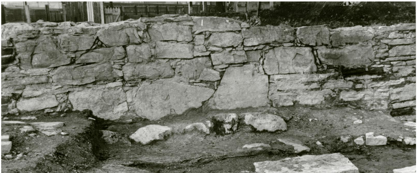
Utsnitt av foto 65. Sett mot nord. Det romanske murverket til høyre i bildet går over i gotiske skift fra ombyggingen omkring 1300. G. Fischer, 1935.
