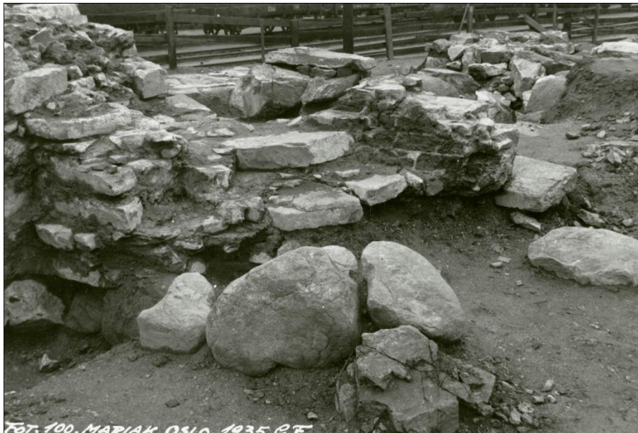
Foto 100. Sett mot nordvest. Legg merke til rester av et teglparti i indre skall i muren. Partiet taler for en hittil oversett trapp lik den i nordtårnet. G. Fischer, 1935.
