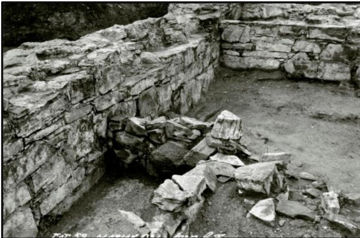
Foto 59. Sett mot øst. Torrsmuren foran nordveggen er sekundær. G. Fischer 1935.
