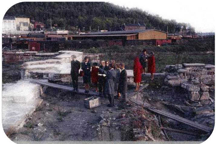
Figur 8. Sett mot sør. Befaring i Mariakirken i 1963. Murene er konservert, men den utgravde kirken er ennå ikke plensatt. Bjørn N. Christophersen, Oslo Museum, 1963.
