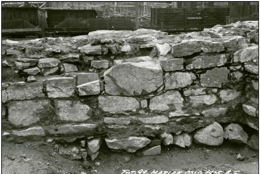
Foto 99. Sett mot vest. Vestveggen med sokkel og fundament. G. Fischer, 1935.
