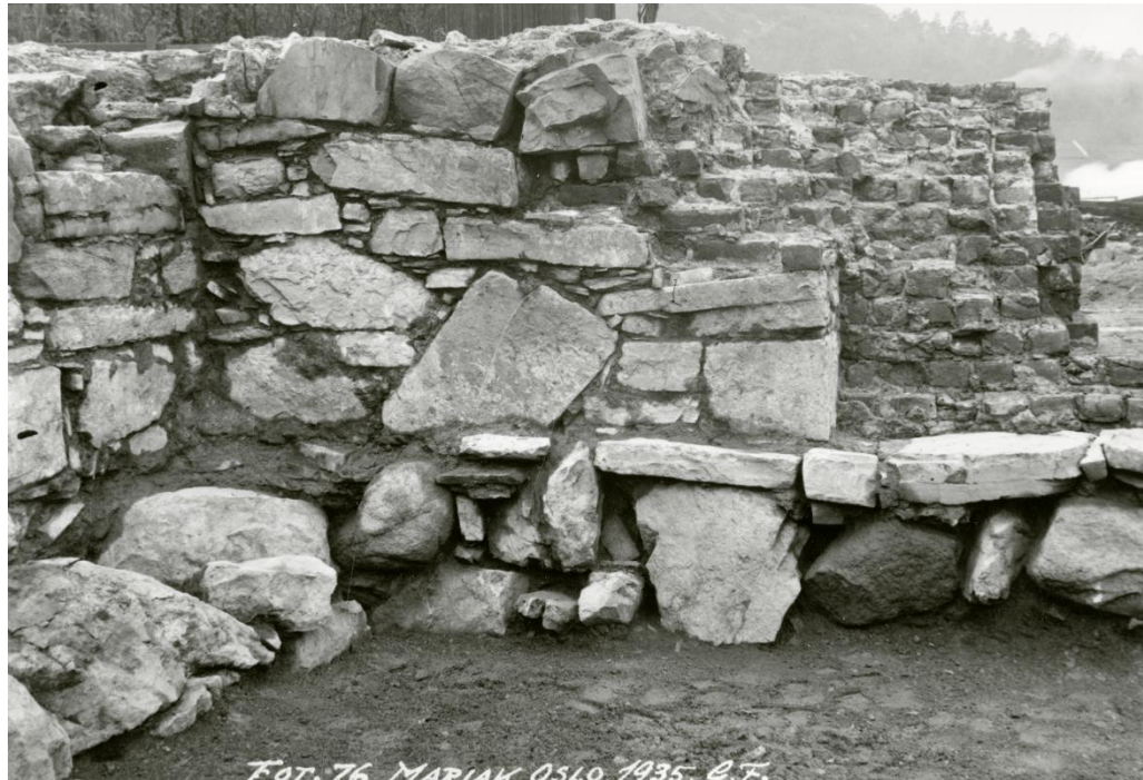
Foto 76. Sett mot sør. Indre sørvegg består av bruddsteinsmur avløst i vest med en inntrukket teglmur som ender i en åpning mot skipet. G. Fischer, 1935.
