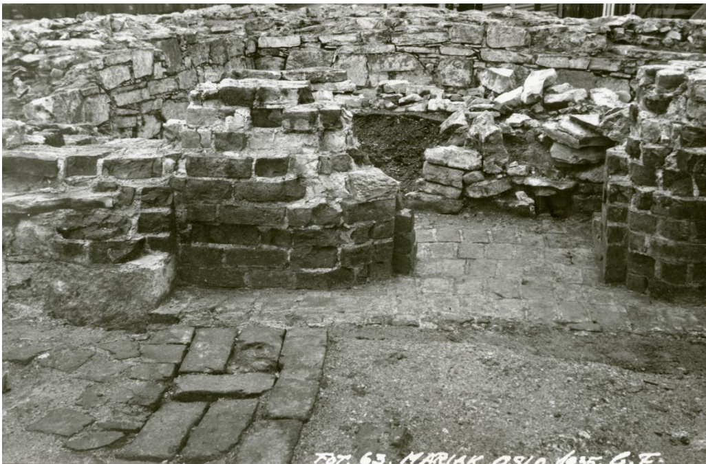
Foto 63. Sett mot nord. Teglportalen inn til nordtårnet med teglgulv. G. Fischer, 1935.
