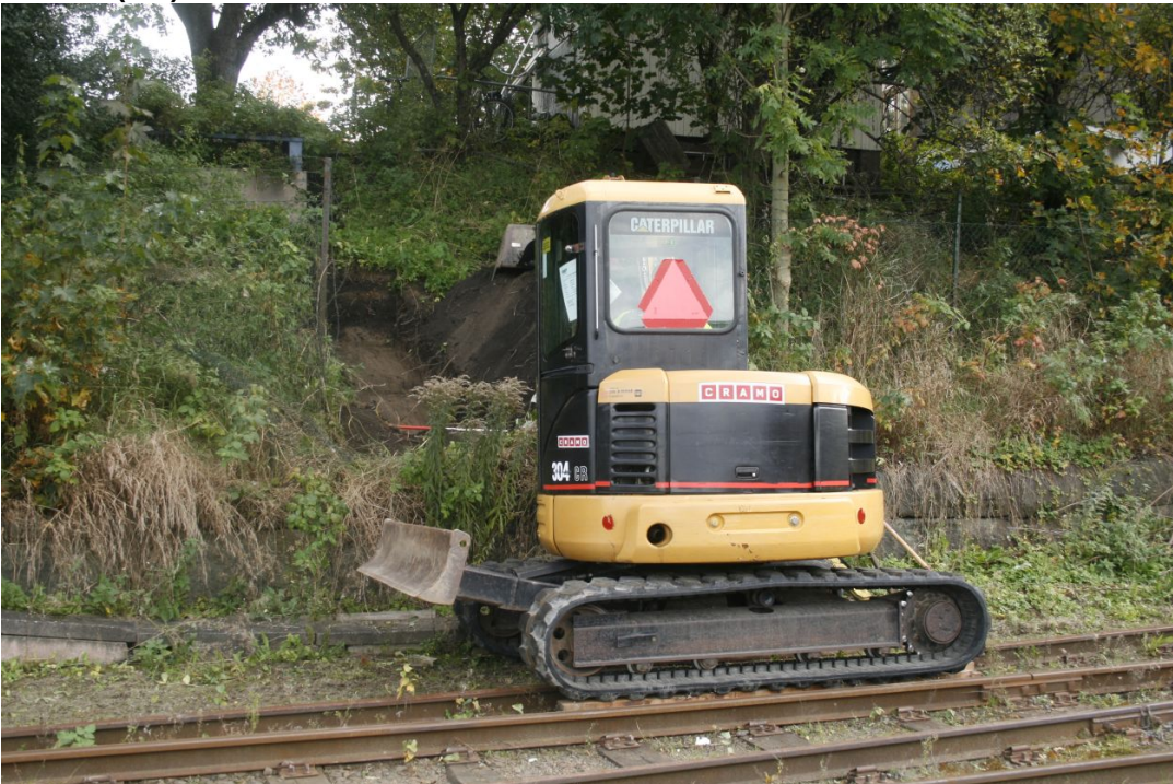
Fig. 10. Graving av grøft sett mot øst. Skur tilhørende Bispegata 16 i bakgrunnen.
