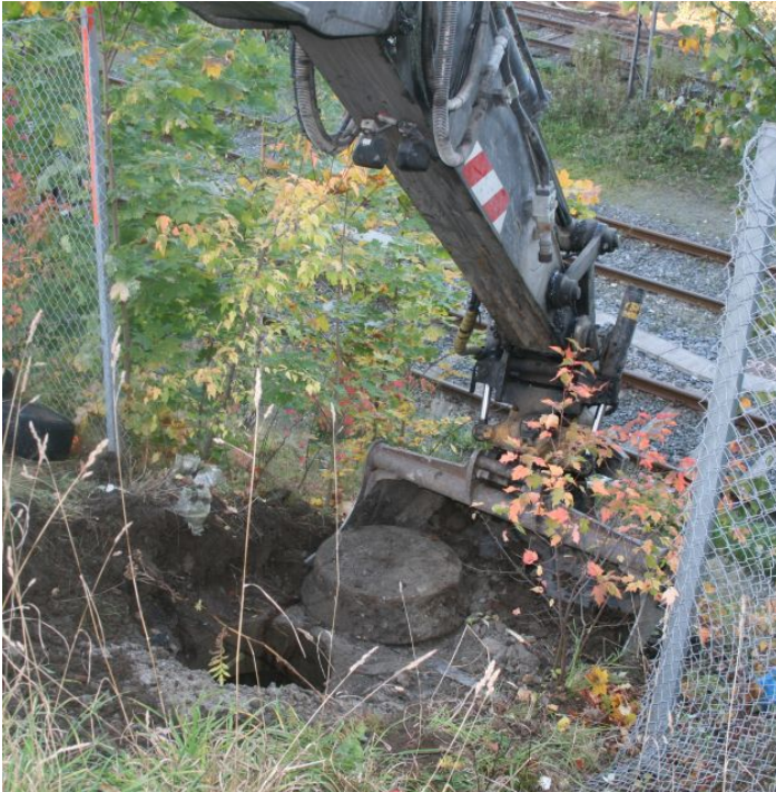
Fig. 8. Graving ovenfra for grøft 2a. Klypen-spor i bakgrunnen. Kumlokk fra kum i bend for vannledning og avløpsledning (se fig. 6).
