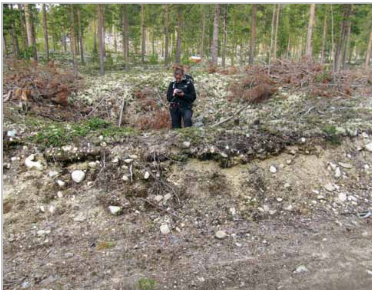
Figur 13. Fangstgrop, id 79967-16, som tidligere er avskåret av vei har nå fått ytterligere skader som følge av erosjon. Foto NIKU 2012.
