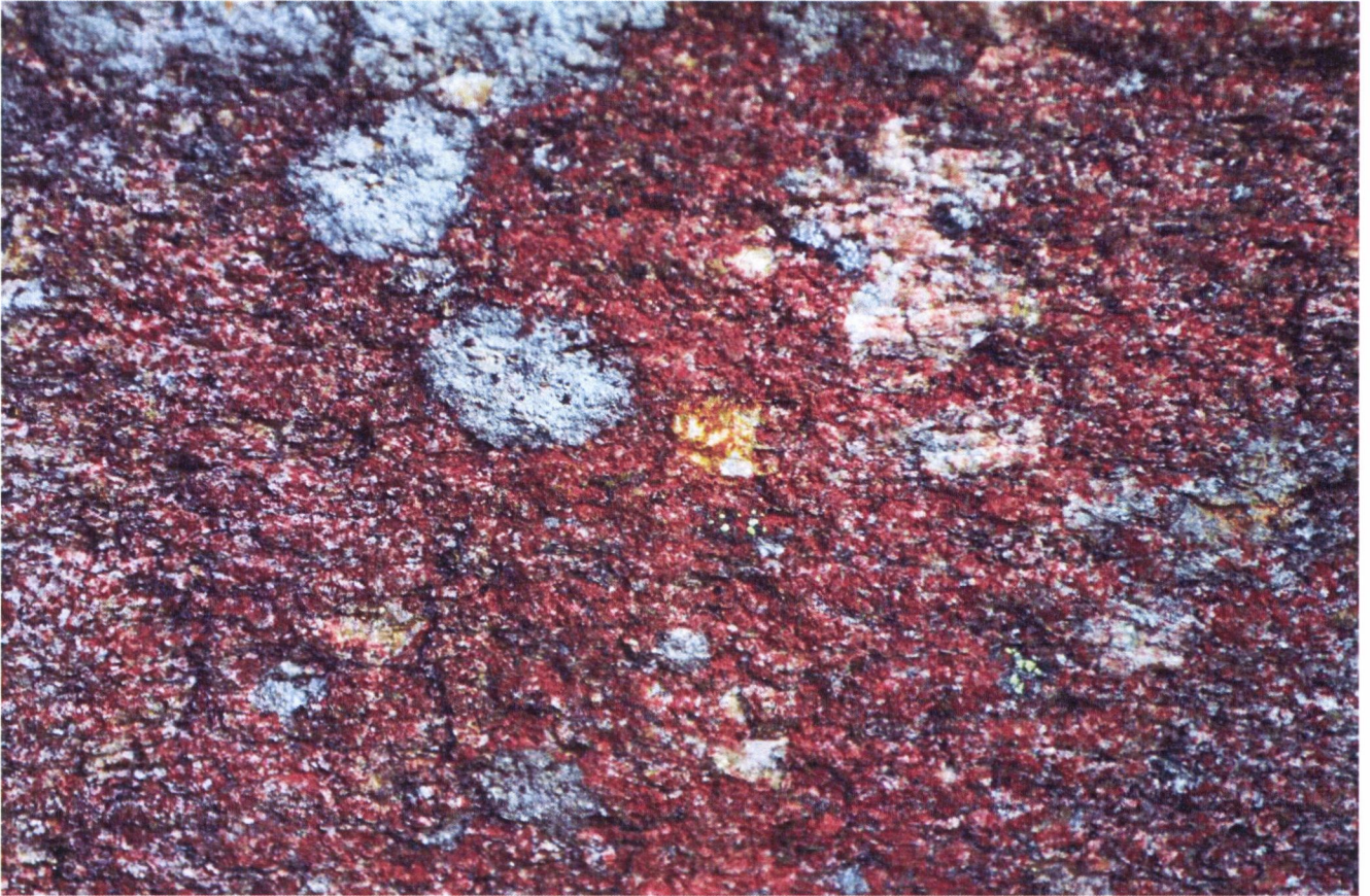
Antatt hellemaleri med prøveuttak, merk den gule fargen under prøveuttaket, trolig er dette farge av lavrotter
