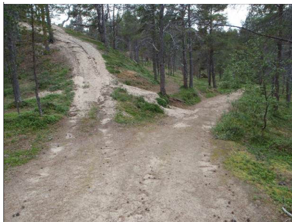
Retningsskilt mangler ved veikryss
