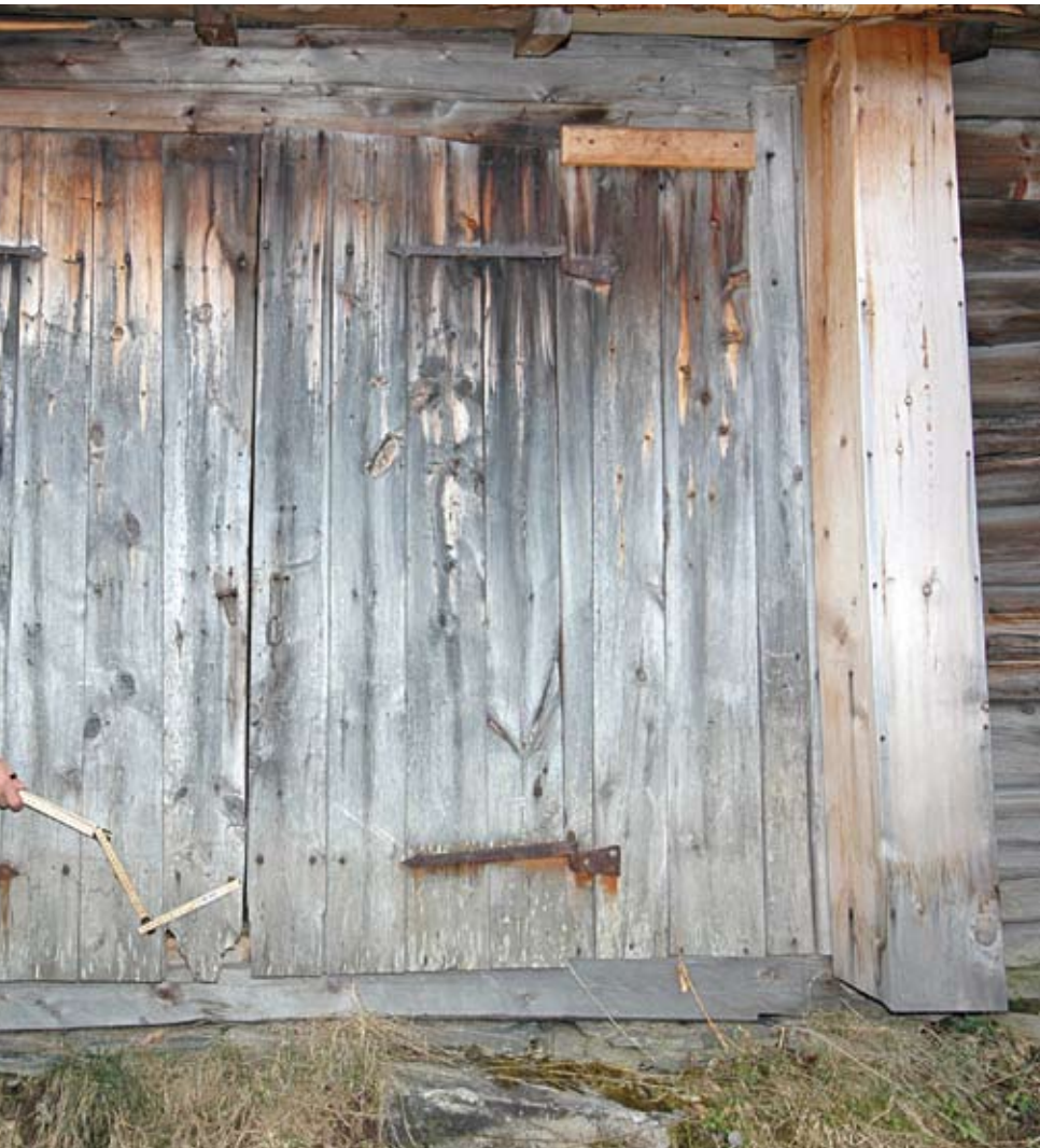
I Sør-Trøndelag er man nå godt i gang med å registrere tilstanden til de fredete bygningene. Roy Åge Håpnes kontrollerer et sauefjøs.
