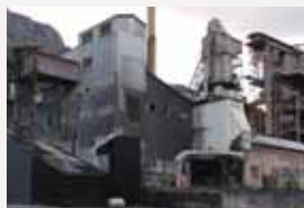
9 Fredninga av Odda smelteverk
