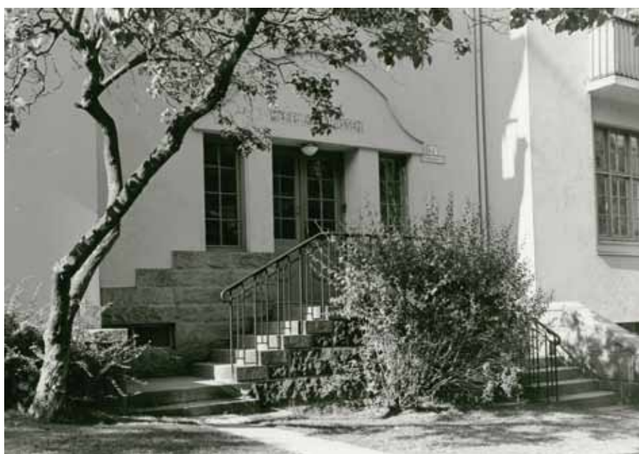
Heftyeterrassen, Inngangsparti med imitert gavlparti i nybarokk over døren. Foto: Morten Thorkildsen © Riksantikvaren
