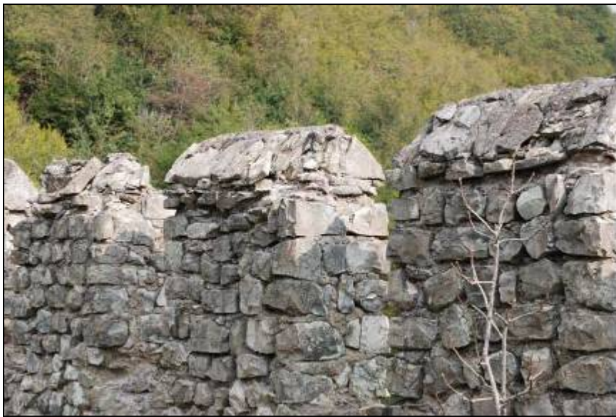
დაშლილი ცემენტი - IV საუკუნის აღდგენილ ქონგურებიან კოშკზე
