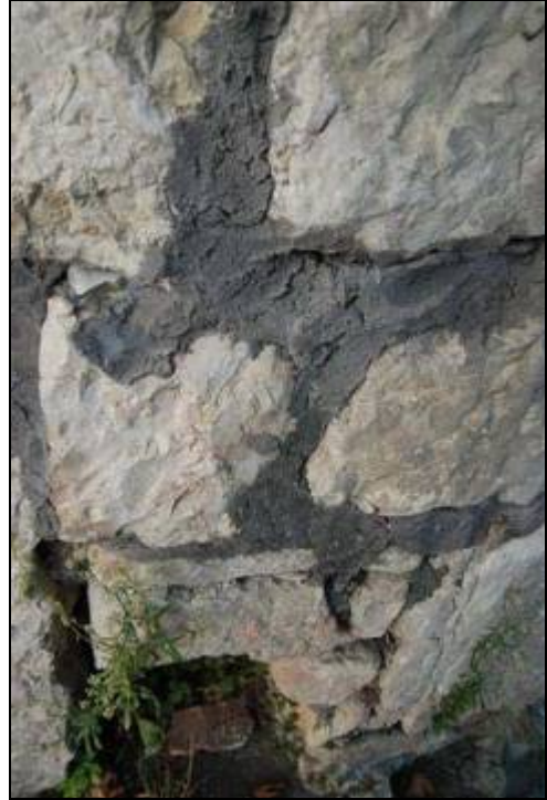
VI საუკუნის სამეფო აბანოს შესასვლელი. ტექნოლოგიურად ცუდად განხორციელებული ცემენტირების კვალი ვიზუალურად ჩანს
