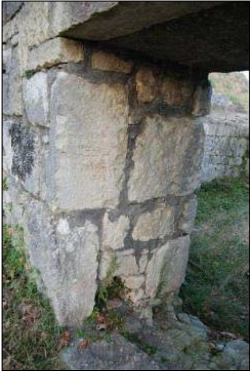
VI საუკუნის სამეფო აბანოს შესასვლელი. ტექნოლოგიურად ცუდად განხორციელებული ცემენტირების კვალი ვიზუალურად ჩანს
