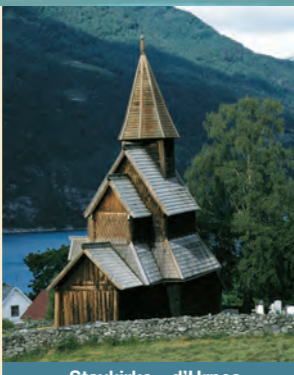
Stavkirke à Urnes
