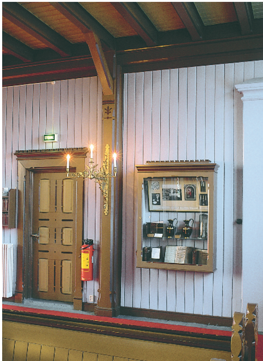
I Grimstad kirke ble det i 1993 laget utstillingsmontere med utgangspunkt i kirkens meget gjennomførte og fine detaljering. Plassforholdene tillot ikke dører til å stenge for dagslys, men rett innenfor glasset ble det montert en rullegardin som betjenes med en snor som henger ned på undersiden. Bemalingen er nøye tilpasset kirkens opprinnelige og raffinerte fargesetting som preger hele interiøret forøvrig. Historiske gjenstander og fotografier har fått sin plass i to montere bakerst i kirken, mens to gamle messehogler i hver sin monter flankerer døren fra våpenhuset til kirkeskipet. Foto: Tore Knutsen, Ibsenhuset og Grimstad Bymuseum 1997.
