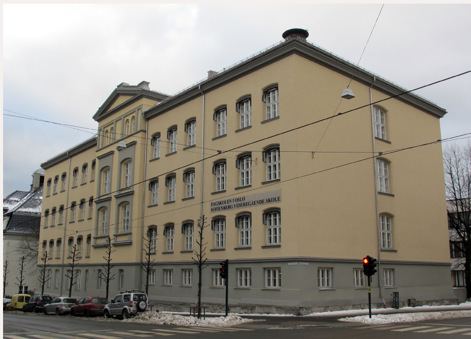
Denne murbygningen har fått utvendig etterisolering på de deler av fasadene som ikke har dekor-elementer. Midtgavlen har omramminger og trekninger som ville gått tapt ved utvendig etterisolering av denne delen. Sofienberg fagskole i Oslo. Foto: Marte Boro © Riksantikvaren
