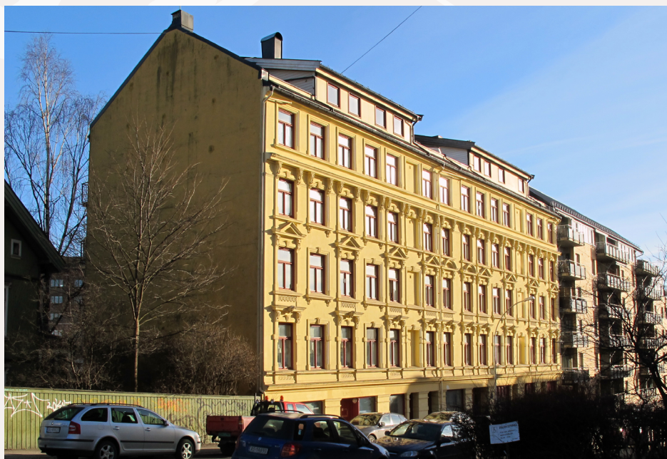
Murgård med rikt dekorert fasade. Den ene gavlen ligger fritt og egner seg godt til utvendig etterisolering. Foto: Marte Boro © Riksantikvaren
