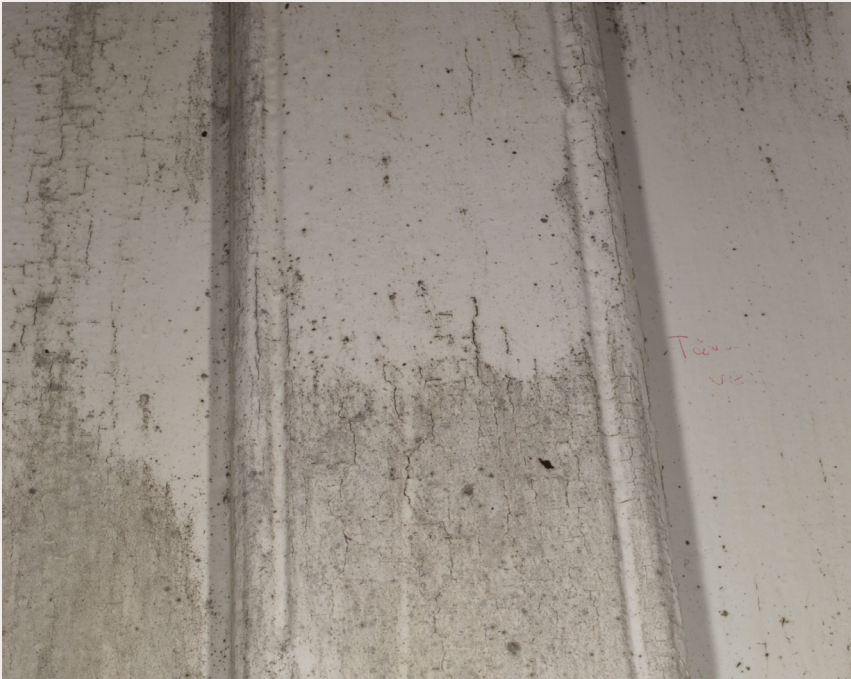
Svertesopp brer seg ofte ujevnt utover malte overflater. I dette tilfellet spiller trolig forskjeller i sprekkdannelse i malinglaget en rolle. Foto: © Mycoteam
