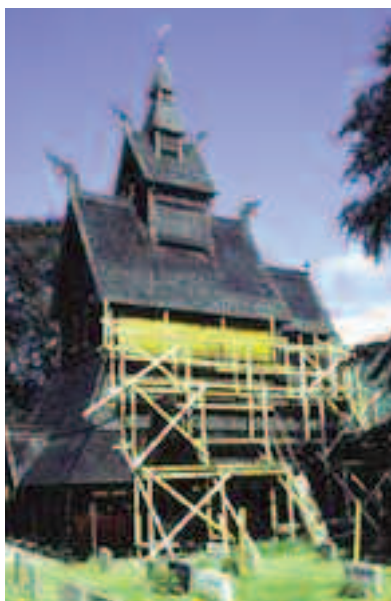
Til venstre: Tjærebreing av Hopperstad stavkirke. Det gjenstår å tjærebre sydveggen på hevet midtrom. Det er en tydelig forskjell på før og etter behandling. Til høyre: Viser samme vegg under tjærebreing. Foto: I. M. Egenberg.
