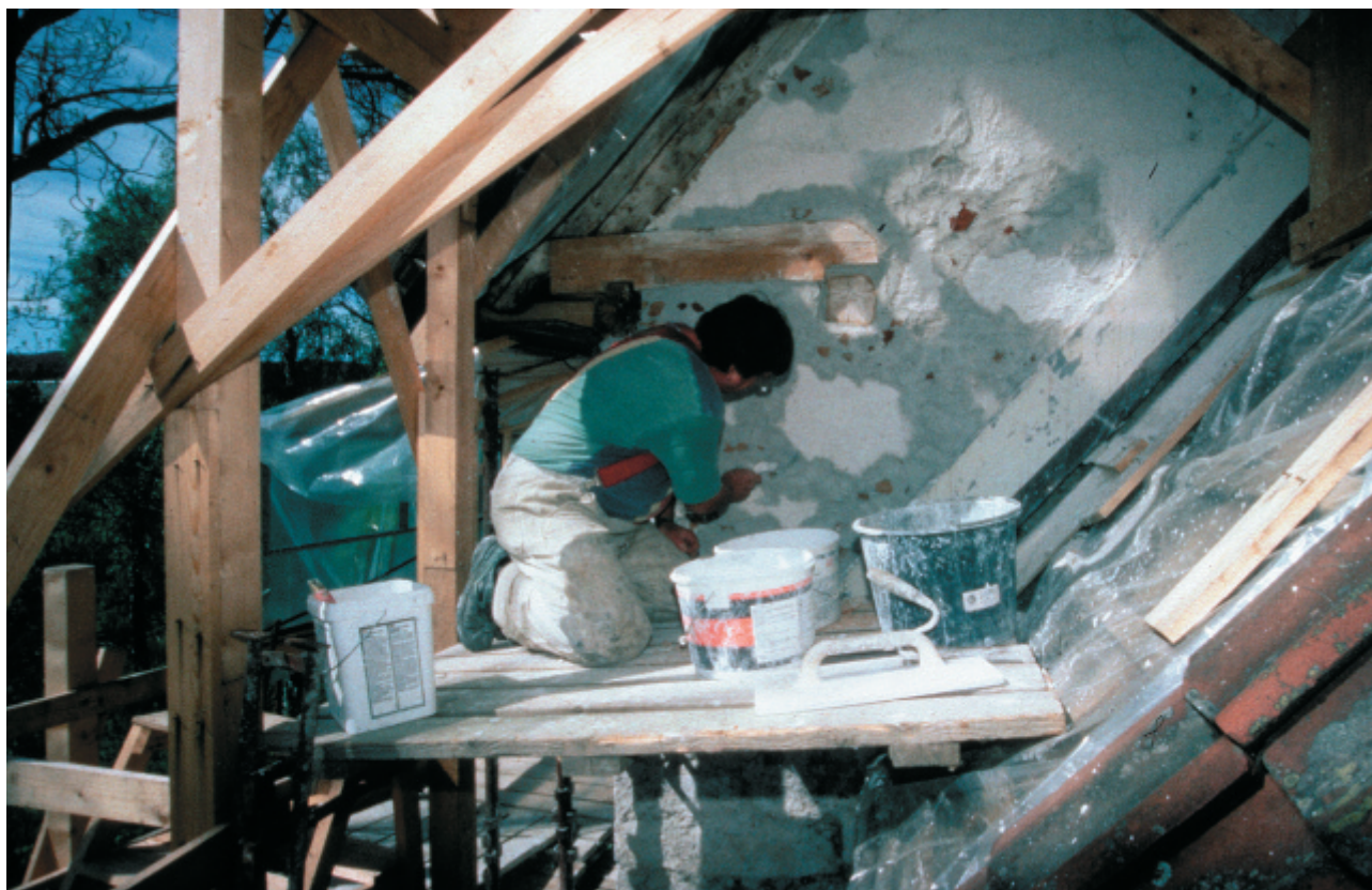
Kalkpuss påføres på Skoger gamle kirke. Foto: Geir Erik Bardalen
