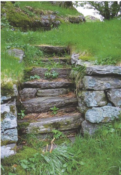
I hager i bratt terreng vil man ofte ty til bakkemurer for å få flate steder for dyrking og opphold. Kjenner man de gamle teknikkene, kan selv tørrmurer bli stående i årevis. Denne fine, gamle hagemuren og trappen i Gulen i Sogn har stått innpå hundre år uten store reparasjoner. Murtradisjonene våre er vel verd å ta vare på. Foto: Mette Eggen, Riksantikvaren
