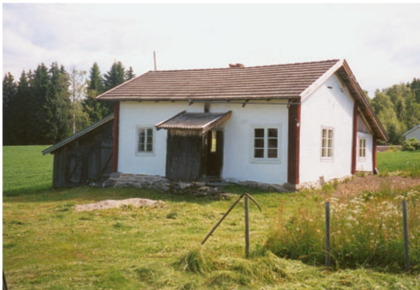
1920-tallets fredninger av hus på landsbygda omfattet storgårder, med hovedvekt på anlegg i dalførene på Østlandet. Tiden var ikke moden for å dokumentere husmennenes boliger og levekår. Av de få husmannsplassene som er bevart, finner vi Hesthagen, Ringsaker i Hedmark, som i dag (2001) er under fredning. Stuebygningen er oppført i rippet tømmer. Foto: Toril Sættem Vestad. Riksantikvaren.
