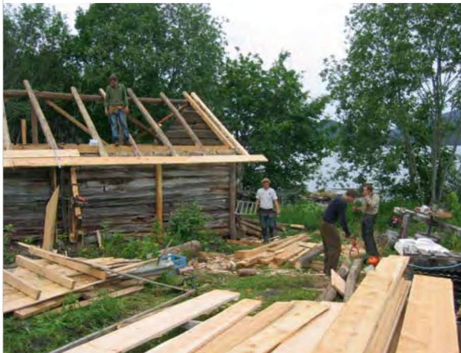
Næminger i arbeid på Prestegårdsnaustet.
