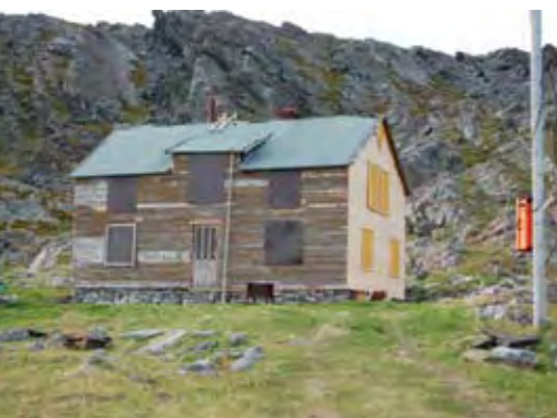
Restaurering: Ramberghuset er istandsatt, Holmenhuset under arbeid.
