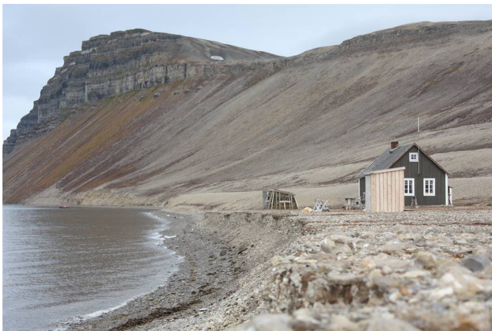
Figur 2. Kystnære bygninger i Norden er blant annet truet av kysterosjon. Bildet viser eksempel på kysterosjon på Svalbard. Fangststasjonen Fredheim består av fire mindre bygninger og rester etter to båter. Båtene ble knust til pinneved av et stort isflak/isfjell som strandet på stranden en sommerdag i 1996. Raskanten/strandbrinken brytes stadig ned og avstanden fra hovedbygningen til raskanten har minsket med 11 m i perioden 1990 – 2009. Foto: Anne-Cathrine Flyen, NIKU.
